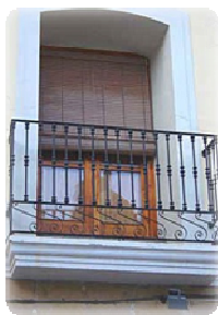
antepechado y en voladizo
