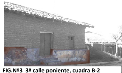
FIG.Nº3 3ª calle poniente, cuadra B-2
