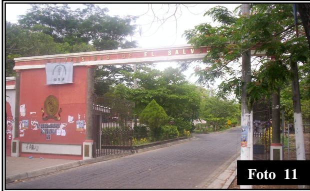
El acceso principal que muestra la imagen 11 está ubicado en una de las entradas principales de la facultad.
