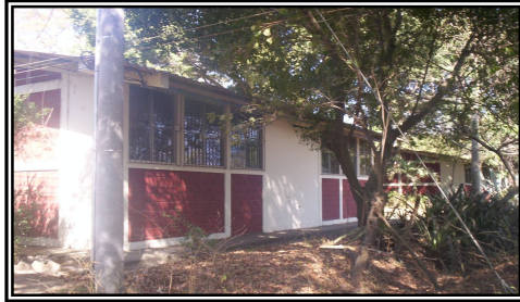
El departamento de agronomía construido de un solo nivel es de las edificaciones antiguas de la facultad, se puede apreciar su sistema constructivo a base de ladrillo de obra.
