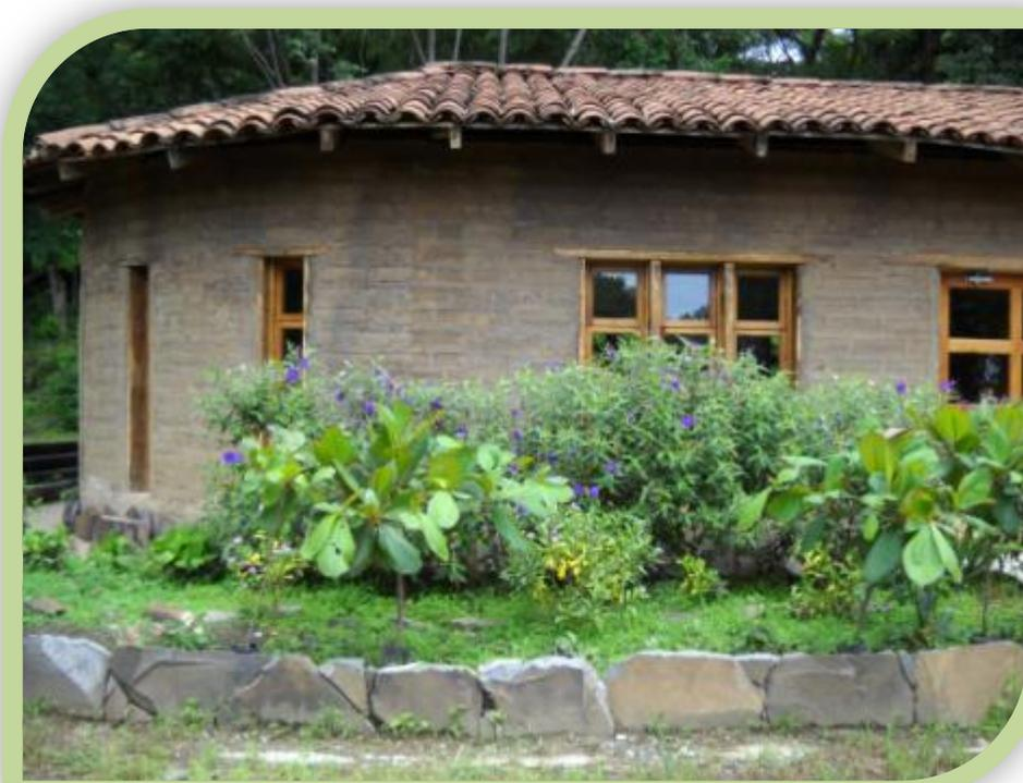
Imagen 1 y 2. Vivienda en la geotérmica de Berlín con materiales como adobe en paredes, una estructura de madera, un techo de teja y un piso de piedra laja.
