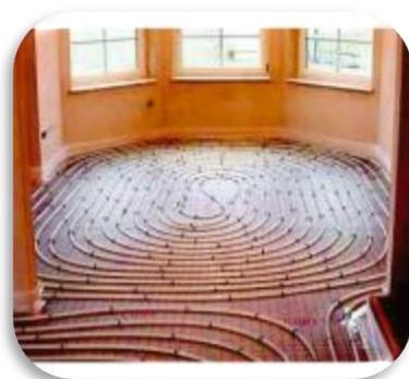
Suelo Radiante: Sistema de calefacción eléctrico o de calefacción por agua caliente que emite el calor por la superficie del suelo. En los sistemas por agua el calor se produce en la caldera y se lleva mediante tuberías a redes de tuberías empotradas bajo el pavimento de los locales.
