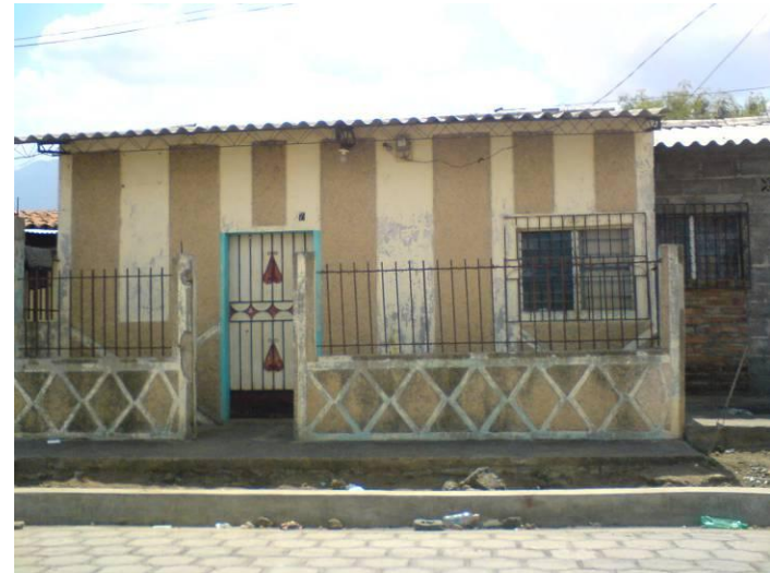
En la foto se observa el tipo de construcciones de la zona
