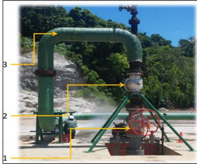
Figura 7. Válvula de cabezal y línea (sacrificio) de pozo geotérmico 1) Válvula maestra; 2) Válvula de proceso (sacrificio); 3) Tubería de acarreo de flujo bifásico ( Fuente: Flamenco, 2018 ).
