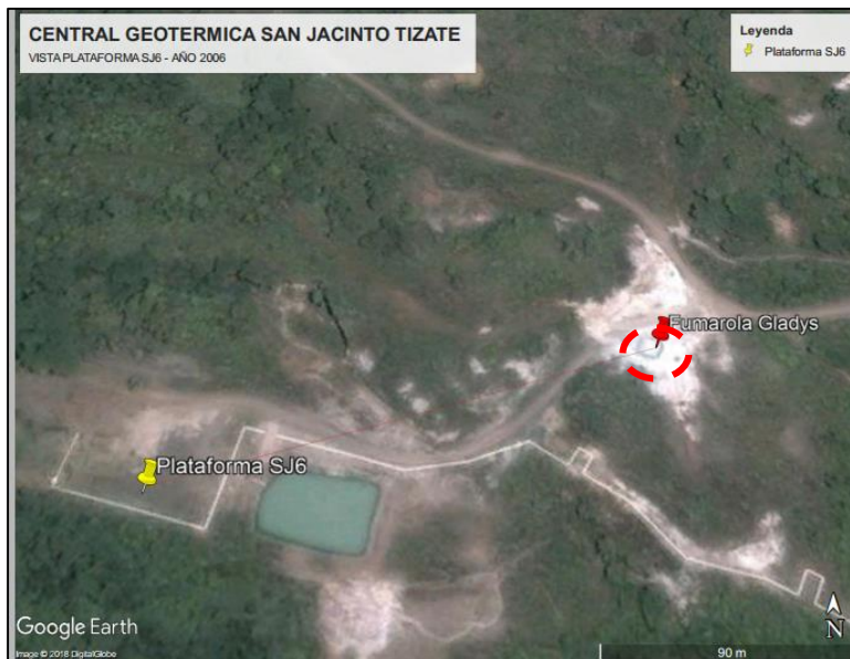
Figura 13. Inicio de manifestaciones alrededor de plataforma y fumarola a 200 metros NE (Fuente: Google Earth, 2006)
