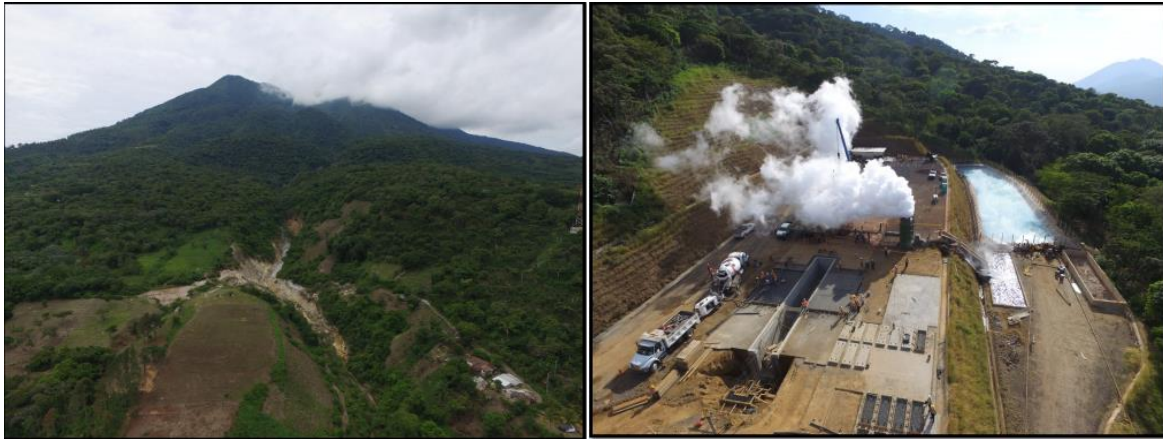
Figura 1. Sitios y obras civiles durante la construcción de una plataforma geotérmica (Mayorga, 2018).
