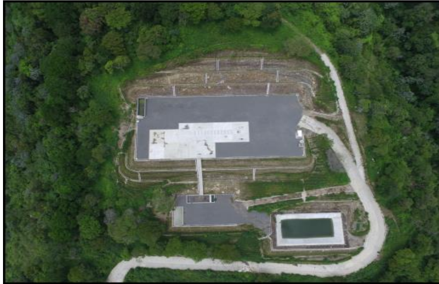
Figura 3. Plataforma de perforación luego de obras civiles ( Fuente: Mayorga, 2018 ).
