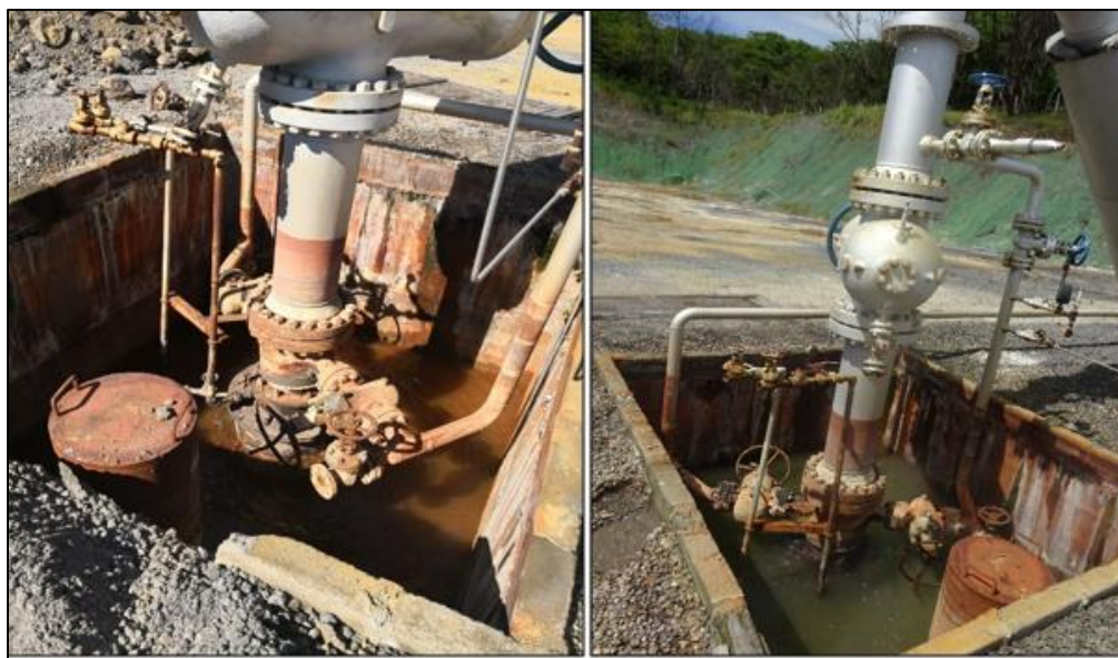
Figura 17. Acceso a plataforma SJ6 en la actualidad (Fuente: Elaboración Propia, 2018)
