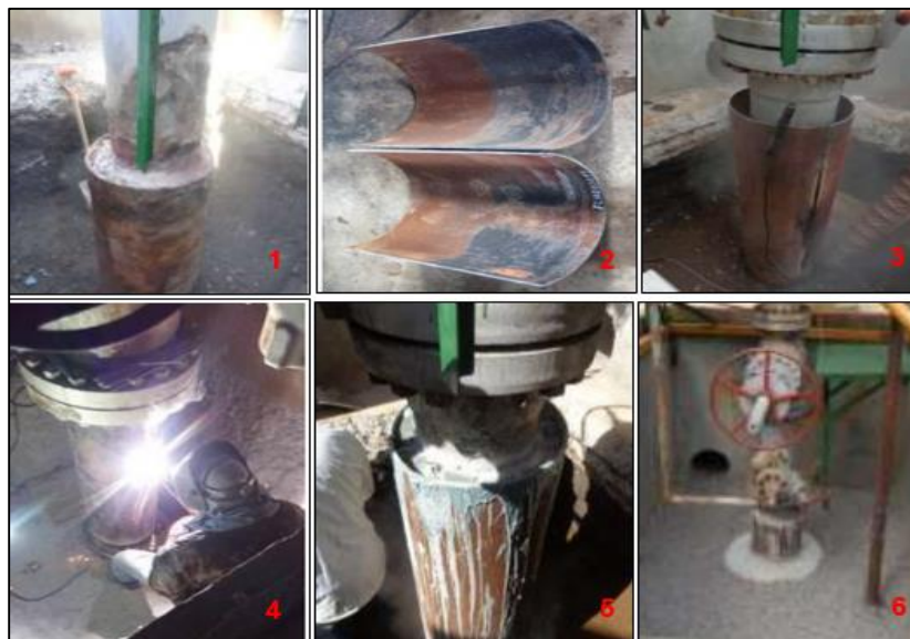
Figura 28. Secuencia de reparación de tubería conductora (Fuente: Mayorga, 2018).
