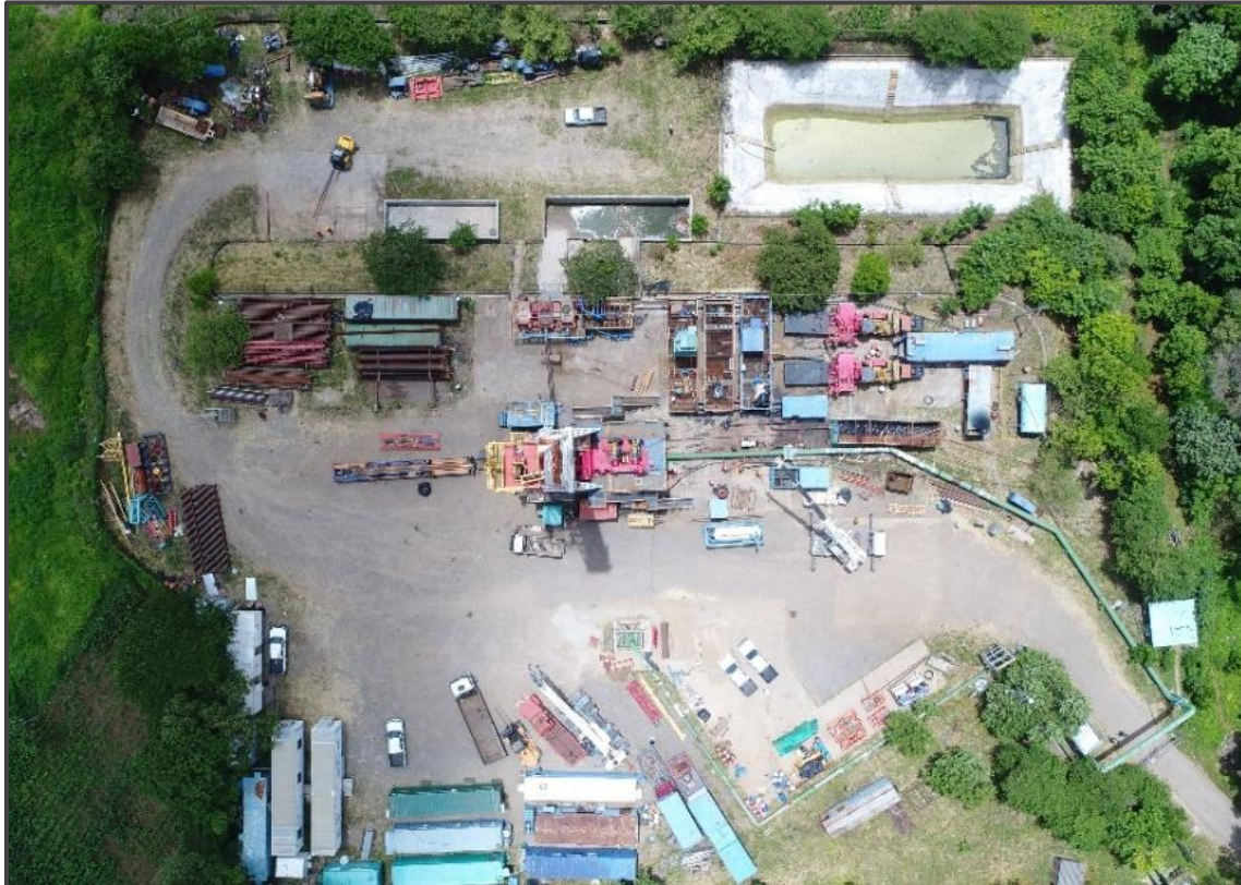
Figura 17: Plataforma de pozos existente en La Geo con espacio e infraestructura suficiente para la estimulación química de pozos
