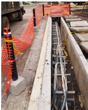
Figura 11 barricadas de protección durante operación de mantenimiento mayor.
