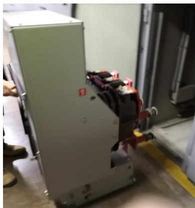
Figura 9 maniobra de extracción de interruptores de media tensión durante mantenimiento mayor.
