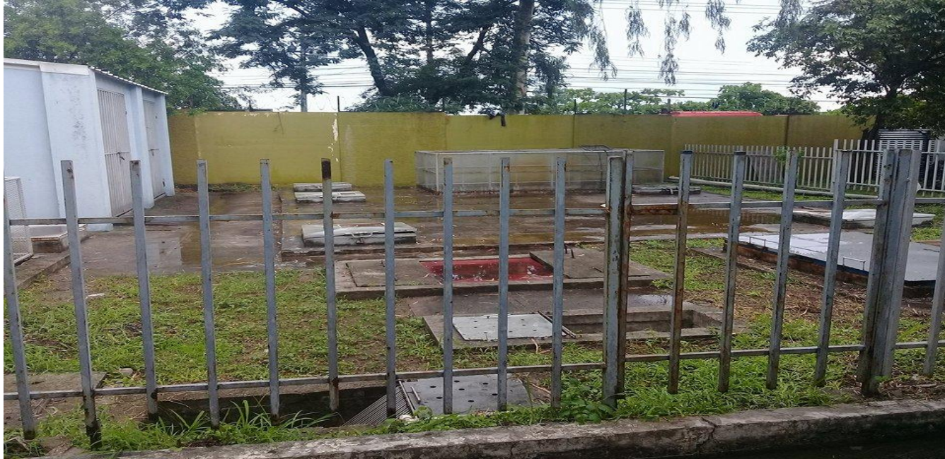
Imagen 7. Panta de tratamiento de Unidad de Especialidades.
