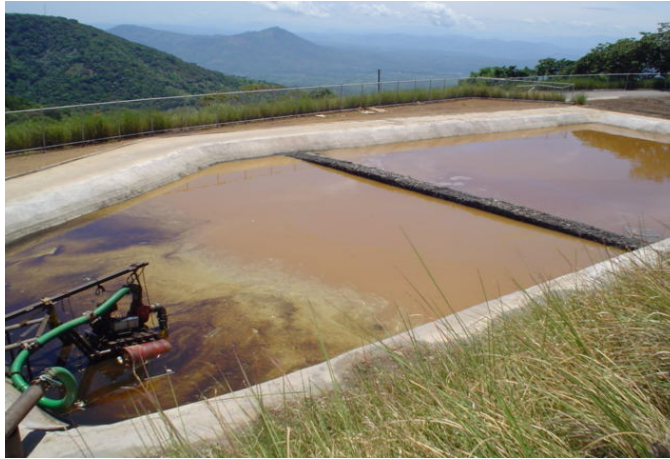
Figura 30. Pileta de lodos
