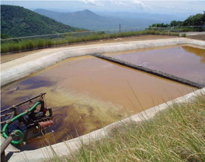
Figura G3. La pileta de lodos se encuentra contiguo a la plataforma de perforación, construida con materiales resistentes para prevenir en la medida de lo posible las fracturas de la estructura. En el diseño de la pileta se ha considerado una sección para recolección de otros desechos sólidos menores, los cuales son retenidos por medio de un "filtro" de grava.
