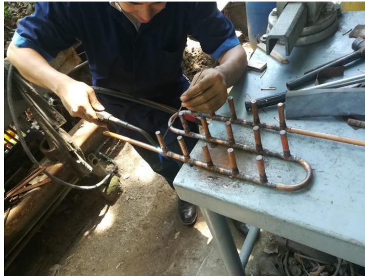
Figura 31. Aplicación de soldadura oxiacetilénica. Fuente: imagen propia.
