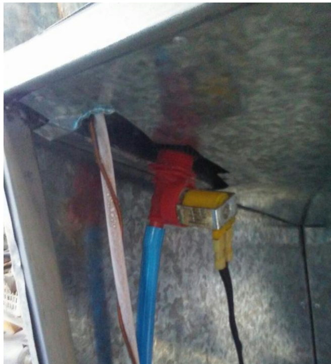
Figura 37. Constituyentes del sistema de suministro de agua. Fuente: imagen propia.
