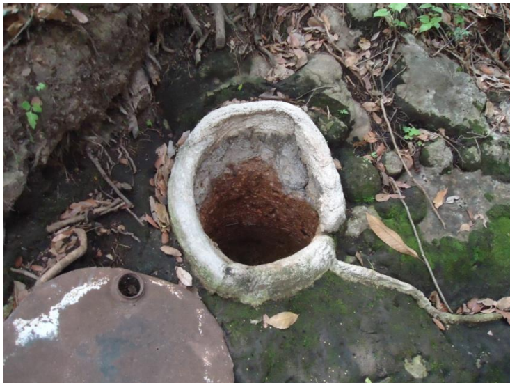
Fig. 10 Pozos de poca profundidad (50 cm) conocidos en la comunidad como los pocitos.
