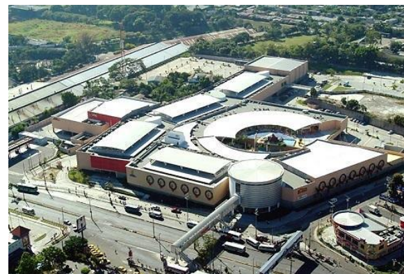
Imagen N°23. Vista Centro Comercial Plaza Mundo
