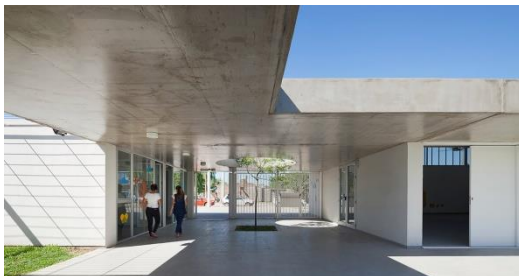
Imagen N° 66. Amplios pasillos. Fuente: https://www.plataformaarquitectura
