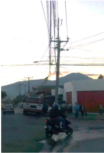
Fotografía N°38. Contaminación visual, cableado eléctrico, propaganda, en la zona del C.D.I. María Auxiliadora Fuente: Creación propia
