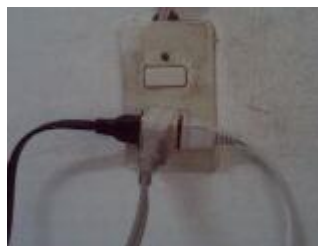
Figura 47: Tomacorriente sobresaturado
