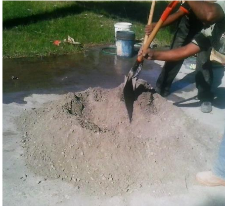
Figura 3.17: Mezcla del concreto
