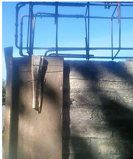
Figura 3.24: Encofrado de los nervios
