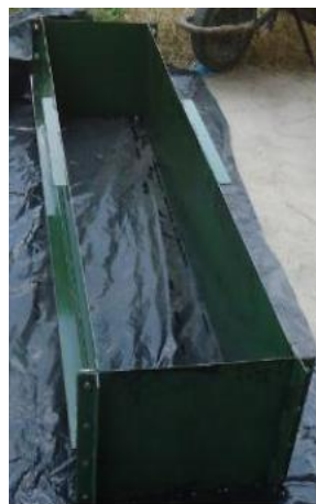
Figura 3.14: Moldes metálicos para las soleras de fundación
