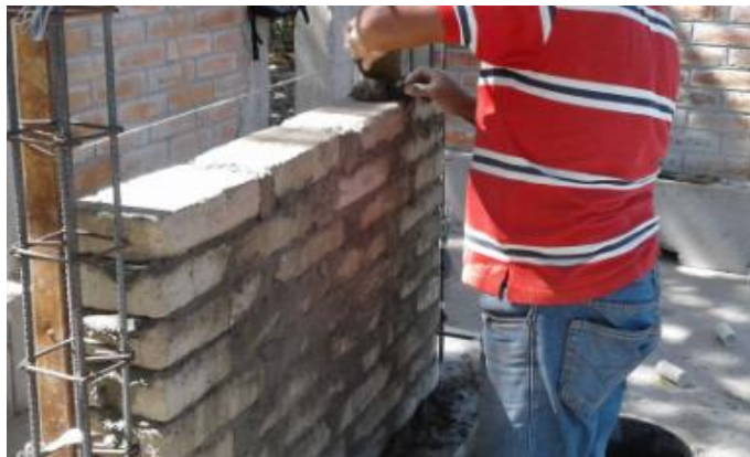
Figura 3.21: Pegado de los ladrillos
