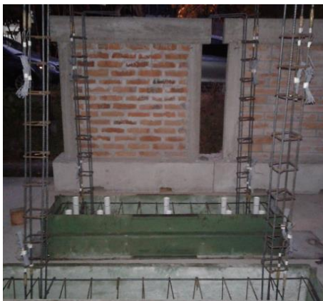
Figura 3.16: Armaduras para los nervios
