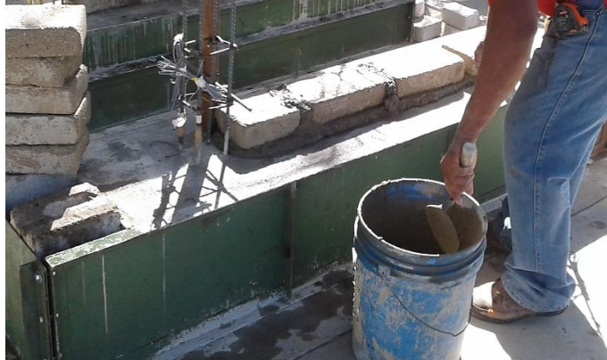
Figura 3.20: Colocación de la primera hilada de ladrillos
