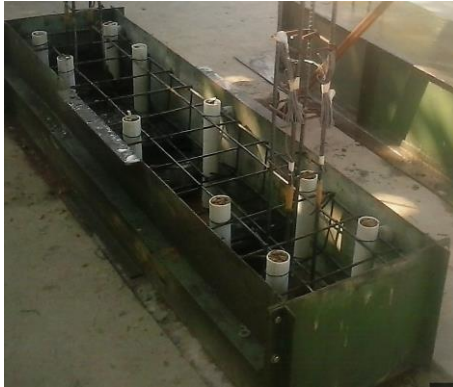
Figura 3.15: Tubos de PVC en el acero de refuerzo
