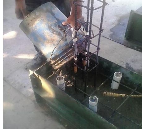
Figura 3.18: Colado de las soleras
