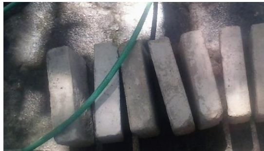
Figura 3.19: Preparación de los ladrillos de suelo-cemento
