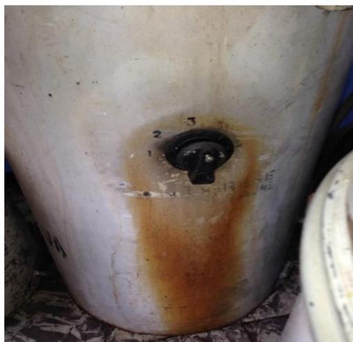
*Figura III.12. Fuga de aceite por accesorio (cambiador de taps).*
