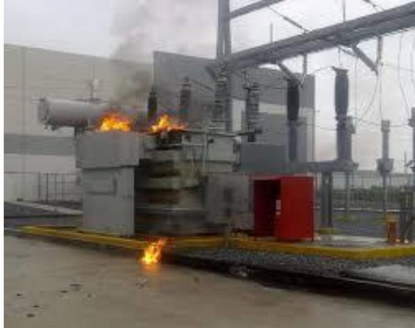
*Figura III.5. Transformador con falla asociado a bushing.*
