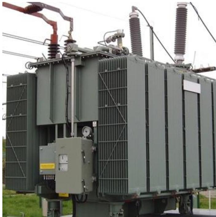
*Figura I.1. Transformador de potencia.*
