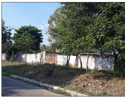
4. VISTA LATERAL EN CALLE CENTRAL - MUROS DE PROTECCION DE BLOQUE DE CONCRTEO Y LAMINAS.
