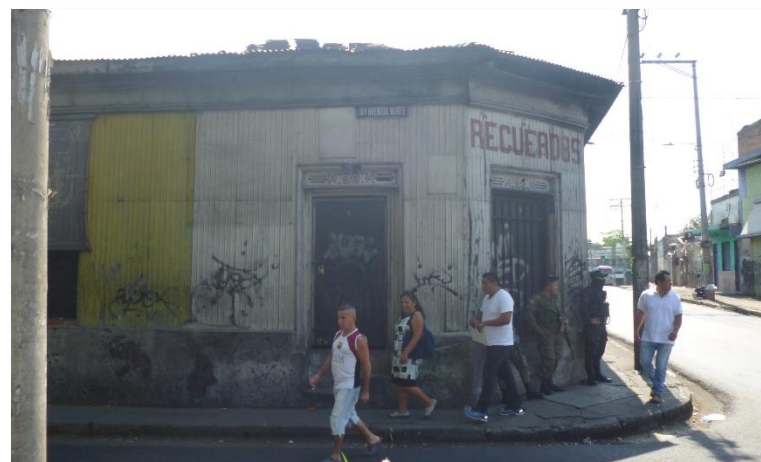
FOTOGRAFÍA 7: Inmueble 15, manzana T-8. Fuente: Galería de los autores (2018).
