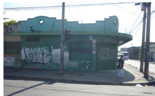
FOTOGRAFÍA 9: Situación actual de inmueble ubicado en el barrio concepción donde se observa el deterioro Fuente: Galería autores (2018).
