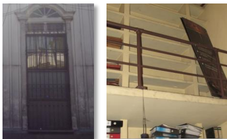
FOTOGRAFÍA 35: Vista de balcones exteriores y barandal mezzanine. fuente: galería autores.
