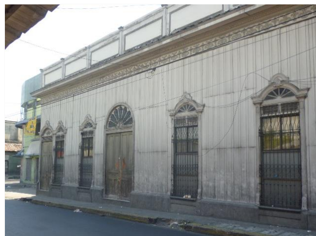
FOTOGRAFÍA 31: Vista de fachada oeste de inmueble en estudio. Fuente: Galería de los autores.
