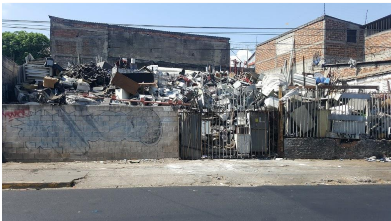
FOTOGRAFÍA 17: Inmueble 3, manzana G-3. Fuente: Galería de los autores (2018).
