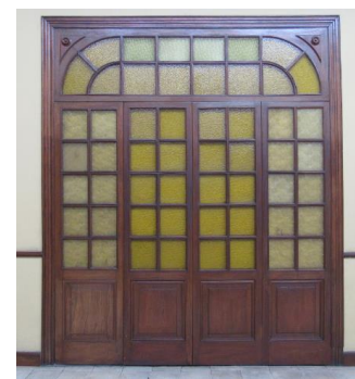
FOTOGRAFÍA 43: Vidrio esmerilado en puertas de madera. Fuente: Galería autores.
