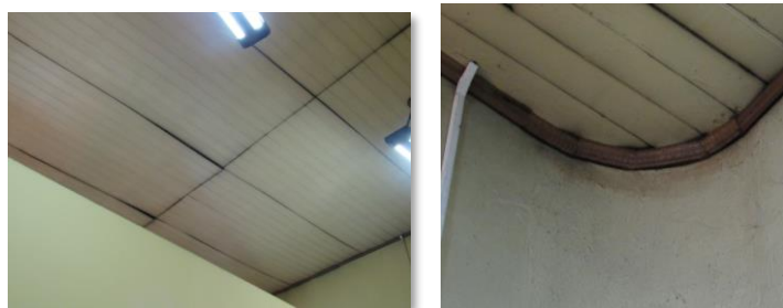
FOTOGRAFÍA 44 : Cielo falso de madera y molduras que lo enmarcan. Fuente: galería autores.
