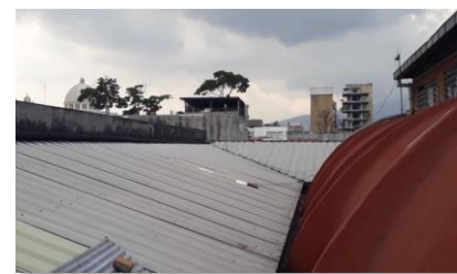
FOTOGRAFÍA 46: Vistas de cubiertas de primer nivel. Fuente: Galería autores.
