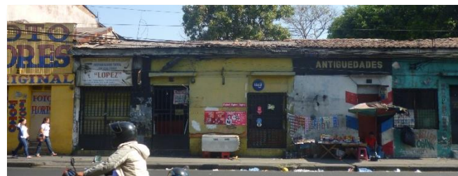
FOTOGRAFÍA 11: Inmuebles 14 y 13 de manzana G-3. Fuente: Galería de los autores (2018).
