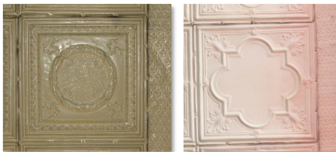
FOTOGRAFÍA 45: Diseños de lámina troquelada, cielo falso. fuente: Galería autores.
