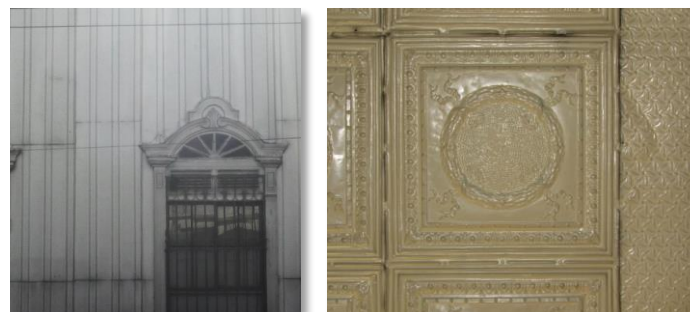
FOTOGRAFÍA 37: Muestra de lámina en fachada y cielo falso. Fuente: Galería Autores.
