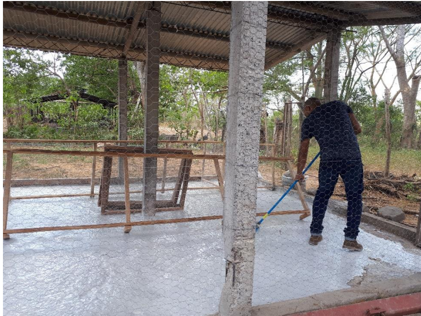
Figura A 4. Reparación y limpieza de galera.
