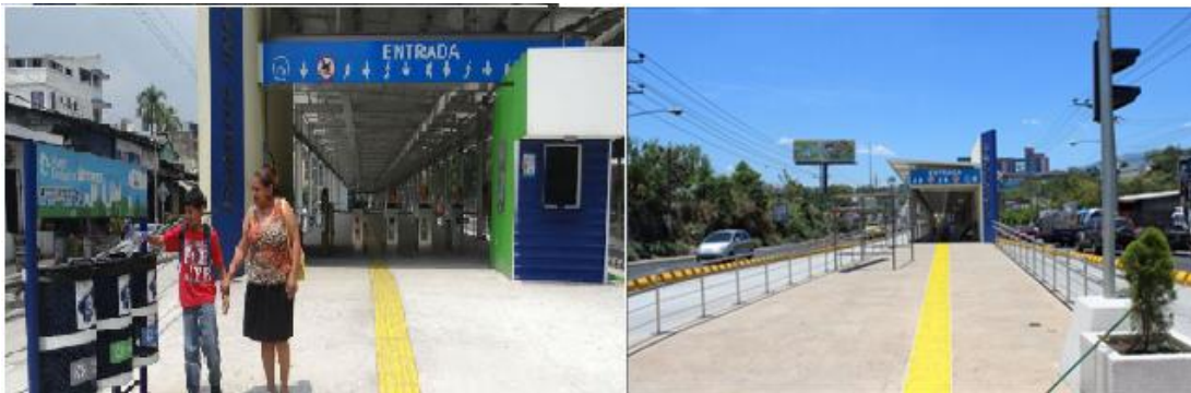
Ilustración 17 componentes de estaciones (semáforos, señalización, pasamanos y puntos ecológicos)
