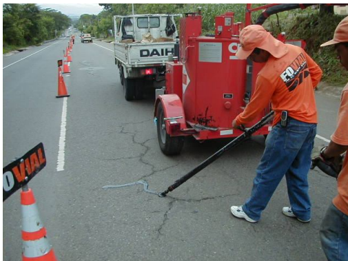
Fig. 3.30a Colocación del material sellante dentro de la grieta o fisura
