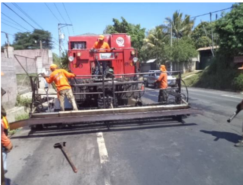
Fig. 3.26c Preparando instalación de la caja esparcidora en la maquina mezcladora/aplicadora
