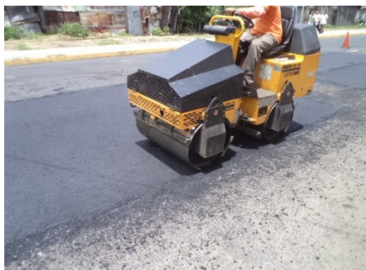
Fig. 3.33b Compactación de la mezcla
