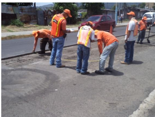
Fig. 3.23b Medición del bache, para la obtención del volumen a utilizar
