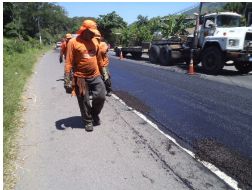
Fig. 3.37c Acabado final luego de nivelar las zonas irregulares
