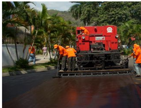
Fig. 2.8 Lechada asfáltica en vía urbana
