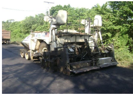
Fig. 2.4 Colocación de mezcla asfáltica sobre riego de liga
