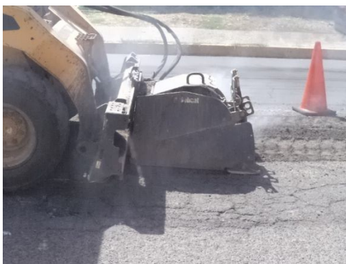
Fig. 3.16b Fresando el área del deterioro
