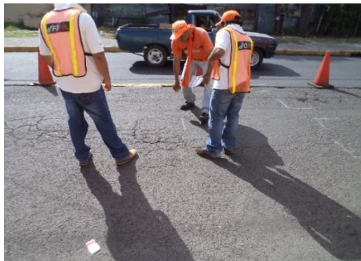
Fig. 3.14c Revisión de la vía
