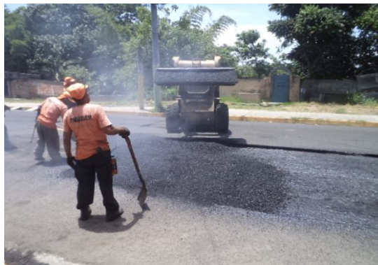
Fig. 3.27b Colocación de la mezcla en el bache
