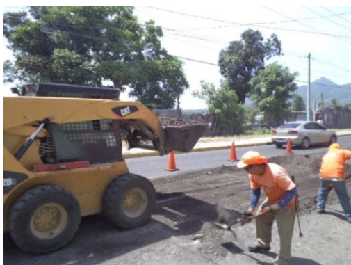
Fig. 3.21b Limpieza del bache, utilizando palas, piocha y carretillas
