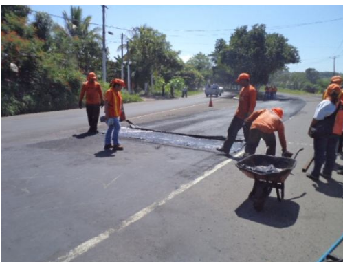
Fig. 3.39c Cubriendo la parte final de la capa de micro-pavimento
