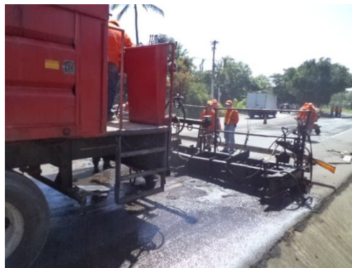
Fig. 3.25c Preparando instalación de la caja esparcidora en la maquina mezcladora/aplicadora
