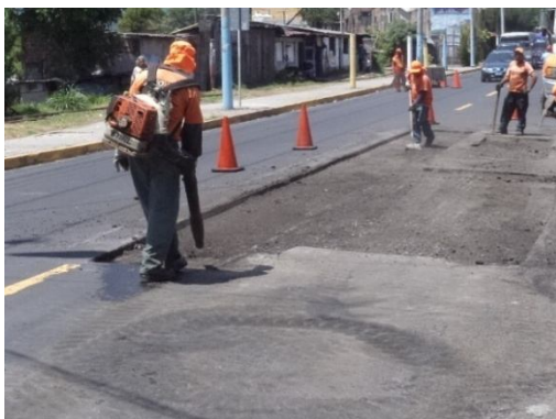
Fig. 3.22b Limpieza del bache, utilizando atomizadoras
