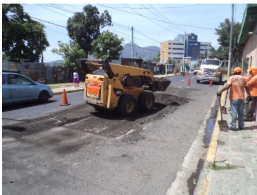
Fig. 3.20b Limpieza del bache ,utilizando el bobcat
