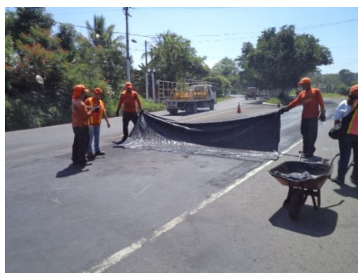
Fig. 3.38c Cubriendo la parte final de la capa de micro-pavimento
