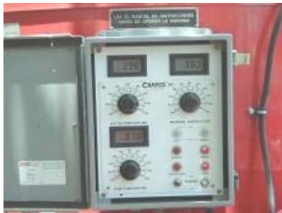
Fig. 3.28a Verificación de la temperatura de calentamiento
