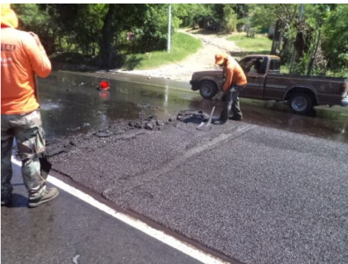
Fig. 3.32c Delimitación de la zona de finalización de capa de micro-pavimento
