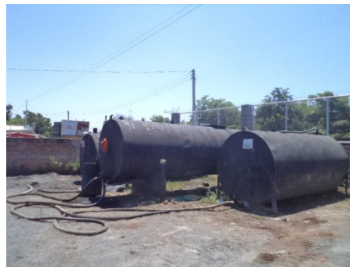
Fig. 3.23c Tanques de almacenamiento de mulsión y agua
