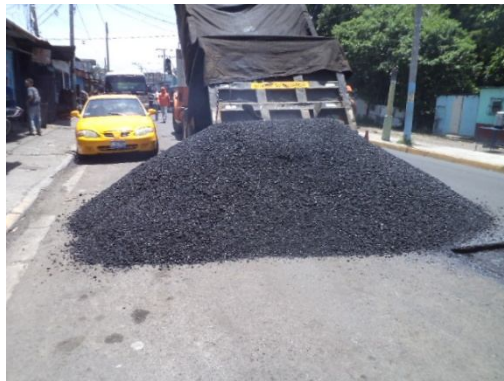
Fig. 3.12b Mezclas asfáltica antes de ser colocada
