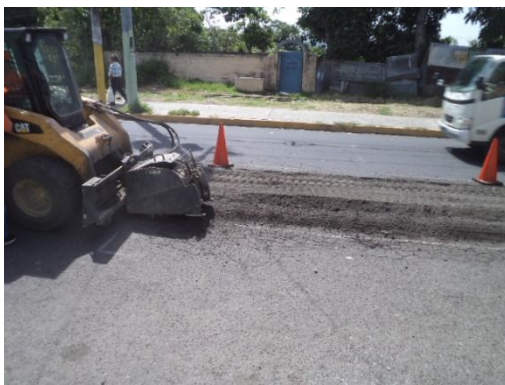
Fig. 3.17b Fresando el área del deterioro
