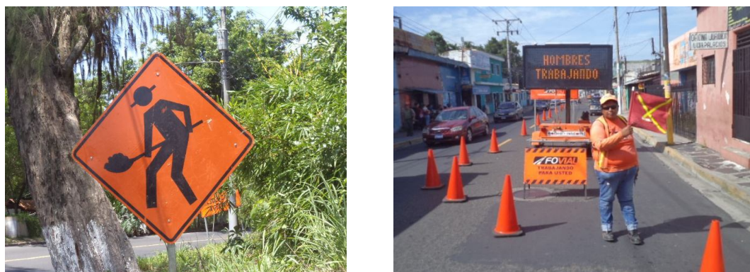
Fig. 3.19c Colocación de los dispositivos de señalización y seguridad
