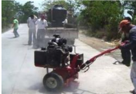
Fig. 3.18a Ampliando la grieta o fisura con sierra mecánica
