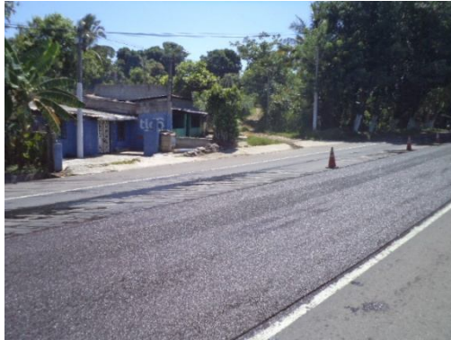
Fig. 3.34c Revisión luego de que pasa la maquina mezcladora/aplicadora
