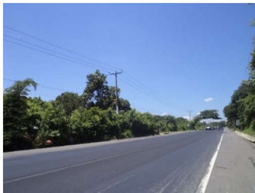
Fig. 3.16c Nivelación de superficie
