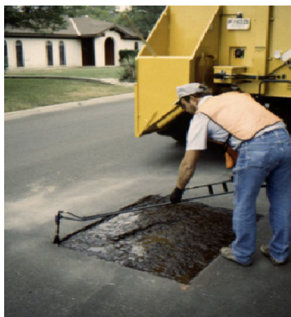
Fig. 3.25b Riego de liga en el bache
