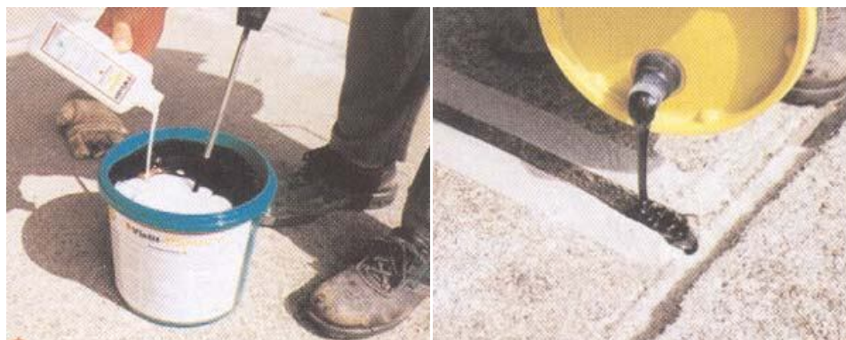
Fig. 3.9a Material sellante aplicado manualmente en estacionamientos y juntas de pavimentos de asfalto y concreto.
