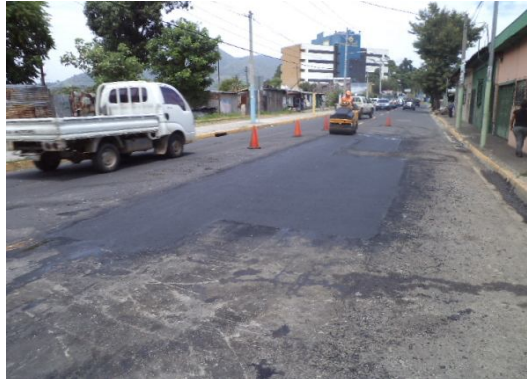
Fig. 3.34b Compactación de la mezcla con rodillo liso vibratorio
