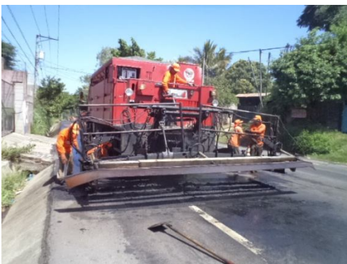
Fig. 3.27c Maquina mezcladora/aplicadora lista para aplicar el micro-pavimento
