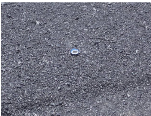
Fig. 3.31b Medición de la temperatura de la mezcla para ser compactada
