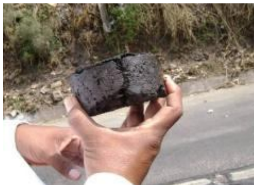
Fig. 3.34a Chequeo de la adherencia del material sellante
