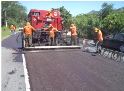
Fig. 3.30c Colocando el micro-pavimento
