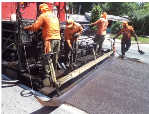
Fig. 3.29c Colocando el micro-pavimento
