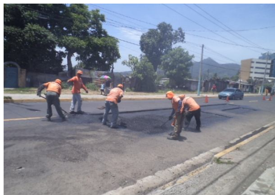
Fig. 3.29b Extendiendo la mezcla en el bache
