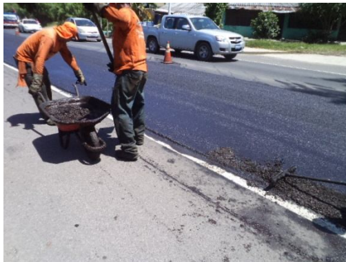
Fig.3.35c Colocación de mezcla en zonas que presentan desnivel
