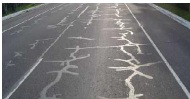
Fig. 3.35a Acabado final del pavimento
