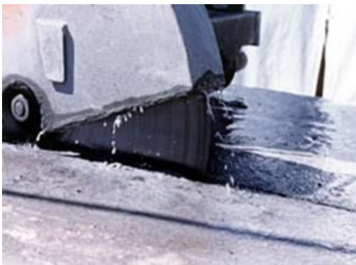
Fig. 3.18b cortando el área del deterioro con sierra eléctrica
