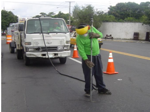
Fig. 3.21a Limpieza de grieta o fisura ,utilizando el compresor neumático
