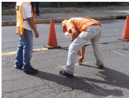
Fig. 3.15b Señalización de las áreas de los deterioros a reparar
