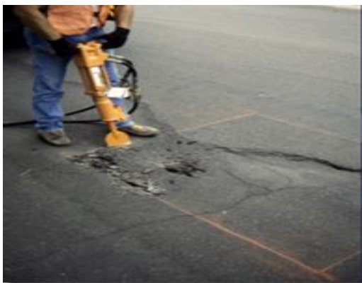
Fig. 3.19b cortando el área del deterioro con roto martillo
