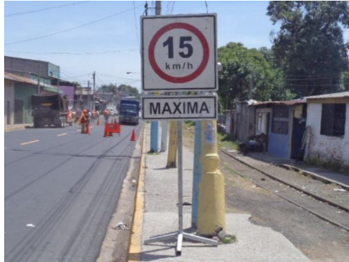
Fig. 5.12 Señal de reglamentación utilizada en mantenimiento de baches
