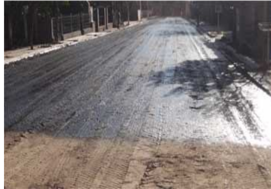
Fig. 2.3 Riego de imprimación
