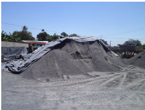
Fig. 3.10c Agregados depositados en acopio
