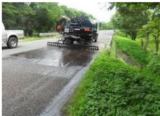
Fig. 2.5 Riego anti-polvo
