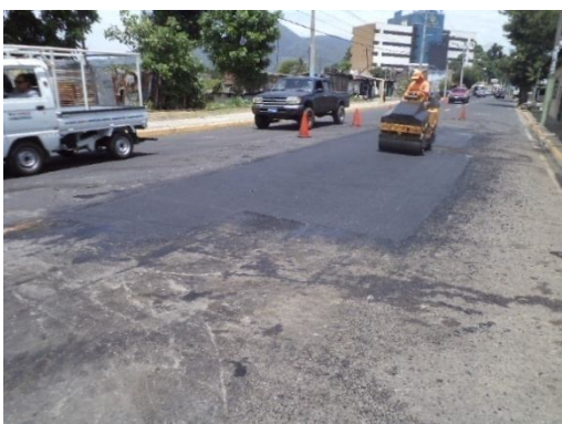
Fig.3.32b Compactación de la mezcla
