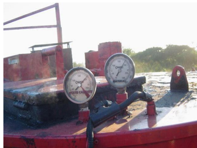
Fig. 3.29a Verificación de la temperatura de calentamiento
