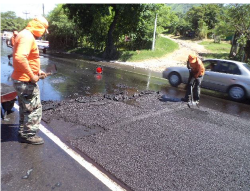
Fig. 3.33c Realizando limpieza del material sobrante
