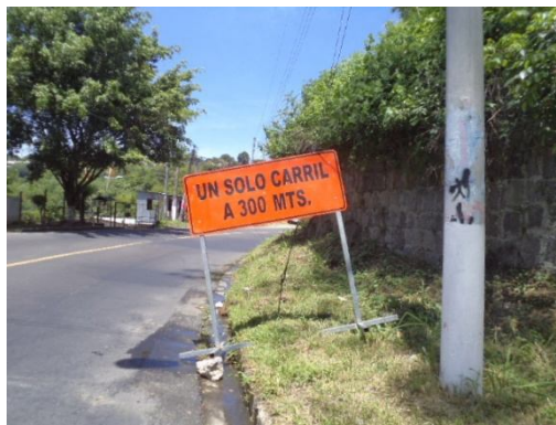
Fig. 5.20 Señal ubicada con mala estabilidad y con rocas
