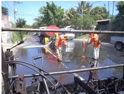
Fig. 3.21c Humedeciendo la vía
