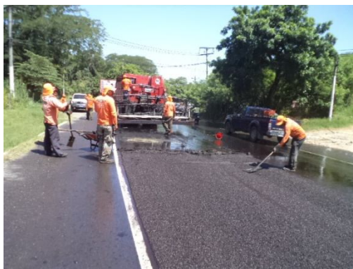
Fig. 3.31c Finalizando de colocar el micro-pavimento
