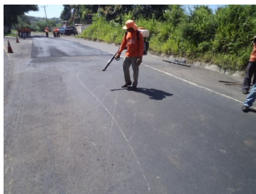
Fig. 3.20c Realizando limpieza de la vía
