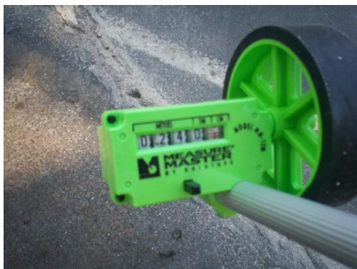
Fig. 3.23a Medición de las longitudes de las grietas o fisuras
