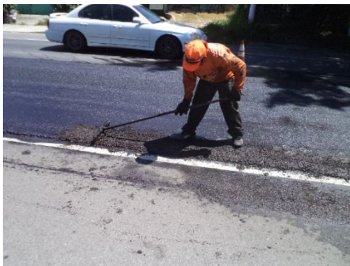
Fig. 3.36c Distribución uniforme de mezcla
