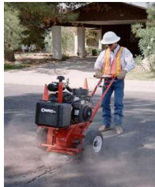
Fig. 3.19a Ampliando la grieta o fisura con sierra mecánica
