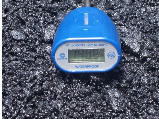
Fig. 3.26b Medición de la temperatura de la mezcla para ser colocada
