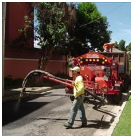
Fig. 3.25b Riego de liga en el bache
