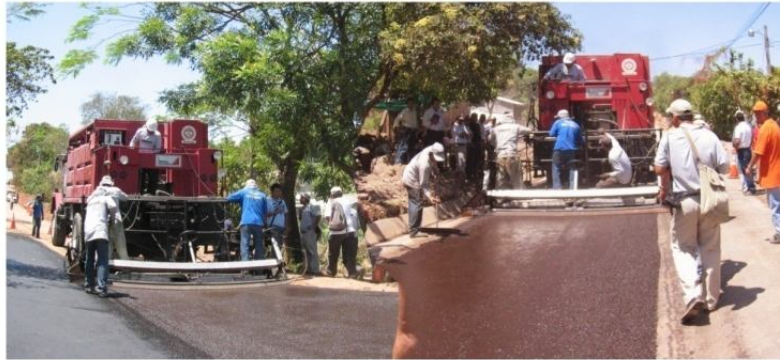
Fig. 2.7 Lechada asfáltica en camino rural
