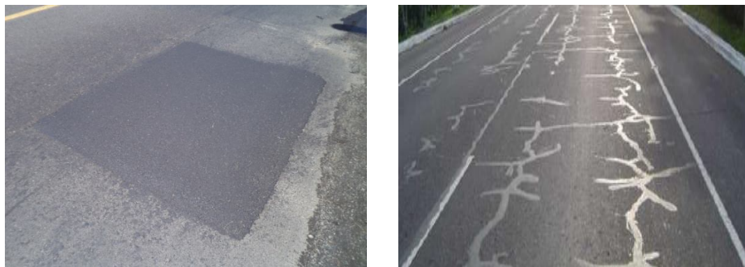
Fig. 3.15c Bacheo y sellado de fisuras
