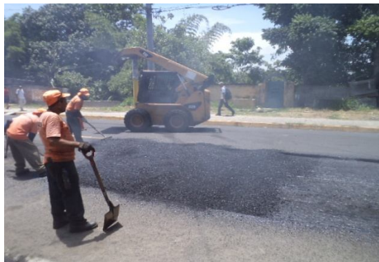
Fig. 3.28b Colocación de la mezcla en el bache
