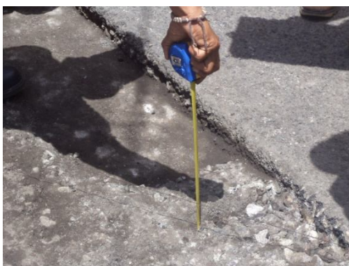
Fig. 3.24b Medición del bache, para la obtención del volumen a utilizar
