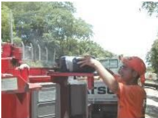
Fig. 3.25a Colocación del asfalto en el equipo de calefacción
