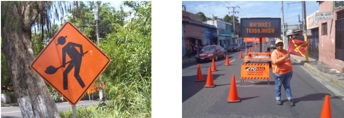
Fig. 3.14b colocación de los dispositivos de señalización y seguridad
