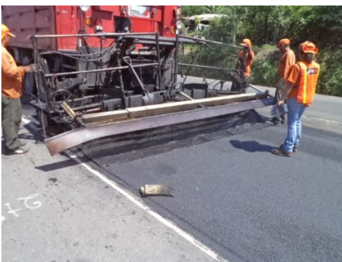
Fig. 3.40c Preparando el lugar para colocar la nueva capa de micro-pavimento
