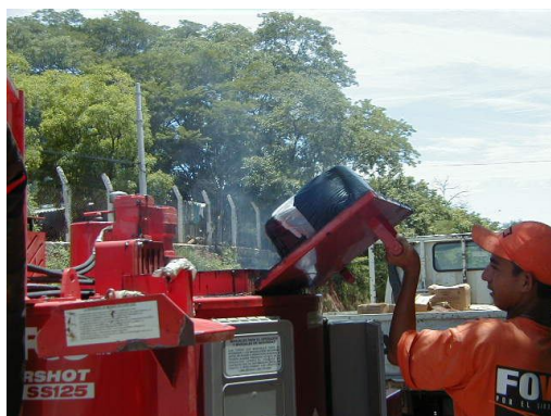
Fig. 3.26a Colocación del asfalto en el equipo de calefacción
