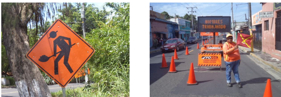
Fig. 16a colocación de los dispositivos de señalización y seguridad
