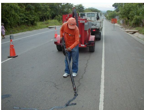
Fig. 3.31a Colocación del material sellante dentro de la grieta o fisura
