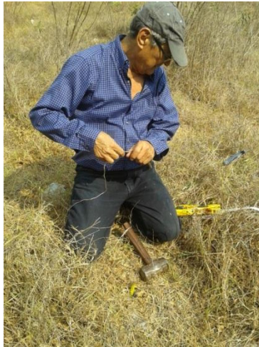
Figura No. 4.7.3 Colocación de varillas de acero corrugado que funcionarán como vértices de la cuadrícula generada en la superficie del talud.
