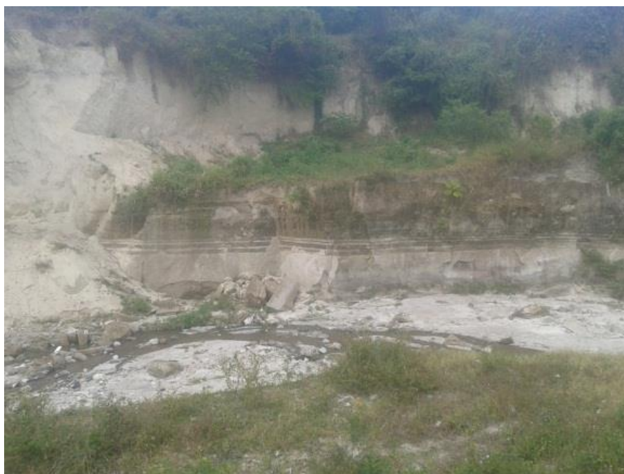
TALUD ZONA FRANCA II, 16/11/2017 Fuente: DEL AUTOR
