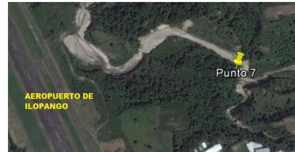
Figura No. 4.4.17 Localización de Talud Aeropuerto VI Fuente: EL AUTOR, apoyado en Google Earth
