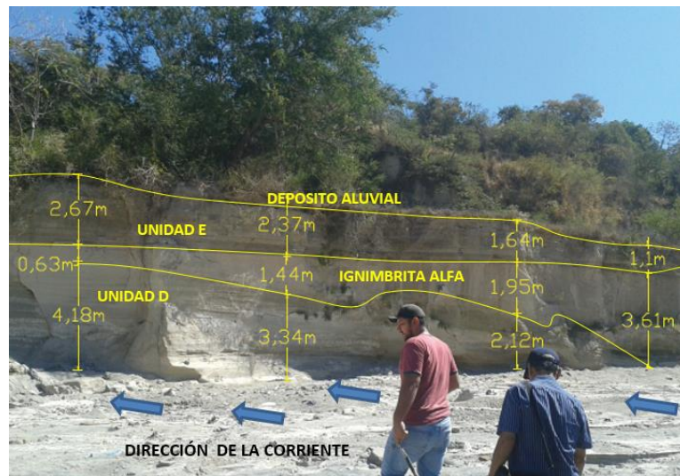
Figura No. 4.6.12 Perfil Longitudinal del talud y variación en altura de las unidades que conforman el PUNTO No 2 TALUD AEROPUERTO I
