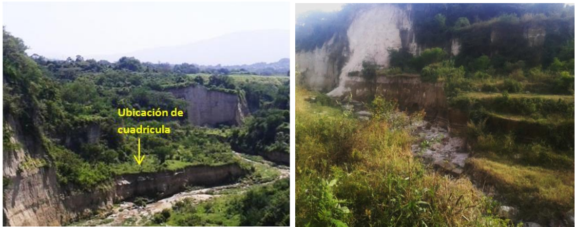
Figura No. 4.7.10 Vistas de Talud Zona Franca III, En la imagen del costado izquierdo se aprecia el Punto No. 10 Talud Zona Franca III con una vista en dirección Poniente y en la imagen del costado derecho se aprecia el mismo Talud con una vista en dirección Sur Fuente: EL AUTOR, fotografías tomadas el 28/07/2017
