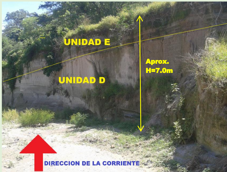
Figura No. 4.4.5 Talud ubicado frente a Aeropuerto de Ilopango Fuente: EL AUTOR, fotografía tomada 3/02/2017
