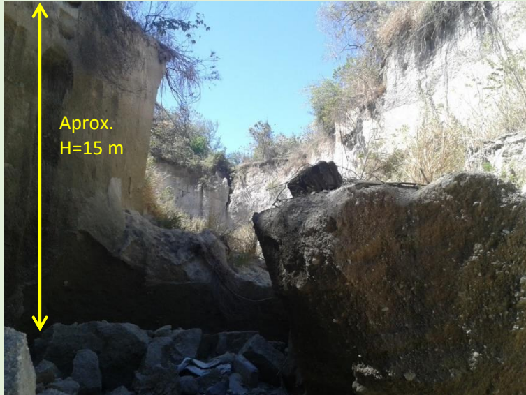
Figura No. 4.4.18 Talud ubicado en Zona Franca de Ilopango Fuente: EL AUTOR, fotografía tomada 3/02/2017
