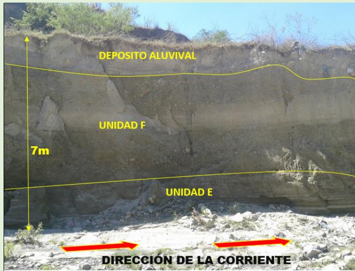
Figura No. 4.4.22 Talud ubicado en Zona Franca de Ilopango Fuente: EL AUTOR, fotografía tomada 3/02/2017
