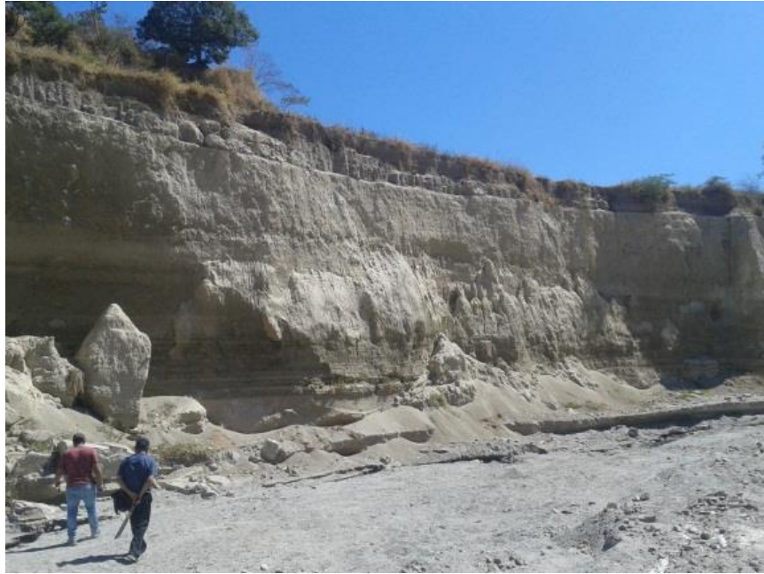
TALUD EROPUERTO II, 3/2/2017 Fuente: DEL AUTOR
