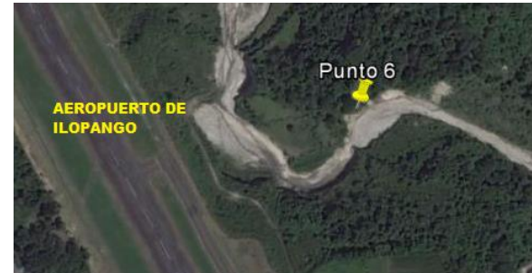
Figura No. 4.4.15 Localización de Talud Aeropuerto V Fuente: EL AUTOR, apoyado en Google Earth
