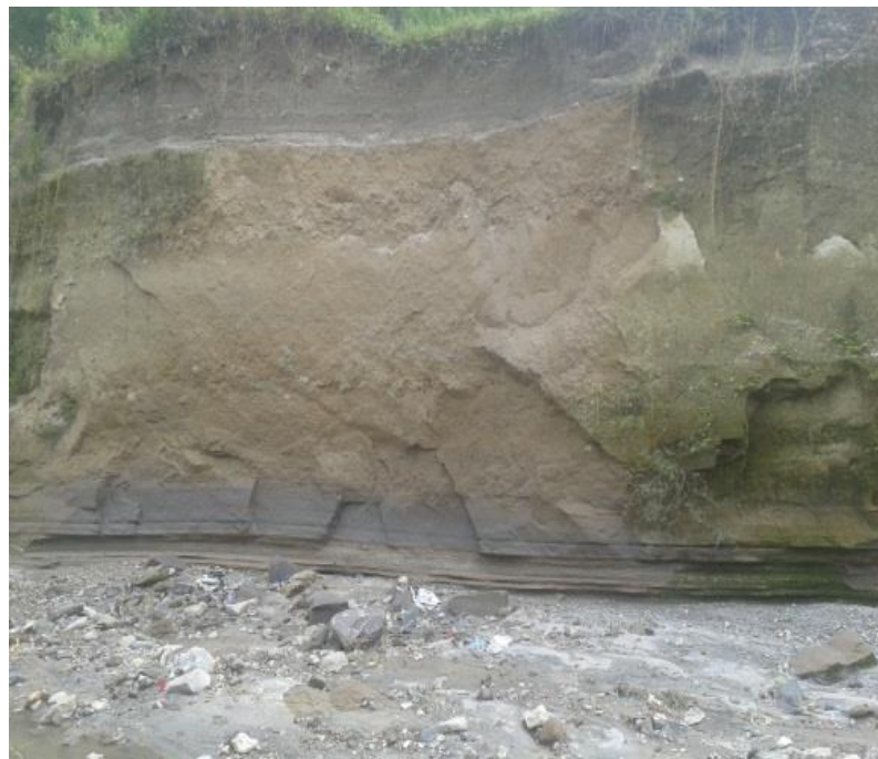
TALUD ZONA FRANCA III, 2/10/2017 Fuente: DEL AUTOR
