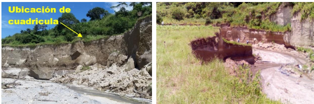
Figura No. 4.7.16 Imagen del costado izquierdo muestra una vista frontal del PUNTO No. 3 TALUD AEROPUERTO II y la imagen del costado derecho muestra una vista superior del mismo talud. Fuente: EL AUTOR, fotografías tomadas el 28/07/2017
