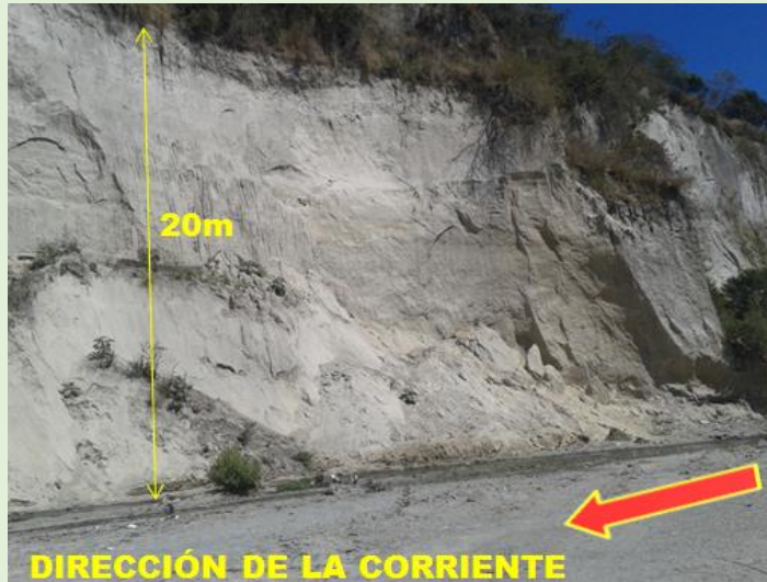
Figura No. 4.4.14 Talud ubicado frente a Aeropuerto de Ilopango Fuente: EL AUTOR, fotografía tomada 3/02/2017
