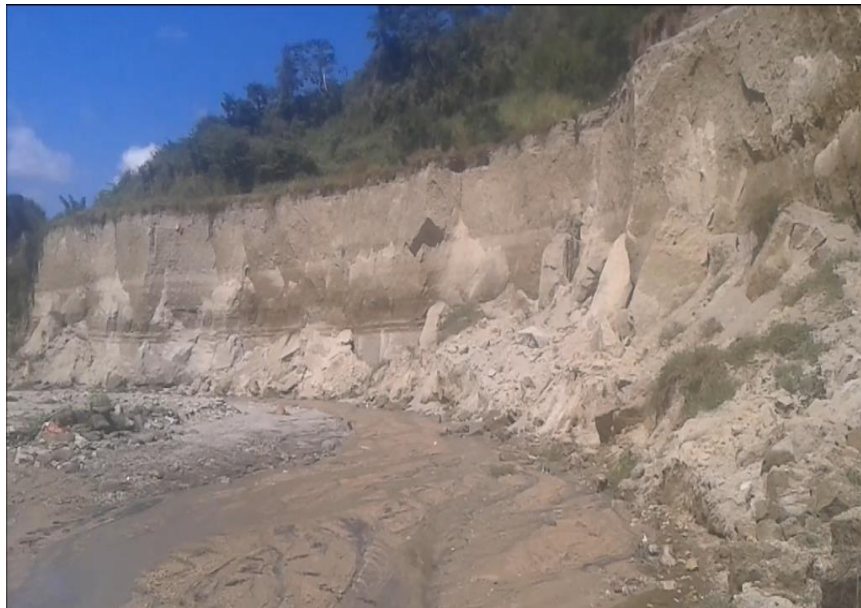
TALUD AEROPUERTO II, 16/11/2017 Fuente: DEL AUTOR
