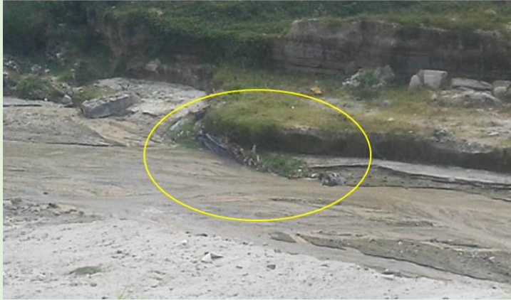
Figura No. 4.4.8 Obra de protección artesanal para proteger el talud del Aeropuerto de Ilopango
