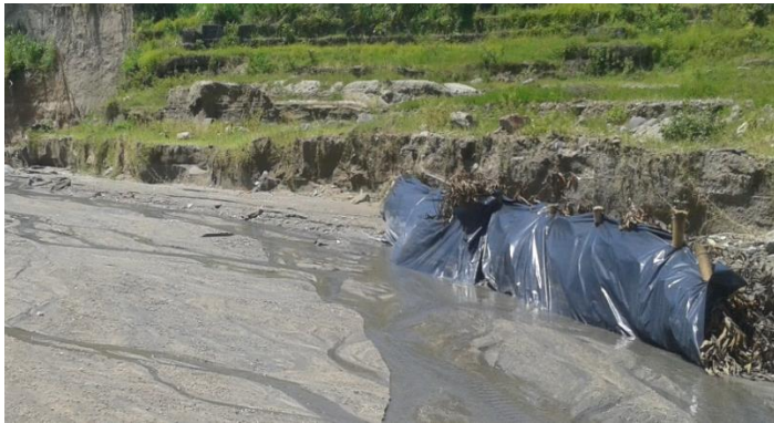
Figura No. 4.6.9 Obras de protección artesanales ubicadas frente al PUNTO No 3 TALUD AEROPUERTO II Fuente: EL AUTOR, fotografía tomada el 28/07/2017
