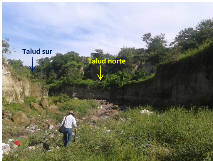
Figura No. 4.7.12 Sección transversal de la quebrada el Arenal Seco, donde se encuentra ubicado el PUNTO No. 9 TALUD ZONA FRANCA II.
