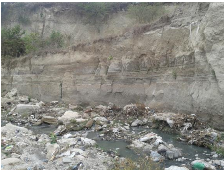
TALUD ZONA FRANCA II, 3/2/2017 Fuente: DEL AUTOR
