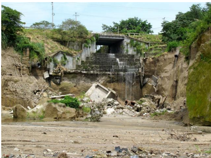
Figura No. 2.5.9 Erosión vertical en el sistema de guardaniveles zona franca, Ilopango Fuente: Chávez et al, (2010). "Cartografía y evaluación para estudiar los procesos erosivos en el Área Metropolitana de San Salvador" Pág. 55.
