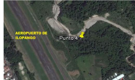
Figura No. 4.4.11 Localización de Talud Aeropuerto III Fuente: EL AUTOR, apoyado en Google Earth
