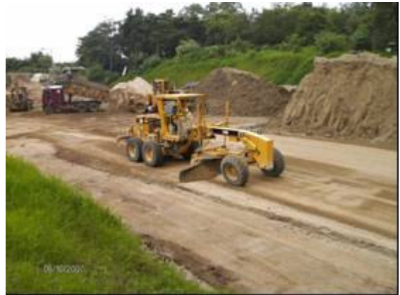
Fotografía 92- Compactación de base subrasante Efectos del medio ambiente de trabajo/vibración para el operador y los trabajadores auxiliares
