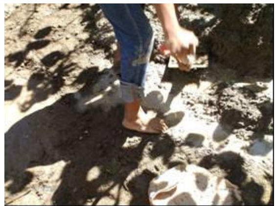
Fotografía 134- preparado de concreto Trabajador sin zapatos, con riesgo de lesionarse los pies
