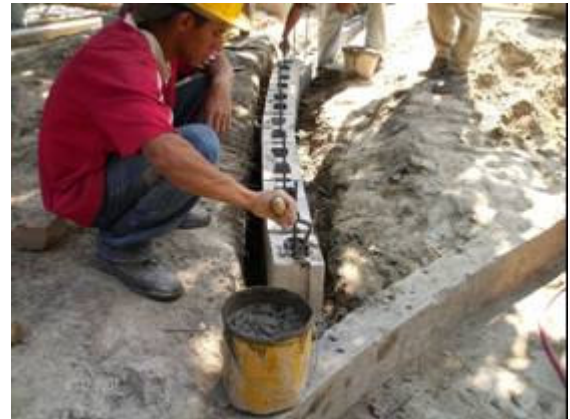
Fotografía 48-Llenado de bastones Posturas forzadas/trabajo en cuclillas
