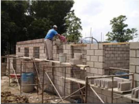
Fotografía 45-Sula creado de bloque Posturas forzadas/espalda y cuello inclinados
