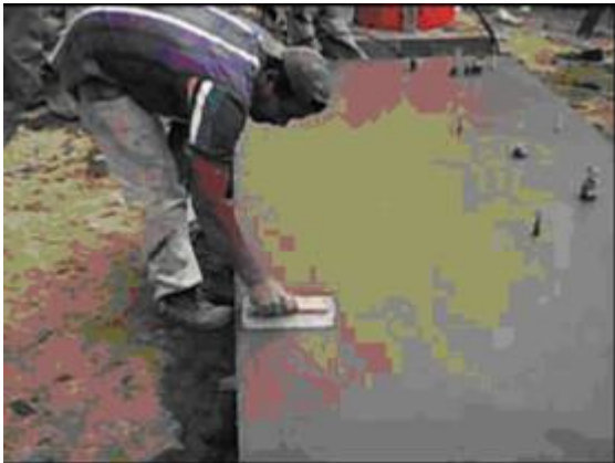
Fotografía 125- Planchado de mezcla Posturas forzadas levantamiento extremo / espalda y cuello inclinados, levantamientos de carga superior a 75 lbs
