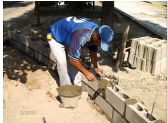
Fotografía 48-Llenado de bastones Posturas forzadas/trabajo en cuclillas
