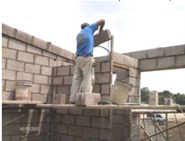
Ilustración II- 38-Construcción de paredes de bloque
