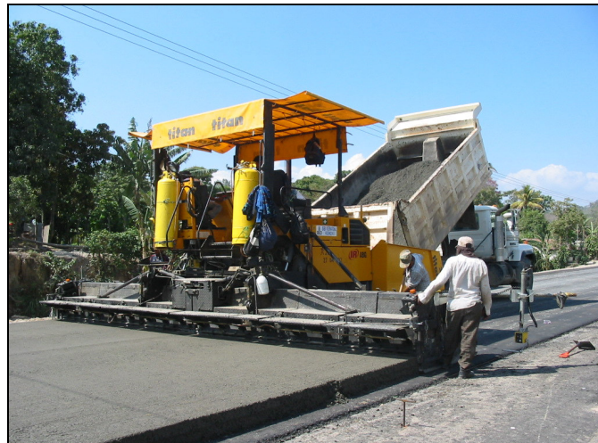
Ilustración II- 27-Transporte y colocación del concreto hidráulico.
