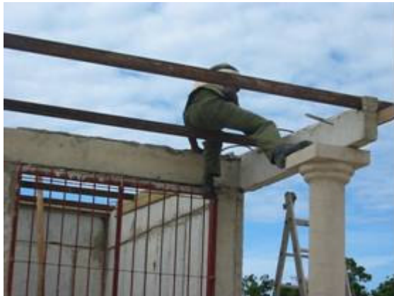
Fotografía 59-Ubicación de cordel para alinear faja Posturas forzadas/espalda y cuello inclinados, trabajo de rodillas
