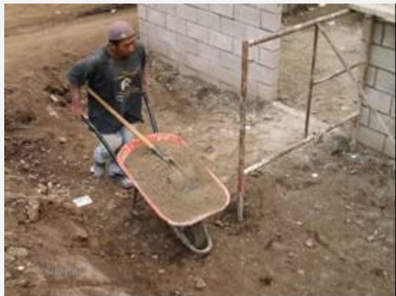
Fotografía 6-Remoción de material utilizable Levantamientos forzados/la carga se mantiene separada mientras se transportan
