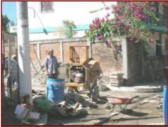
Fotografía 113- Elaboración de bordillos Posturas forzadas/espalda y cuello inclinados y trabajo de rodillas en cuclillas
