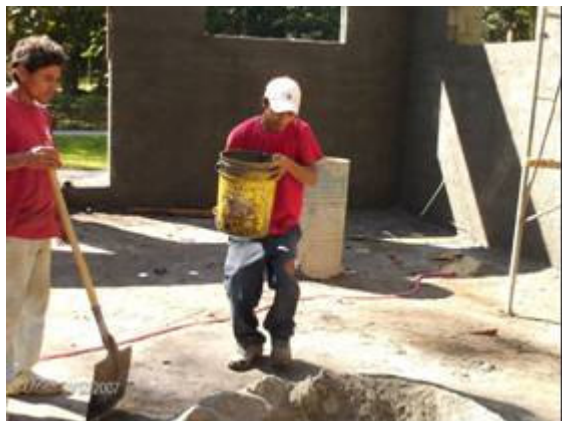
Fotografía 84-Transporte manual de materiales Levantamientos forzados/manejo de materiales con el cuerpo en desequilibrio
