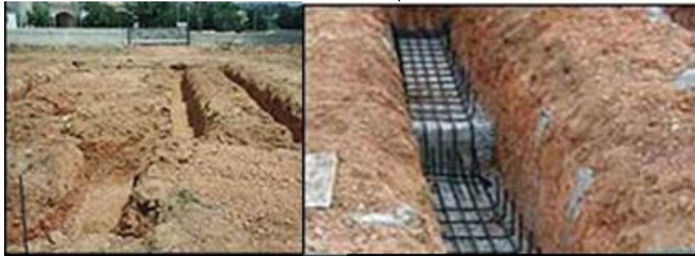
Ilustración II- 15-Excavación para solera de fundación.
