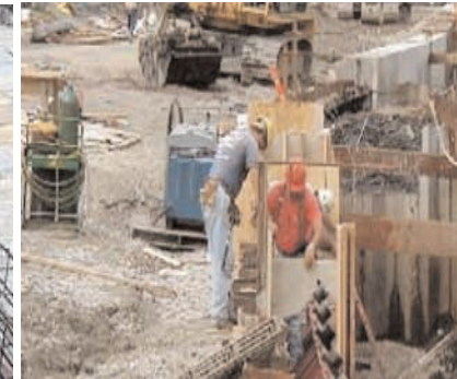
Fig. H. Realización de encofrado en suelo lleno de obstáculos.
