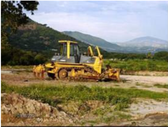
Fotografía 89- Remoción de material orgánico (tierra excedente) Efectos del medio ambiente de trabajo/vibración de sufrida por el trabajador que distribuye manualmente la tierra
