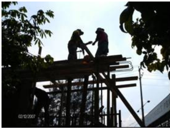
Fotografía 11- Demolición manual de pared Impacto repetido/golpe con almógana
