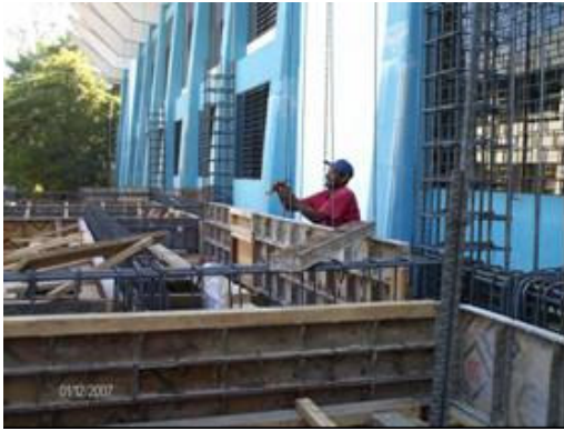
Fotografía 33-Armado de refuerzos para pavimento Posturas forzadas y movimientos repetitivos /espalda y cuello inclinados y giro de muñecas
