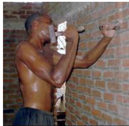
Fotografía 12- Picado de Pared para empotramiento Fuerza manual extrema y movimiento repetitivo/agarre sin apoyo, contracción y extensión de brazo
