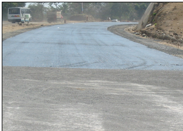
Ilustración II- 35-Curado del concreto a través de una mezcla bituminosa
