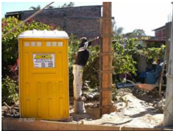
Fotografía 51-Encofrado de columna Posturas forzadas/brazos arriba de los hombros y en posición inestable
