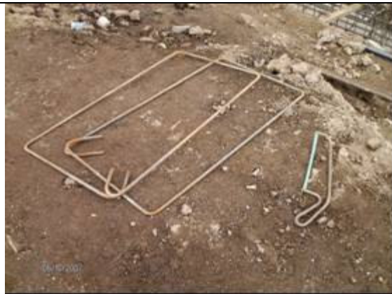
Fotografía 174- Trazo para doblado de varillas de hierro Empotramiento provisional con clavos doblados
