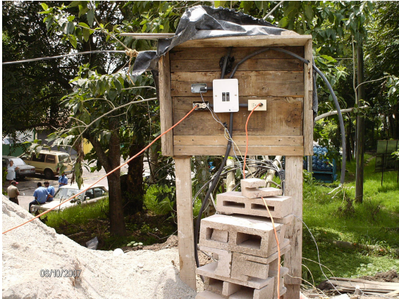
Fotografía 177- Equipo de soldadura eléctrica Caja de control muy próxima al equipo de soldadura
