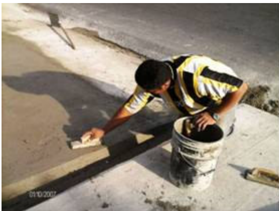
Fotografía 23-Codaleado de acera peatonal Posturas forzadas y fuerza manual extrema/trabajo en cuclillas y aplicación de presión con las manos
