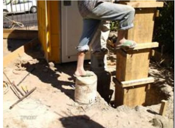
Fotografía 134- preparado de concreto Trabajador sin zapatos, con riesgo de lesionarse los pies
