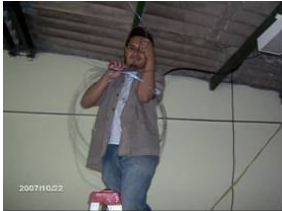
Fotografía 155- Amarre de tensores para enclado Trabajando en alturas, con el cuerpo enredado en alambre galvanizado
