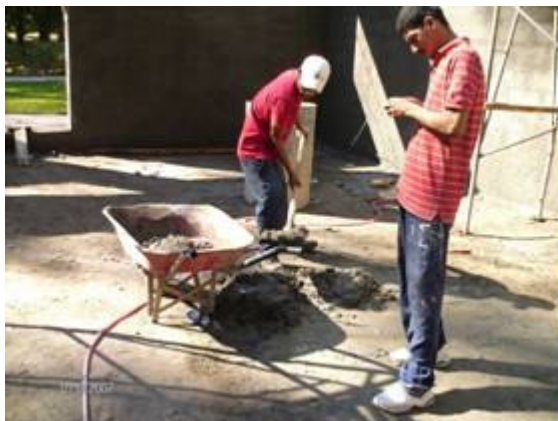
Fotografía 83-Cargado de mezcla Posturas forzadas/trabajando con el cuerpo rotado
