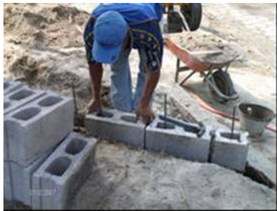
Fotografía 40-Aplicación de mezcla (hiladas superiores) Posturas forzadas/trabajo con manos rotadas
