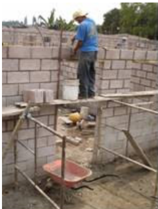
Fotografía 157- Su lacreado de bloques a diferente altura Plataforma (tabla) del andamio es demasiado delgada y sensible a flexiones
