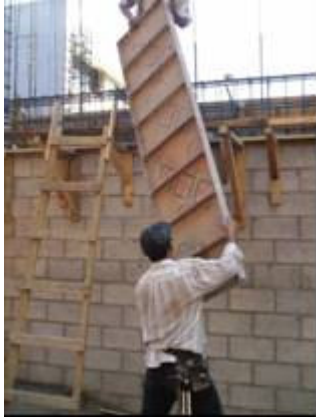
Fotografía 57-Instalación de polines Posturas forzadas/espalda y cuello inclinados y en posición inestable
