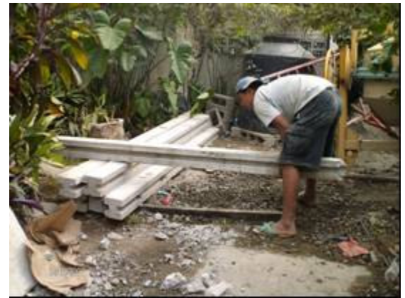
Fotografía 126- Movimiento de pared prefabricados Posturas forzadas levantamiento extremo / espalda y cuello inclinados, levantamientos de carga superior a 75 lbs
