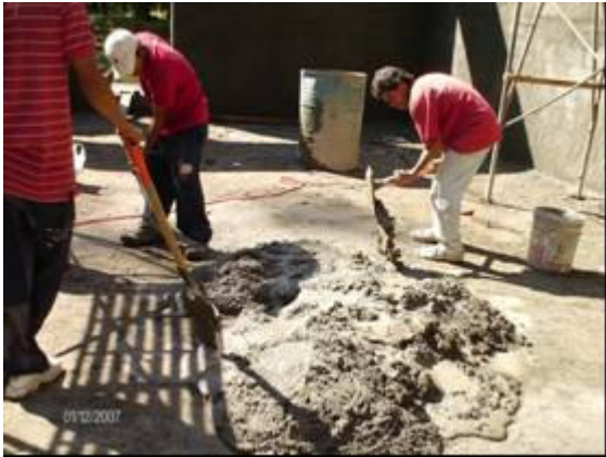
Fotografía 86-Transporte manual de materiales Levantamientos forzados/manejo de materiales con el cuerpo en desequilibrio
