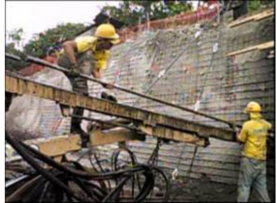
Fotografía 96- Amarre de estribos manual (con alicates) Movimientos repetitivos fuerza manual extrema/giros de las muñecas, agarre y tensionado de la herramienta para cortar el alambre
