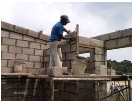
Fotografía 42- Ubicación y alineado de bloque Fuerza manual extrema/agarre tipo pinza
