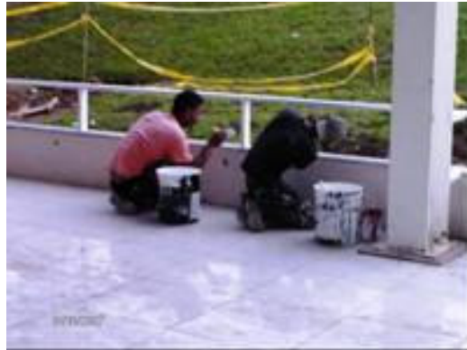
Ilustración II- 23-Trabajadores en la tarea de pintura.
