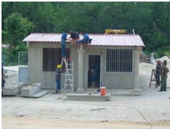
Fotografía 133- Atornillado de láminas Posturas forzadas/espalda y cuello inclinados, trabajo en cuclillas y en posición inestable
