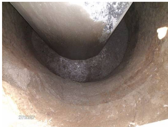
Ilustración II- 45-Vista del llenado de una base de torre con concreto
