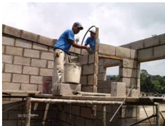
Fotografía 42- Ubicación y alineado de bloque Fuerza manual extrema/agarre tipo pinza
