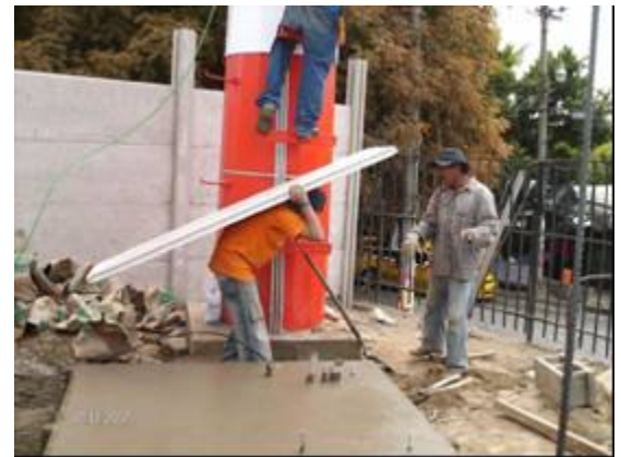
Fotografía 126- Movimiento de pared prefabricados Posturas forzadas levantamiento extremo / espalda y cuello inclinados, levantamientos de carga superior a 75 lbs
