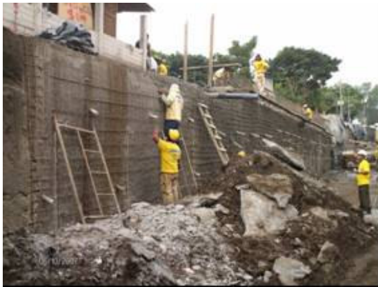
Fotografía 133- Atornillado de láminas Posturas forzadas/espalda y cuello inclinados, trabajo en cuclillas y en posición inestable
