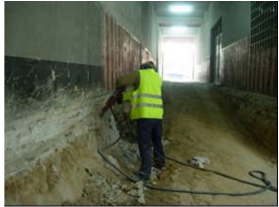
Fotografía 8- Demolición con equipo Efectos del ambiente de trabajo/vibración
