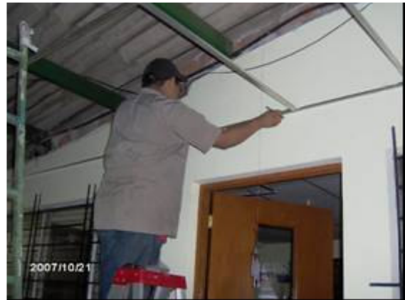
Fotografía 78- Medición de perfiles para cielo falso Posturas forzadas /Trabajando en cuclillas
