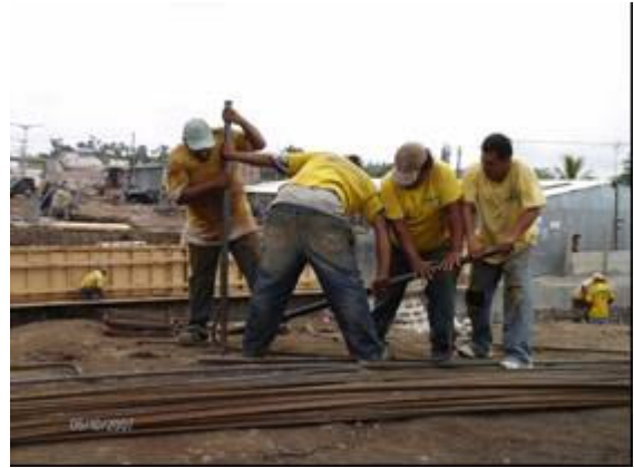
Fotografía 102- Doblado de barras de 1plg Fuerza manual extrema y postura inadecuada/utilización de las manos para realizar fuerza y palanca, brazos arriba de los hombros, agarre de herramienta sin apoyo
