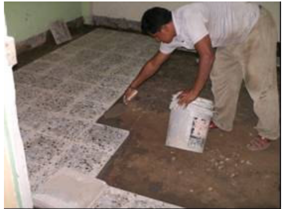
Fotografía 64-Codaleado de fajas Movimientos repetitivos/espalda y cuello inclinados
