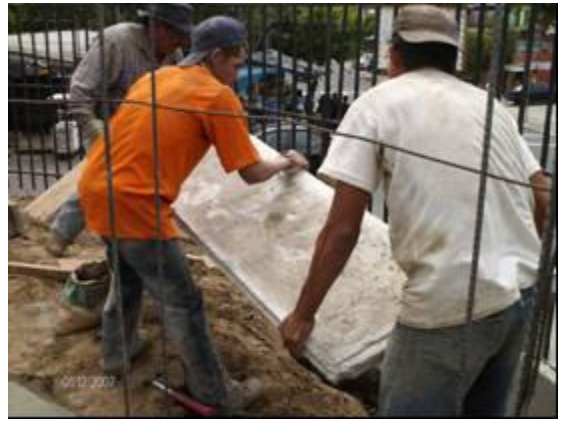
Fotografía 128- Descarga de prefabricados Posturas forzadas levantamiento extremo /espalda y cuello inclinados, levantamientos de carga superior a 75 lbs
