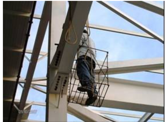
Fotografía 164- Instalación de pasamanos Trabajando en andamio, riesgo de caídas, golpes contra objetos y descargas eléctricas
