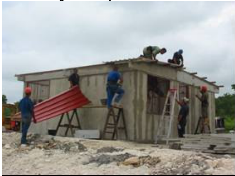
Fig. C Trabajando de rodillas y levantamiento de laminas
