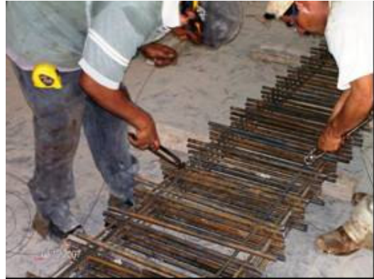
Fotografía 34- Ubicación de refuerzo para pavimento Posturas forzadas/trabajo en cuclillas
