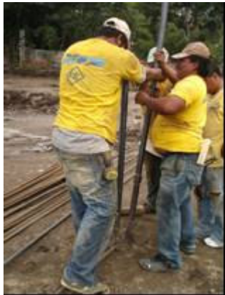
Fotografía 103- Transporte de barras de 1plg (dobladas) Levantamientos forzados/transporte de carga con el cuerpo en desequilibrio
