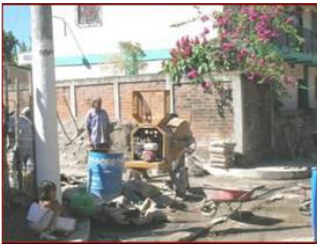
Fig. A. Operación de concreteira
