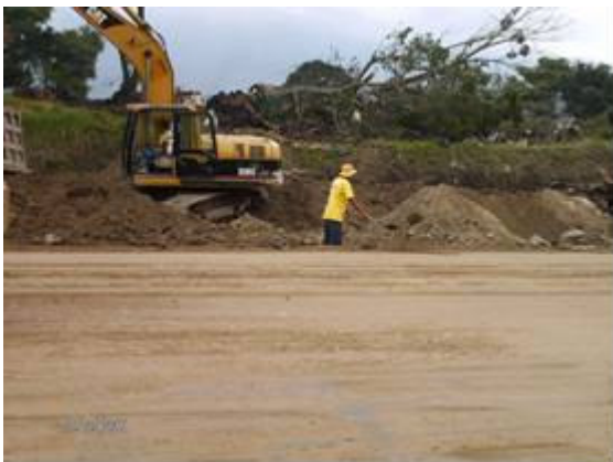
Fotografía 91- Relleno manual con material selecto Efectos del medio ambiente de trabajo/excesivo sol y calor extremo
