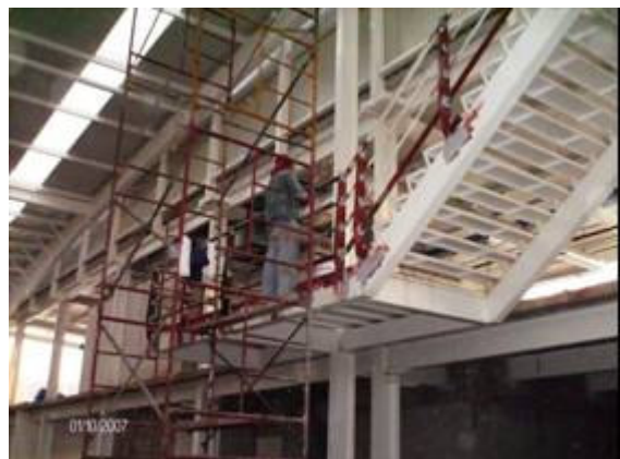
Fotografía 164- Instalación de pasamanos Trabajando en andamio, riesgo de caídas, golpes contra objetos y descargas eléctricas
