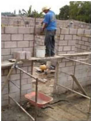
Fotografía 47-Sula creado de bloques Posturas forzadas/trabajo con manos rotadas
