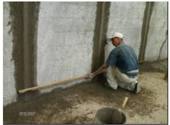
Fotografía 66- Elaboración de fajas o maestras Movimientos repetitivos/espalda y cuello inclinados
