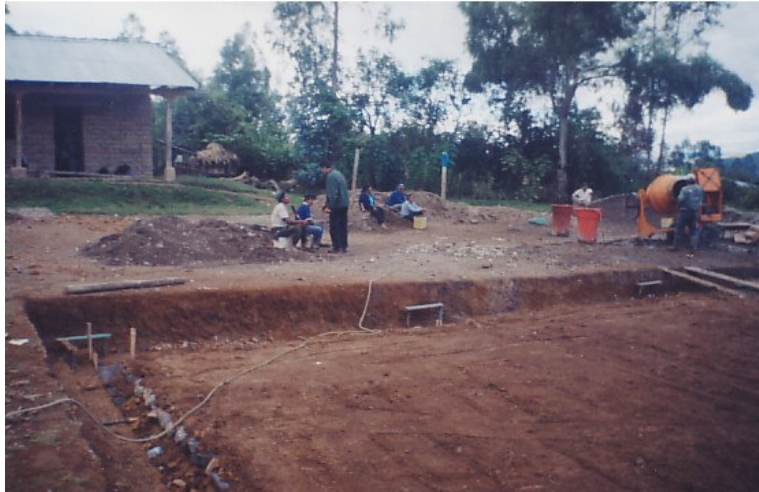
Ilustración II- 8-Área de terreno previamente nivelada para construcción de vivienda
