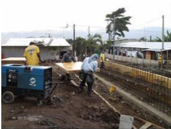
Fotografía 109- Alineado de tabla Posturas forzadas/espalda y cuello inclinados y trabajo de rodillas en posición inestable
