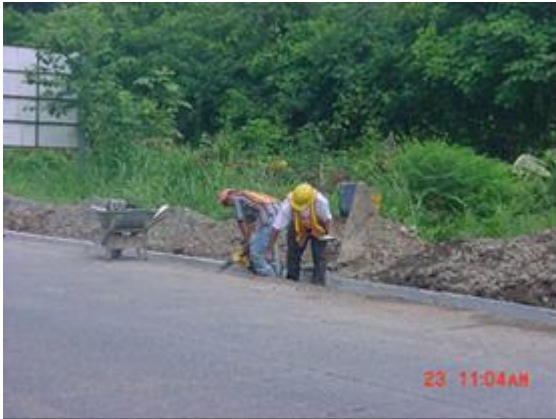
Fotografía 113- Elaboración de bordillos Posturas forzadas/espalda y cuello inclinados y trabajo de rodillas en cuclillas
