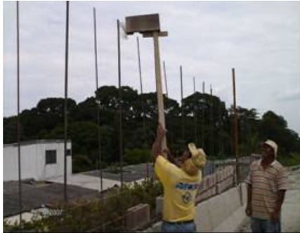
Fig. G. colocar bloques en la zona de trabajo.
