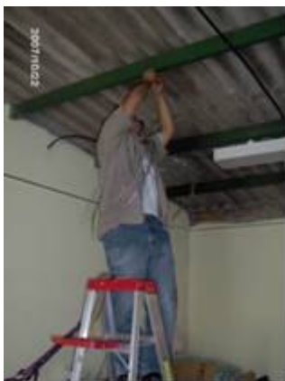
Fotografía 77-Amarre de tensores de perfiles Posturas forzadas y fuerza manual/brazos arriba de los hombros y agarre sin apoyo de herramienta
