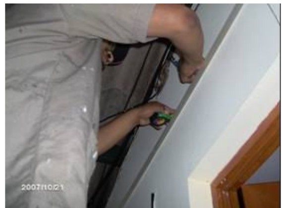
Fotografía 152- Encielado Caídas a diferente nivel, poca iluminación
