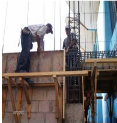
Fig. E. Inclinación de espalda al ajustar un encofrado.
