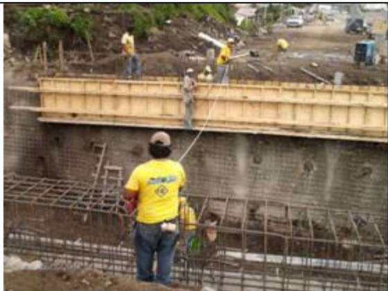
Fotografía 173- Trazo para doblado de varillas de hierro Trazo provisional hecho con clavos
