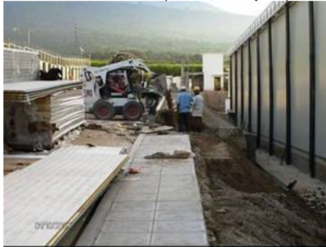
Ilustración II- 13-Acera peatonal, relleno y compactación
