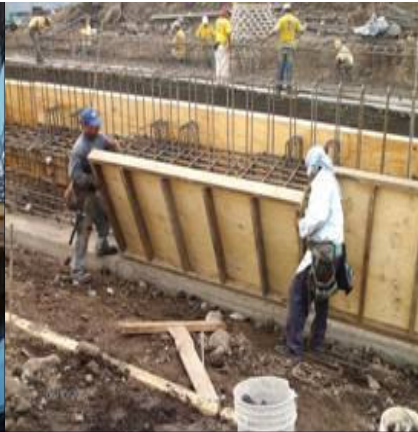
Fig. F. levantamiento de tablero.
