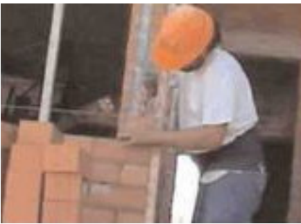
Fig. C. Ajustando ladrillos con el mango de la paleta.
