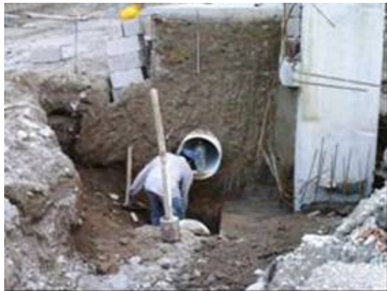
Fotografía 17-Excavación para caja recolectora Posturas forzadas/espalda y cuello inclinados
