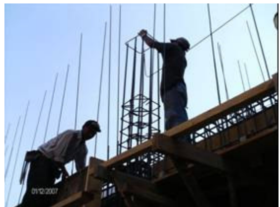
Fotografía 30-Ubicación de estribos para columnas Posturas forzadas/brazos arriba de los hombros
