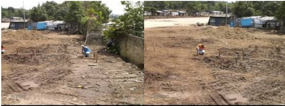
Ilustración II- 6-Trabajadores instalando Niveletas para trazo de viviendas.
