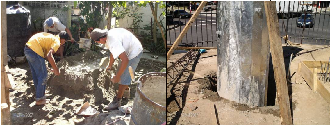
Ilustración II- 44-Llenado de concreto en la base de una torre monopolo
