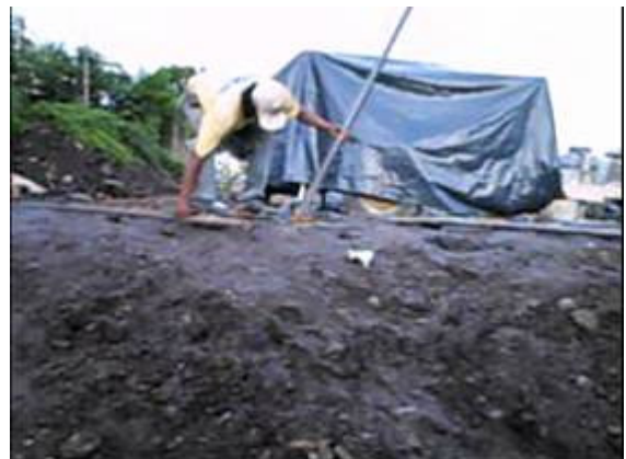
Fotografía 98-Ubicación de grifas sobre la sección a doblar Fuerza manual extrema/utilización de las manos para realizar fuerza y palanca
