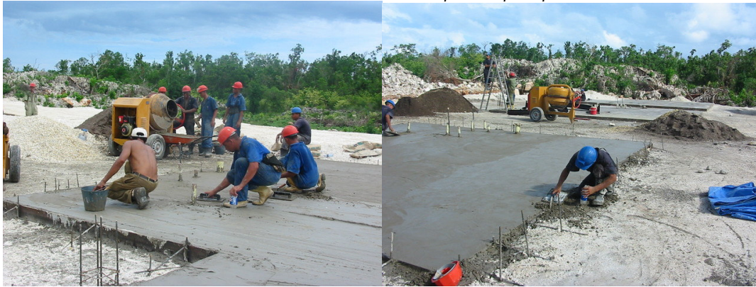
Ilustración II- 41-Planchado de superficie para piso
