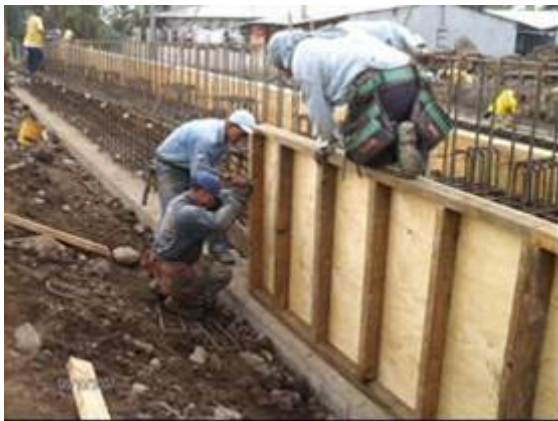
Fotografía 109- Alineado de tabla Posturas forzadas/espalda y cuello inclinados y trabajo de rodillas en posición inestable
