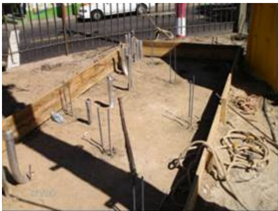
Fotografía 145-Tubería para cableado en torre Caídas a un mismo nivel , golpes contra objetos
