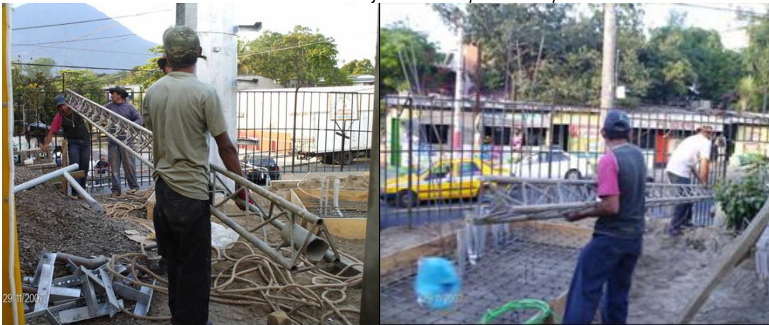
Ilustración II- 47-Trabajadores Manipulando el poste Grúa
