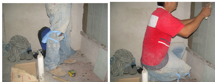
Fig. D. Trabajador Utilizando Cuña Amortiguadora
