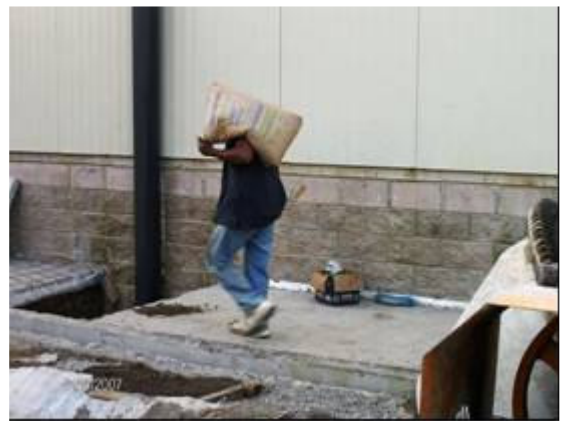
Fotografía 84-Transporte manual de materiales Levantamientos forzados/manejo de materiales con el cuerpo en desequilibrio
