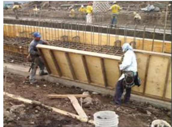
Fotografía 110- Aseguramiento (clavado de encofre) Posturas forzadas/espalda y cuello inclinados y aplicación de fuerza manual e impacto repetido
