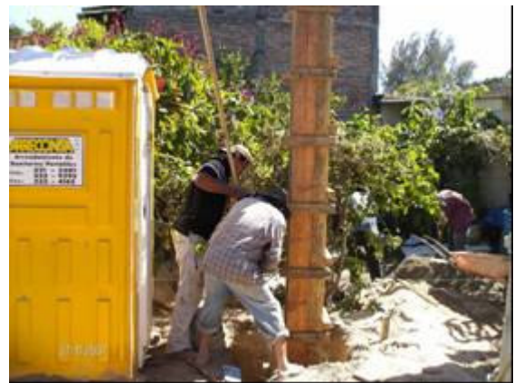
Fotografía 54-Encofrado de vigas Posturas forzadas, fuerza manual extrema/espalda y cuello inclinados, agarre tipo pinza
