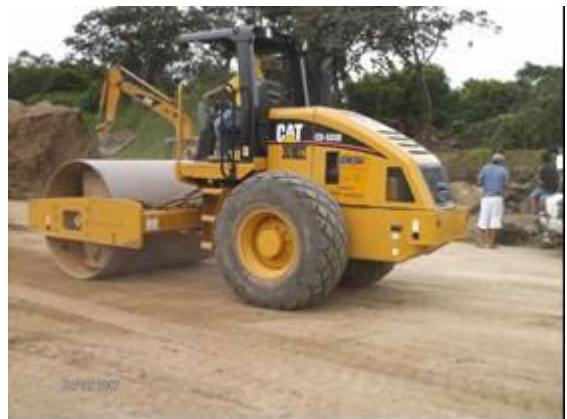
Fotografía 92- Compactación de base subrasante Efectos del medio ambiente de trabajo/vibración para el operador y los trabajadores auxiliares
