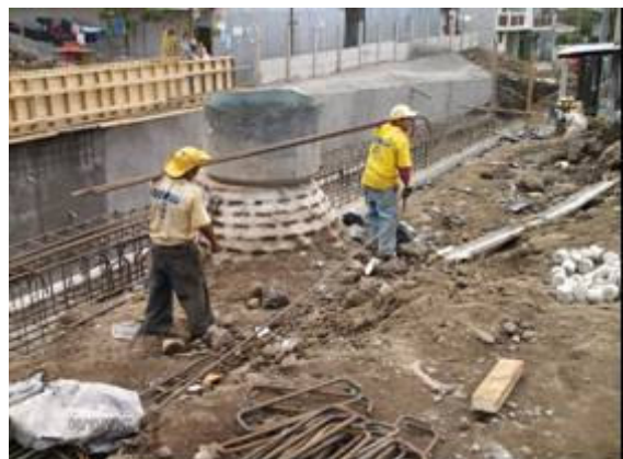
Fotografía 104- Transporte de barras de 1plg (dobladas) Levantamientos forzados/levantado de carga con el espalda ya cargado y en desequilibrio
