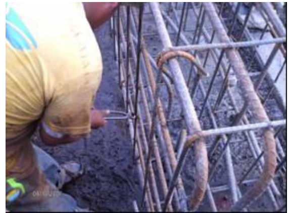
Fotografía 98-Ubicación de grifas sobre la sección a doblar Fuerza manual extrema/utilización de las manos para realizar fuerza y palanca
