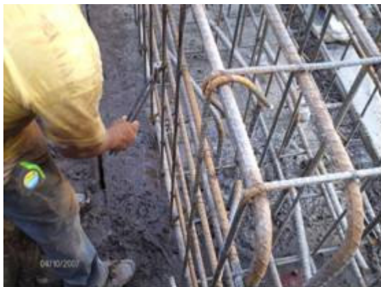
Fotografía 97-Apretado y cortado de alambre (fin del nudo) Impactos repetidos/tensión y halado instantáneo para cortar alambre
