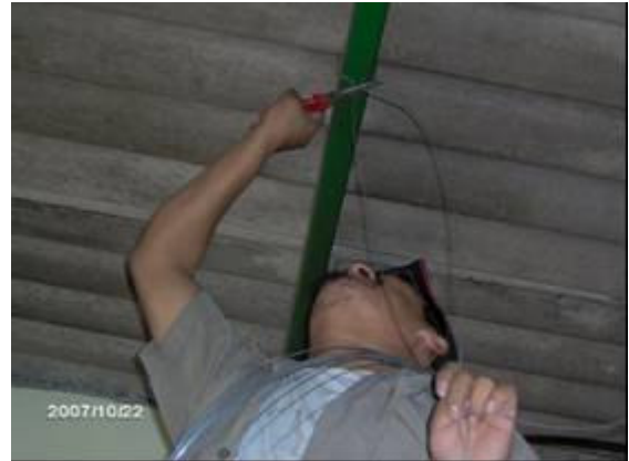
Fotografía 156- Amarre de tensores Trabajador en contacto directo con cemento
