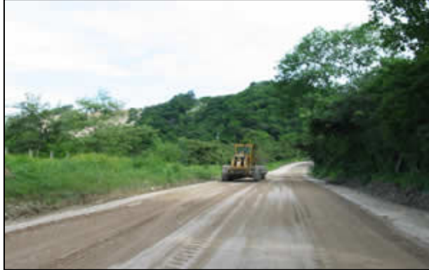
Ilustración II- 24-Preparación de la superficie para colocación de CCP.
