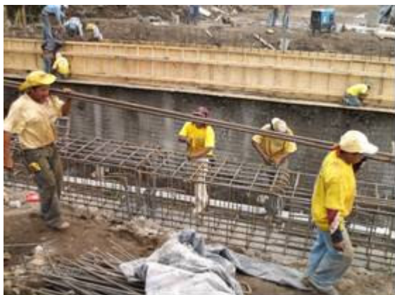
Fotografía 103- Transporte de barras de 1plg (dobladas) Levantamientos forzados/transporte de carga con el cuerpo en desequilibrio
