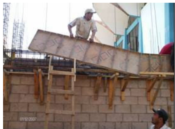
Fotografía 54-Encofrado de vigas Posturas forzadas, fuerza manual extrema/espalda y cuello inclinados, agarre tipo pinza
