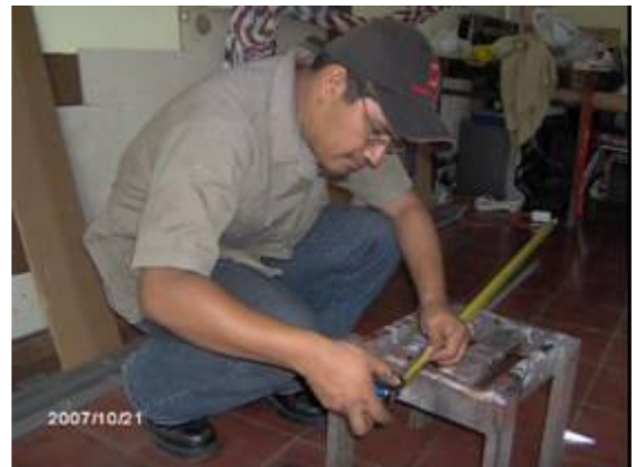
Fotografía 78- Medición de perfiles para cielo falso Posturas forzadas /Trabajando en cuclillas
