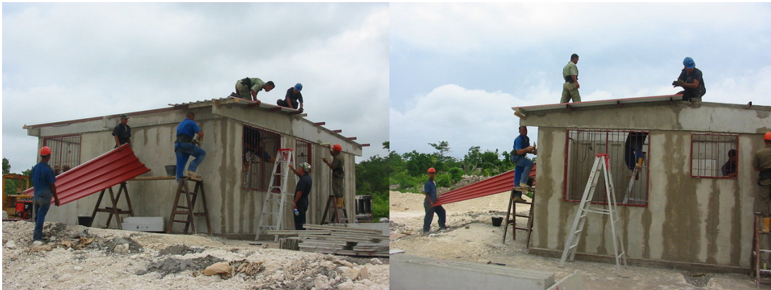
Ilustración II- 42-Techado de una estructura
