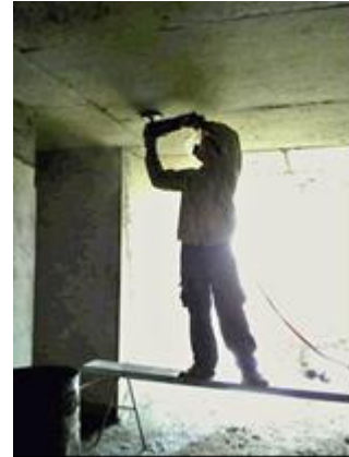
Fotografía 76-Fijación de perfiles de aluminio para cielo falso Posturas forzadas y fuerza manual/brazos arriba de los hombros y agarre sin apoyo de herramienta
