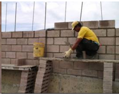
Fig. D. Partiendo Bloques con la paleta.
