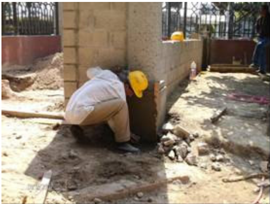
Fotografía 71- Repello de perfil Posturas forzadas y Movimientos repetitivos/ espalda y cuello inclinados contracción y extensión , trabajo de rodillas
