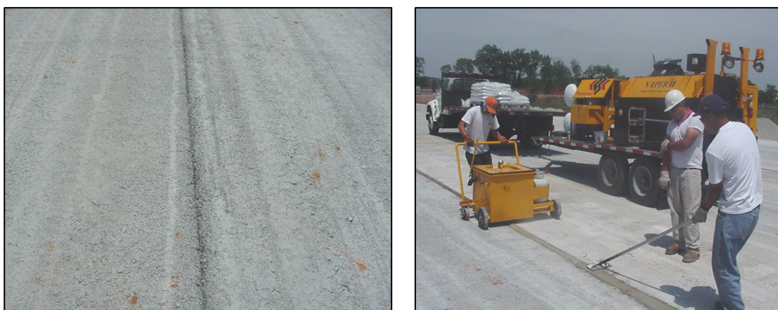
Ilustración II- 34- Vista y sellado de Junta fría
