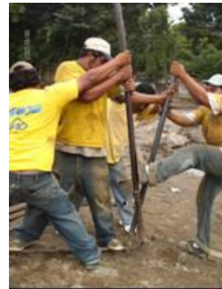
Fotografía 104- Transporte de barras de 1plg (dobladas) Levantamientos forzados/levantado de carga con el espalda ya cargado y en desequilibrio
