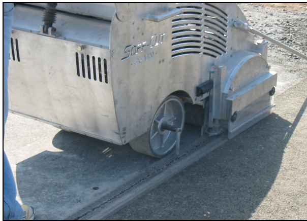
Ilustración II- 31-Elaboración de juntas.
