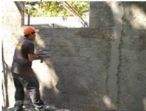
Ilustración II- 43-Trabajador en la tarea de azotado de mezcla (repello)
