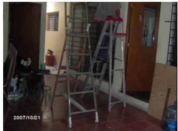
Fotografía 140- Encielado Caídas a diferente nivel, improvisación de escaleras de dos bandas.
