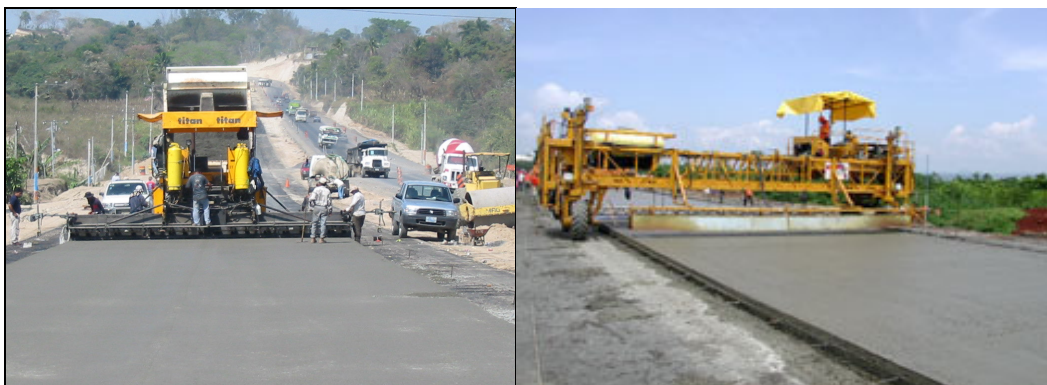
Ilustración II- 29-Equipo utilizado para la distribución, conformación y compactación del pavimento.
