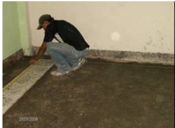
Fotografía 60-Pegado de ladrillo de piso Movimientos repetitivos/espalda y cuello inclinados mientras mide la dimensión de la faja
