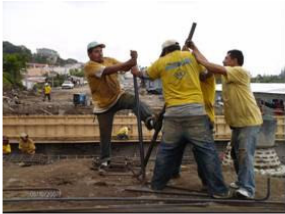
Fotografía 101- Doblado de barras de 1plg Fuerza manual extrema/utilización de las manos para realizar fuerza y palanca
