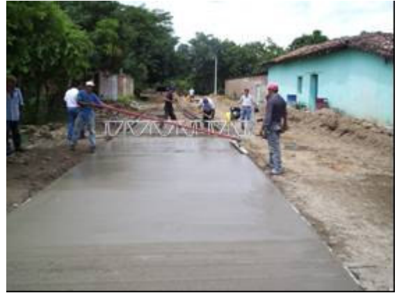
Fotografía 114-Equipo para la aplicación de pasta sobre el pavimento. Efectos ambientales/exposición a vibración
