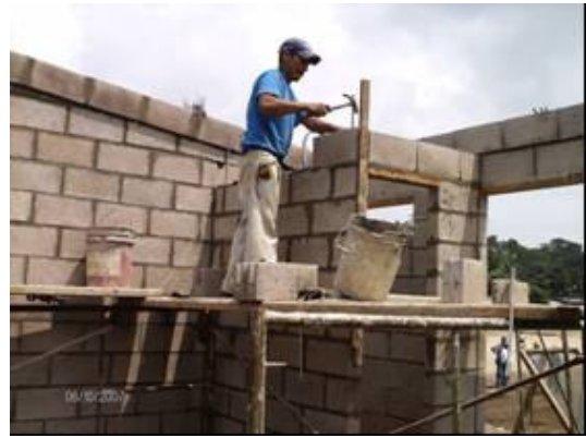
Fotografía 46- Sula creado de bloque Posturas forzadas/espalda y cuello inclinados
