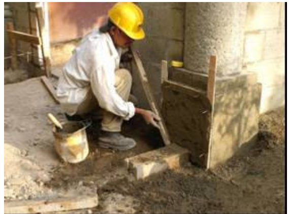
Fotografía 72- Codaleado Movimientos repetitivos/espalda y cuello inclinados, trabajo de rodillas
