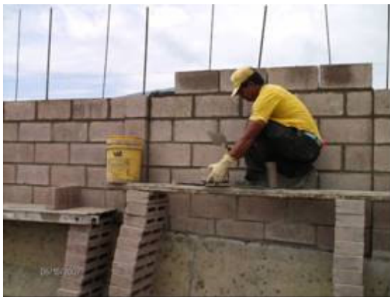
Fotografía 23-Codaleado de acera peatonal Posturas forzadas y fuerza manual extrema/trabajo en cuclillas y aplicación de presión con las manos
