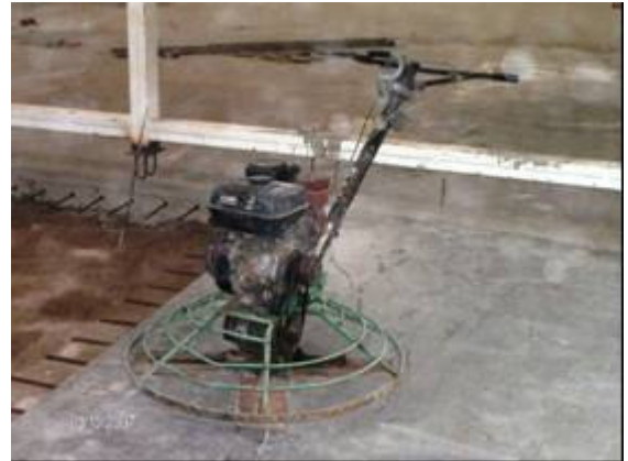
Fotografía 114-Equipo para la aplicación de pasta sobre el pavimento. Efectos ambientales/exposición a vibración
