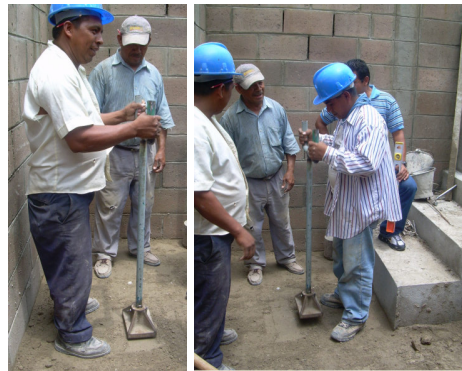
Fig. D. Trabajadores utilizando el compactador
