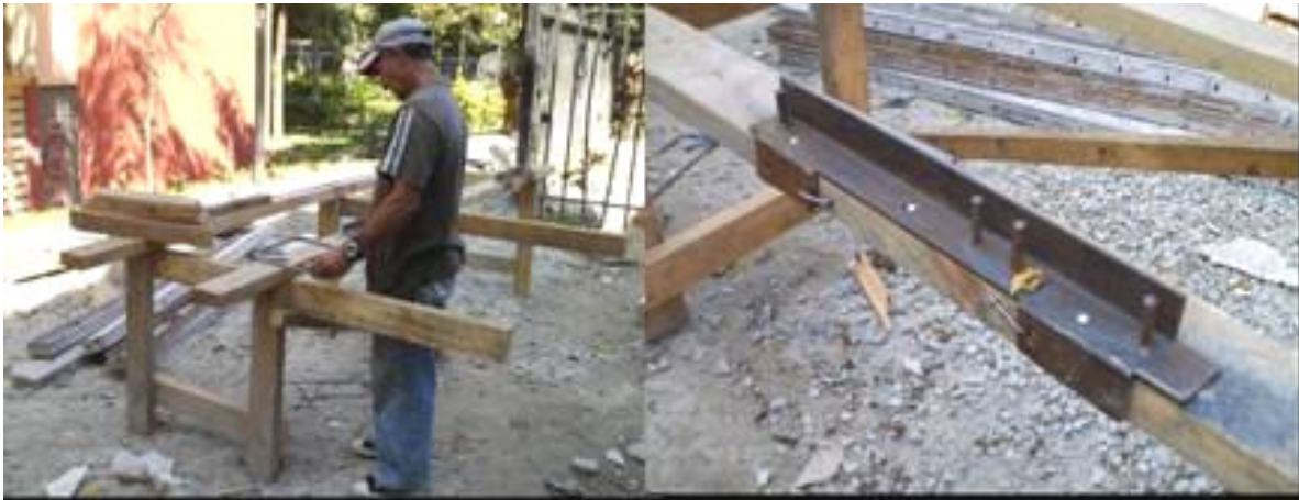
Ilustración II- 40- Trabajador verificando la forma de estribos luego de haber doblado en el “trazo”
