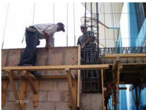
Fotografía 53-Encofrado de vigas Posturas forzadas/espalda y cuello inclinados
