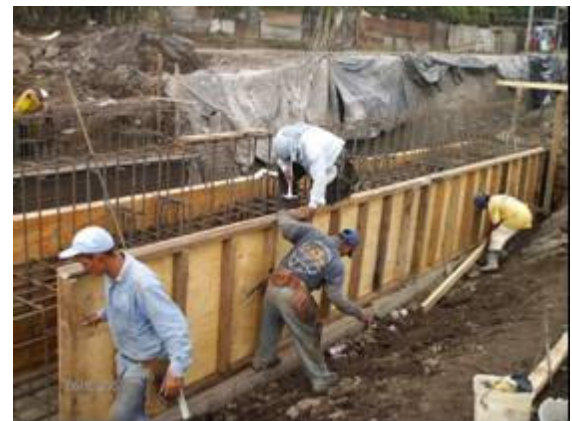
Fotografía 110- Aseguramiento (clavado de encofre) Posturas forzadas/espalda y cuello inclinados y aplicación de fuerza manual e impacto repetido
