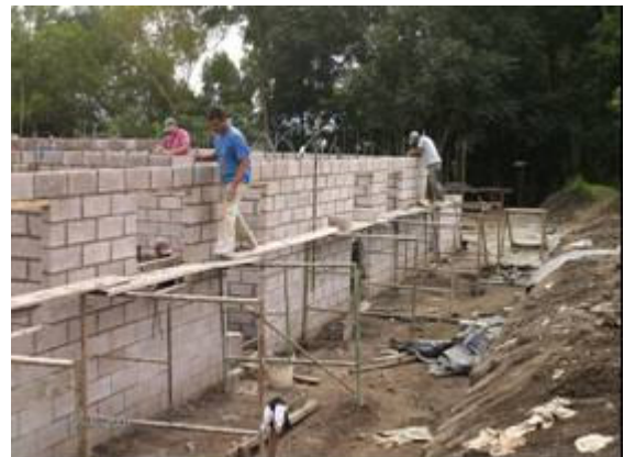
Fotografía 158- Pegado de bloques a diferente altura obstáculos a lo largo del andamio (bloques sobre la plataforma)
