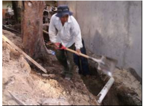
Fotografía 28-Compactación de zanjas para tuberías Movimientos repetitivos/uso de los brazos para impulsar herramienta
