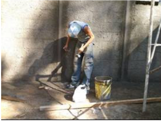
Fotografía 15- Picado de bloque para repello Impacto repetido/Golpear con herramienta
