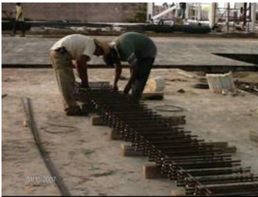
Fotografía 33-Armado de refuerzos para pavimento Posturas forzadas y movimientos repetitivos /espalda y cuello inclinados y giro de muñecas
