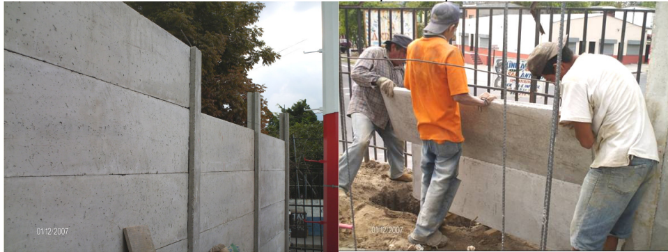
Ilustración II- 39- Construcción de paredes prefabricadas
