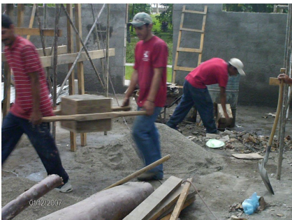
Fig. E. Caja de madera para dosificar y transportar materiales
