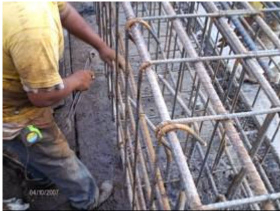
Fotografía 97-Apretado y cortado de alambre (fin del nudo) Impactos repetidos/tensión y halado instantáneo para cortar alambre
