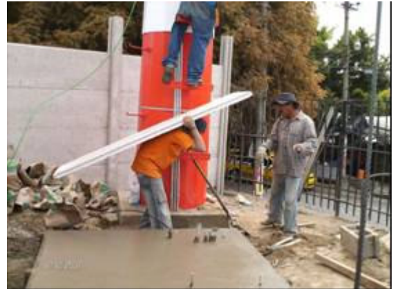
Fotografía 138- Encofrado Riesgo de caídas en agujeros
