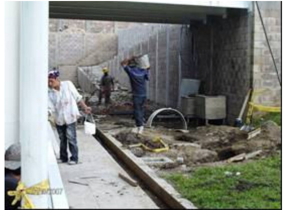
Fotografía 82-Transporte manual de materiales Levantamientos forzados/manejo de materiales con el cuerpo en desequilibrio
