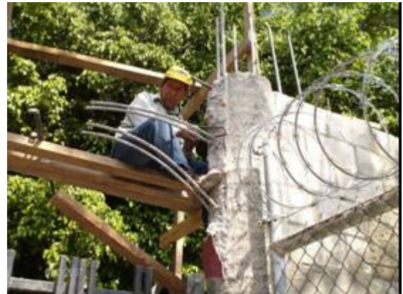
Fotografía 24-Corte de vigas (demolición de estructuras existentes) Posturas forzadas y fuerza manual extrema/espalda y cuello inclinados, trabajo en andamios
