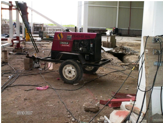
Fotografía 177- Equipo de soldadura eléctrica Caja de control muy próxima al equipo de soldadura
