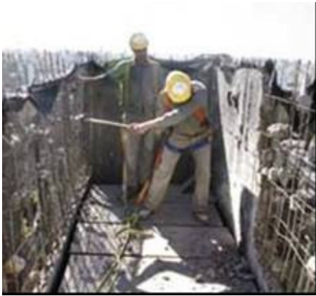
Fotografía 7- Demolición de estructuras existentes Posturas forzadas/espalda y cuello inclinados
