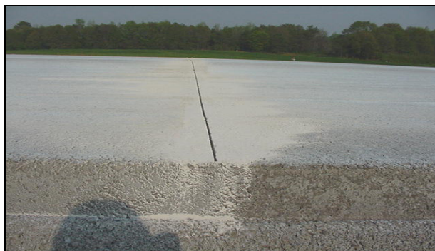
Ilustración II- 32-Vista de Junta Transversal en el pavimento.
