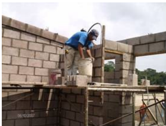
Fotografía 41-Ubicación de bloque (hiladas superiores) Fuerza manual extrema/agarre tipo pinza
