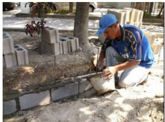
Fotografía 36-Aplicación de mezcla (hiladas inferiores) Posturas forzadas/trabajo de rodillas
