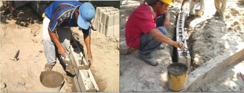
Ilustración II- 38-Construcción de paredes de bloque
