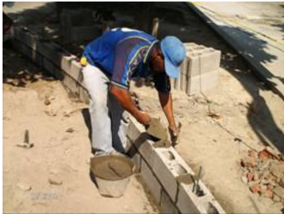
Fotografía 47-Sula creado de bloques Posturas forzadas/trabajo con manos rotadas
