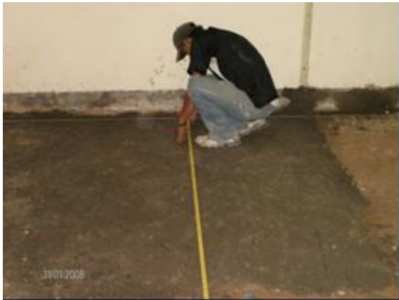
Fotografía 61-Fijación del cordel Posturas forzadas/espalda y cuello inclinados, trabajo de cuclillas
