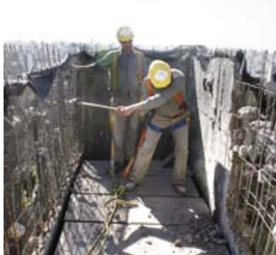
Ilustración II- 9-Trabajos de demolición
