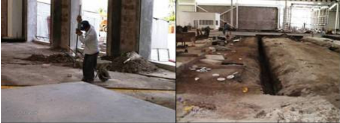
Ilustración II- 11-Excavación manual con barra, y Zanjas para empotramiento de tubería.
