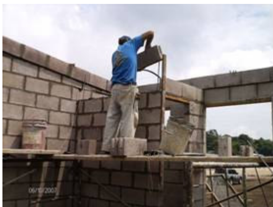
Fotografía 41-Ubicación de bloque (hiladas superiores) Fuerza manual extrema/agarre tipo pinza
