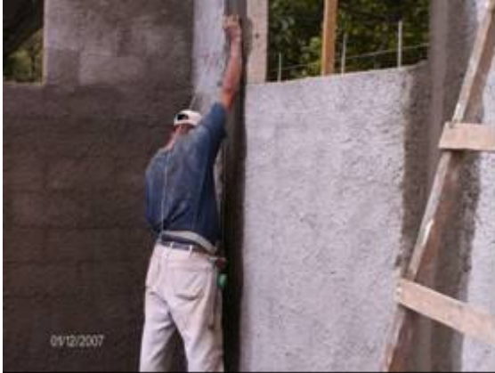
Fotografía 67- Elaboración (verticalidad) de fajas o maestras Movimientos repetitivos/espalda y cuello inclinados, brazos arriba de los hombros
