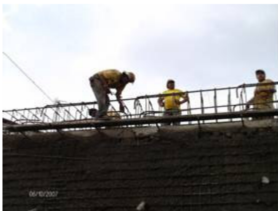
Fotografía 169- Armado de vigas para puente Caídas a diferente nivel (sin equipo de protección personal)
