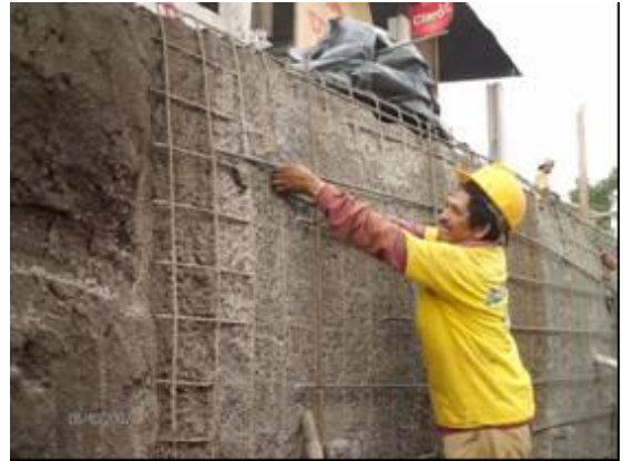
Fotografía 22-Ubicado de bloque dentro de los refuerzos verticales (bastones) Posturas forzadas y fuerza manual extrema/brazos arriba de los hombros
