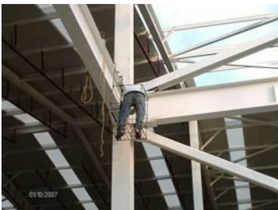
Fotografía 163- Empernado de vigas Trabajando en andamio, riesgo de caídas
