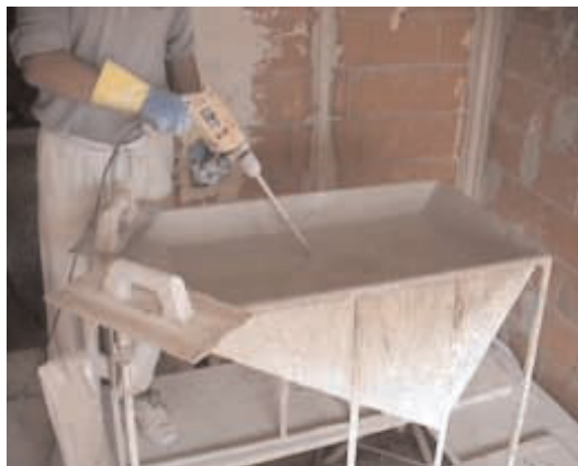
Figura B. Método Propuesto con Mezcladora eléctrica manual de cemento.
