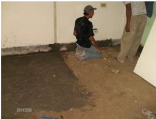
Fotografía 59-Ubicación de cordel para alinear faja Posturas forzadas/espalda y cuello inclinados, trabajo de rodillas
