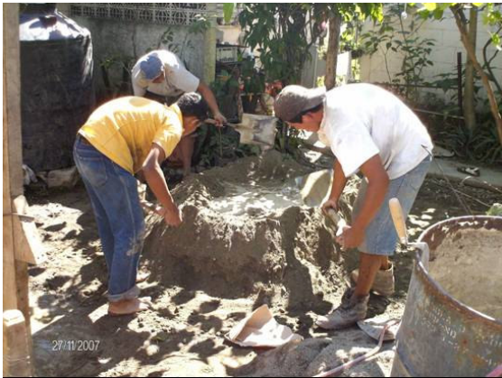
Fotografía 125- Planchado de mezcla Posturas forzadas levantamiento extremo / espalda y cuello inclinados, levantamientos de carga superior a 75 lbs
