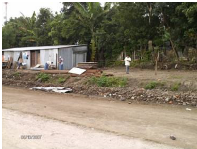
Ilustración II- 7-Trabajadores en la tarea de replanteo para la construcción de viviendas
