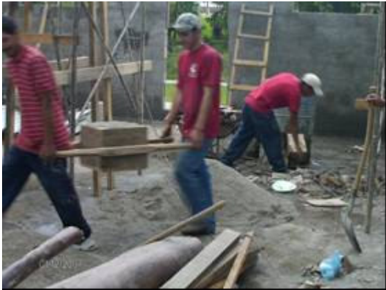
Fotografía 85-preparado de mezcla de cemento Posturas forzadas/espalda y cuello inclinados
