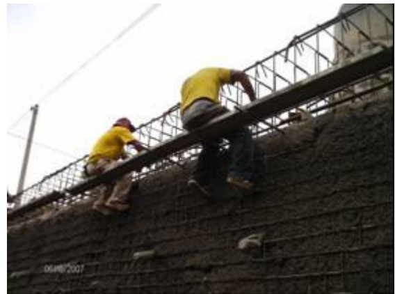
Fotografía 170- Trazo y medición de encofrado para viga Caídas a diferente nivel
