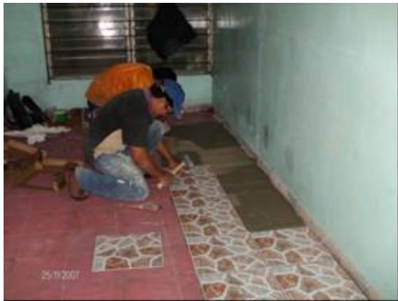
Fotografía 65- Elaboración de fajas o maestras Movimientos repetitivos/espalda y cuello inclinados
