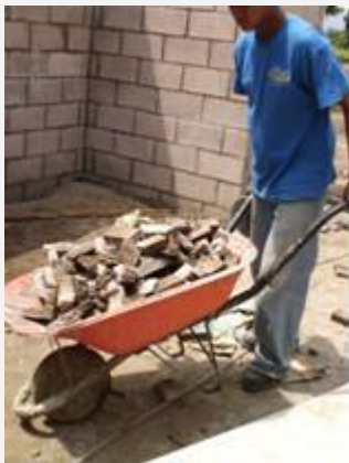
Fotografía 5-Remoción de material Levantamientos forzados/la carga se mantiene separada mientras se transportan
