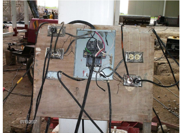
Fotografía 1788- Riesgo eléctrico Caja de control sin señalización de seguridad.
