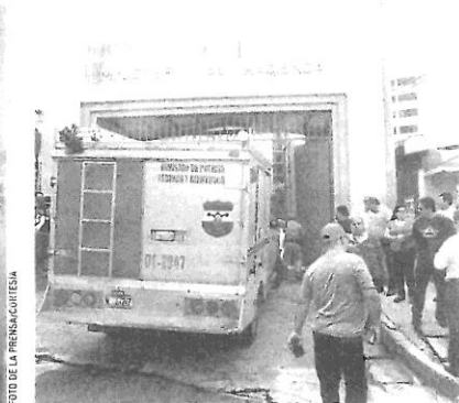
Inspección. Autoridades iniciaron ayer en la mañana las inspecciones para determinar la causa del incendio en la tercera torre de Hacienda.
