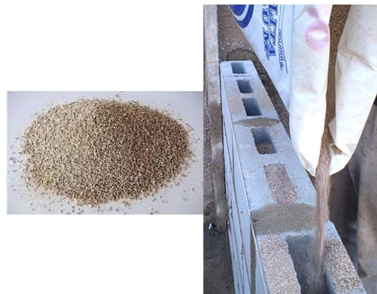
GRAFICO 44 Pared de Bloque Con Aislante
