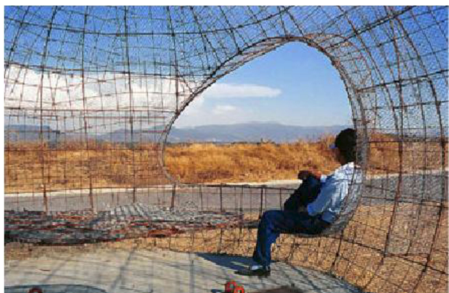
GRAFICO 47 Paredes de Concreto Reforzado
