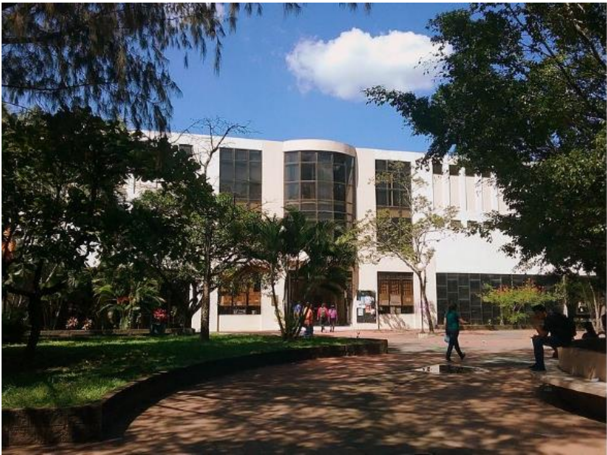
Figura S-1. Edificio Administración académica-FIA
