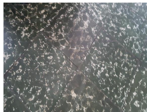
Levantamiento de piso en unidad de lesiones y afecciones medulares-ULAM
