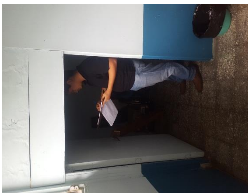
Puerta en la unidad de terapia ocupacional no cumple con las dimensiones mínimas requeridas por el decreto 89.
