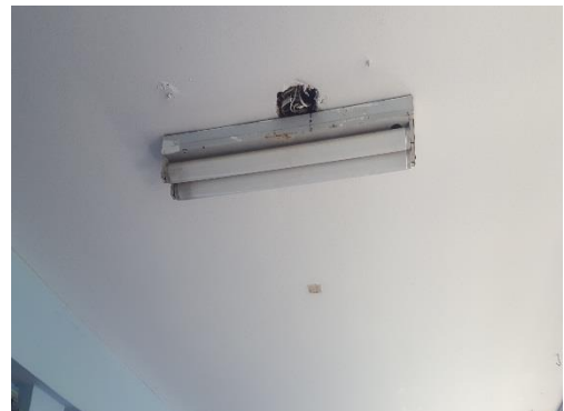
Conexiones de lámpara expuesta en unidad de terapia ocupacional
