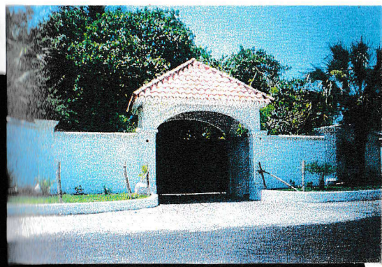
TECHOS DE TEJA CON ESTRUCTURA DE MADERA
