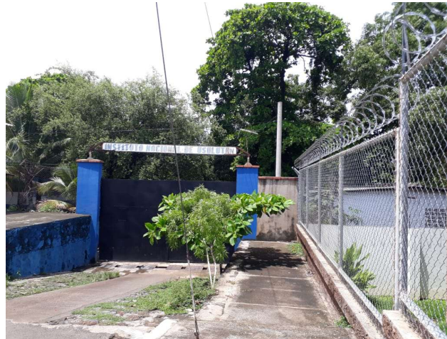
IMAGEN 52. Vista del acceso secundario/Fuente propia
