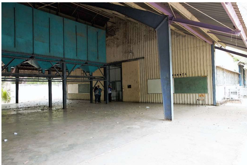
IMAGEN 53. Vista de área del bachillerato en música del instituto de Usulután/Fuente propia
