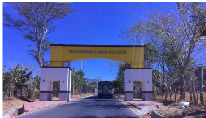
9- Acceso al municipio de agua caliente
