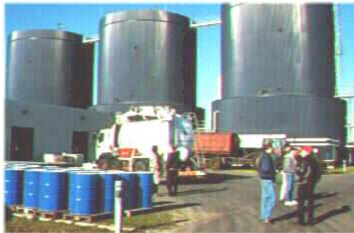
FIGURA 1.4 Ejemplo de Digestores Industriales
