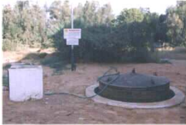
FIGURA 1..2 Ejemplos de Digestores Hindúes
