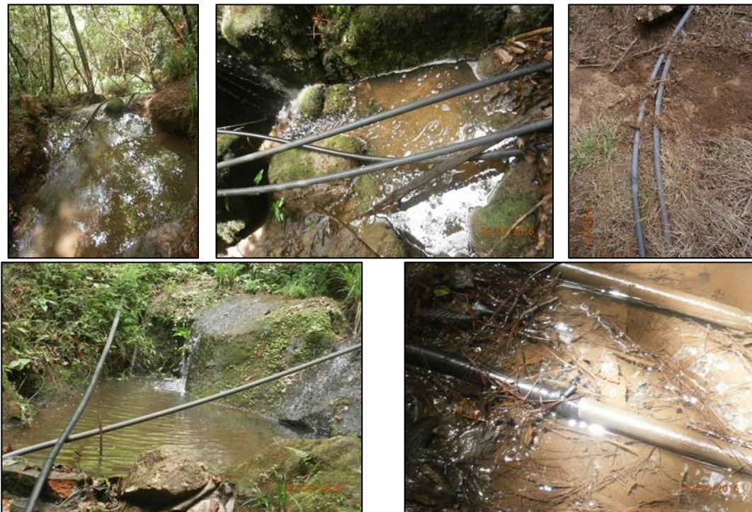
Figura 12. Tubos de movilización del agua por gravedad hasta las parcelas de los productores.
