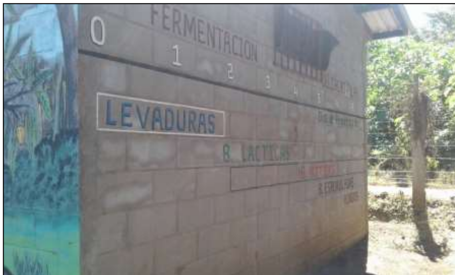
Imagen 3: Fachada del centro de acopio
