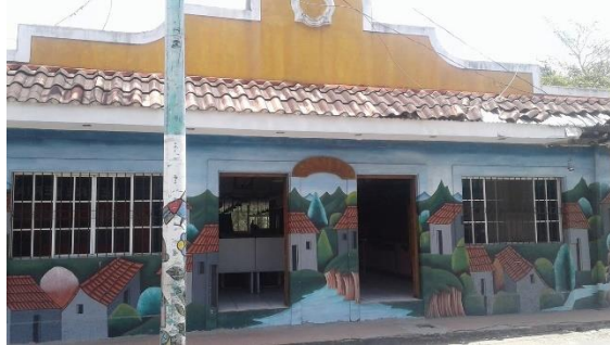
Ilustración 23: Fachada del hotel
