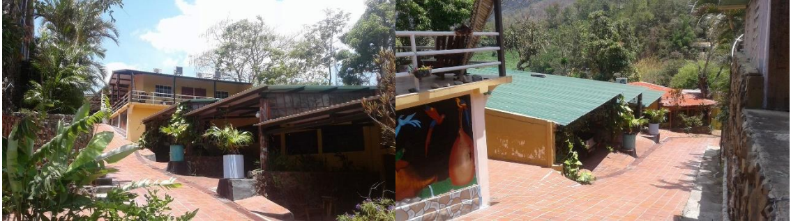
Ilustración 26: Rampla hacia habitaciones y piscina
