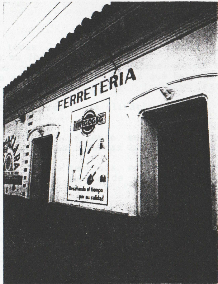
DETALLE DE ALEROS Y ELEMENTOS EN RELIEVE ALREDEDOR DEL MARCO DE LA PUERTA
