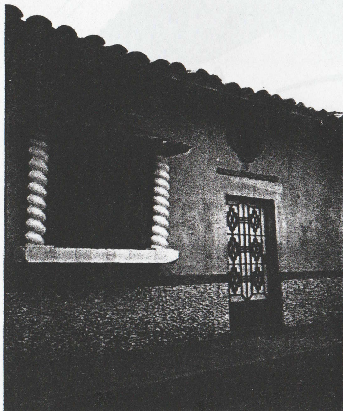
VENTANA DE MADERA CON BALCON DE HIERRO FORJADO Y PEQUEÑAS COLUMNAS ADOSADAS A LA FACHADA
