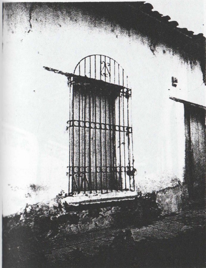
VENTANA DE MADERA DE DOBLE HOJA CON BALCON DE HIERRO FORJADO Y ALFEIZAR DE MEZCLA
