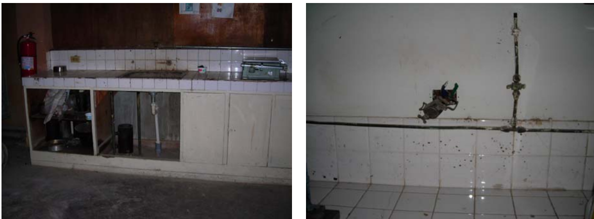
Figura 3.41: Imágenes de aspectos de seguridad del área de prácticas de suelos y materiales del Laboratorio de la Escuela de Ingeniería Civil
