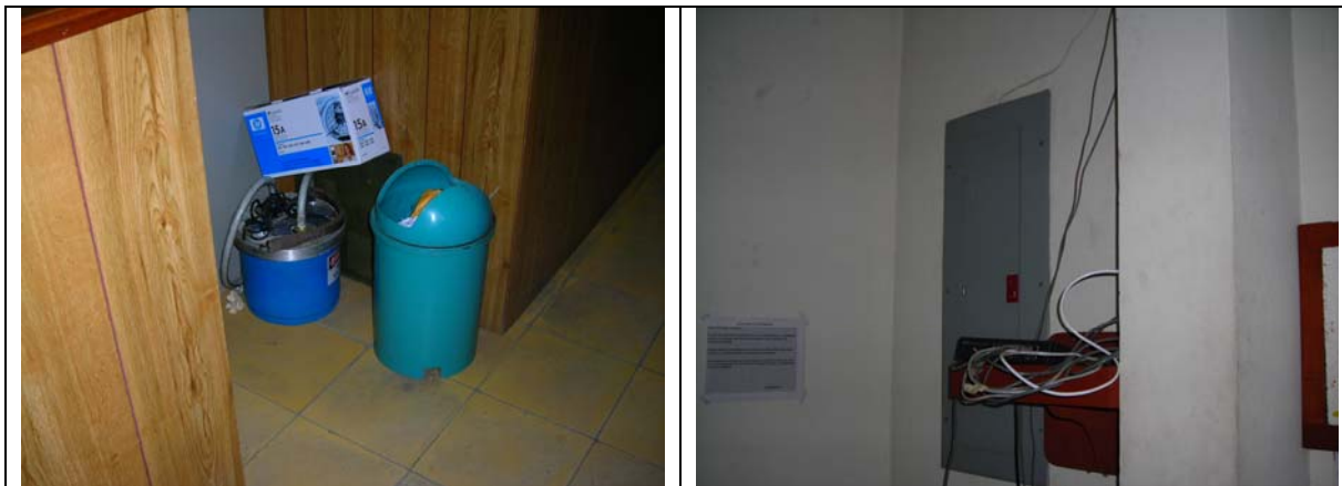
Figura 3.58: Imágenes del aspecto de orden, limpieza y seguridad del área de oficina – archivos del CIAN
