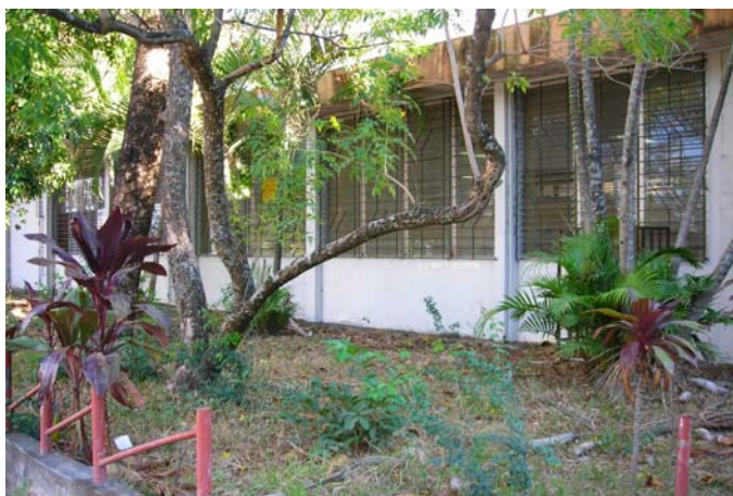
Figura 1.1 Vista del Laboratorio de la Escuela de Ingeniería Química
