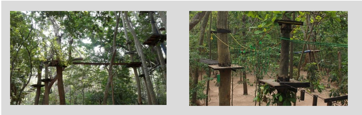
Ilustración 34 Estructura en buen estado
