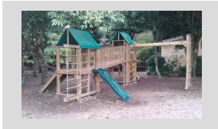
Ilustración 46 Estructuras de madera en buen estado
