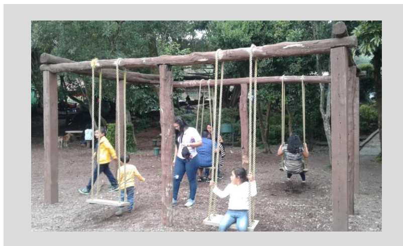
Ilustración 47 Estructuras en buen estado
