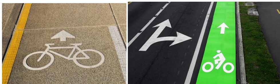
Ilustración 66 Señalización Horizontal de ciclo vía
