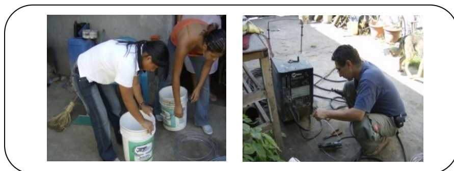
Figura 4 Moldeo y soldadura de varillas de \frac{3}{4} de alambre galvanizado.
