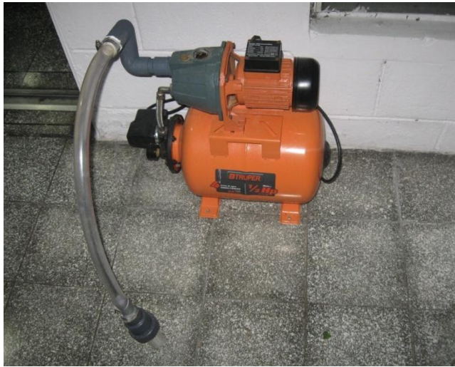
Figura 2.8 Bomba y manguera de succión con válvula de pie
