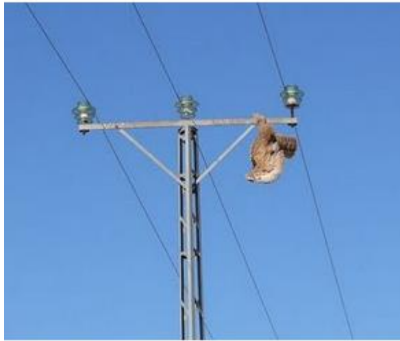
Imagen 2: Pájaro que muere electrocutado al tocar las líneas de distribución
