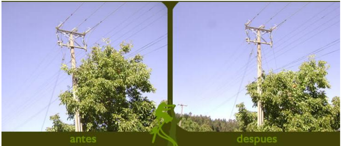
Imagen 1: Ejemplo de riesgo de los árboles y de cómo remediarlo a través de la poda.
