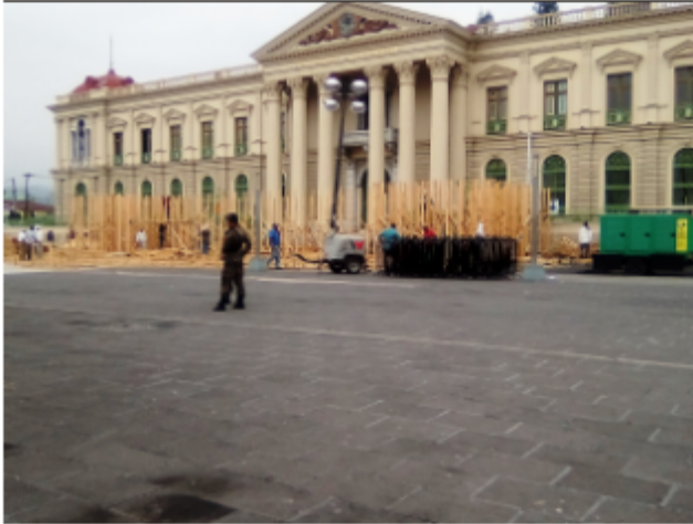
Los trabajos comenzaron el lunes en la mañana. Se trabaja día y noche.
