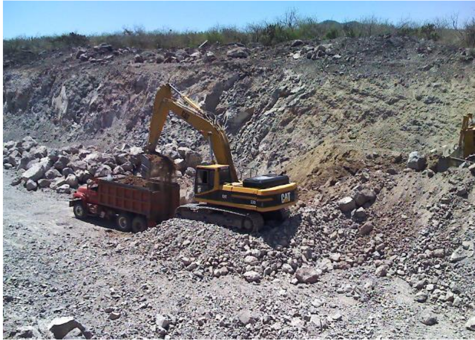
Imagen 56: Acarreo de material, producto del corte en roca suelta.
