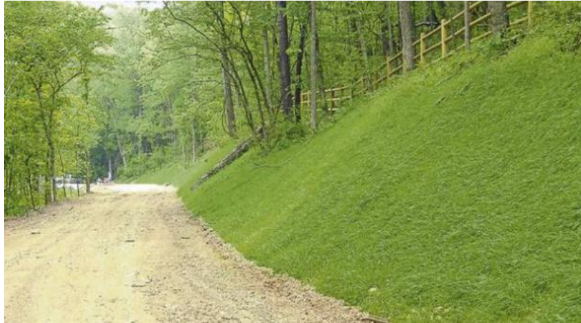
Imagen 60: Protección de talud utilizando césped.
