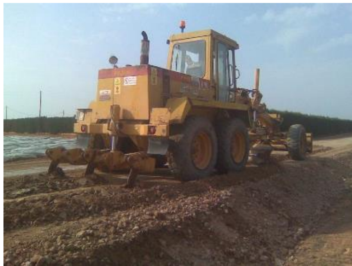
Imagen 35: Nivelación de un terraplén.
