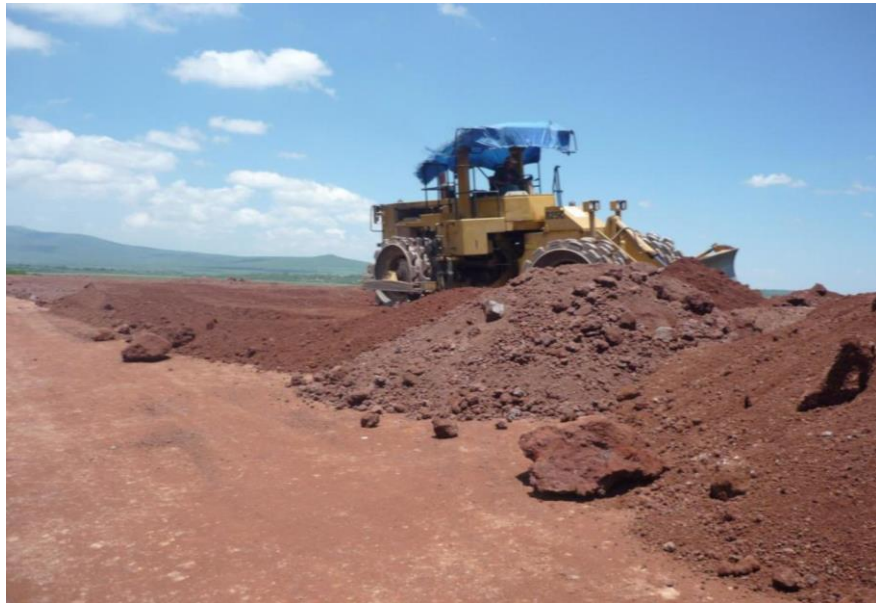
Imagen 47: Compactación del cuerpo del terraplén con rodo pata de cabra.
