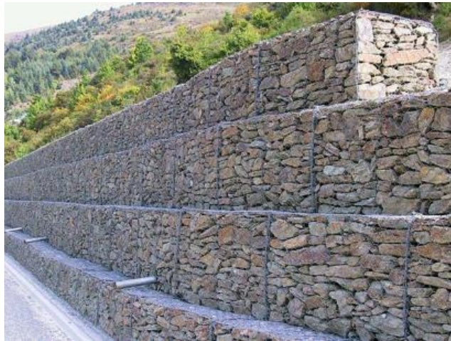
Imagen 69: Muro de gaviones.
