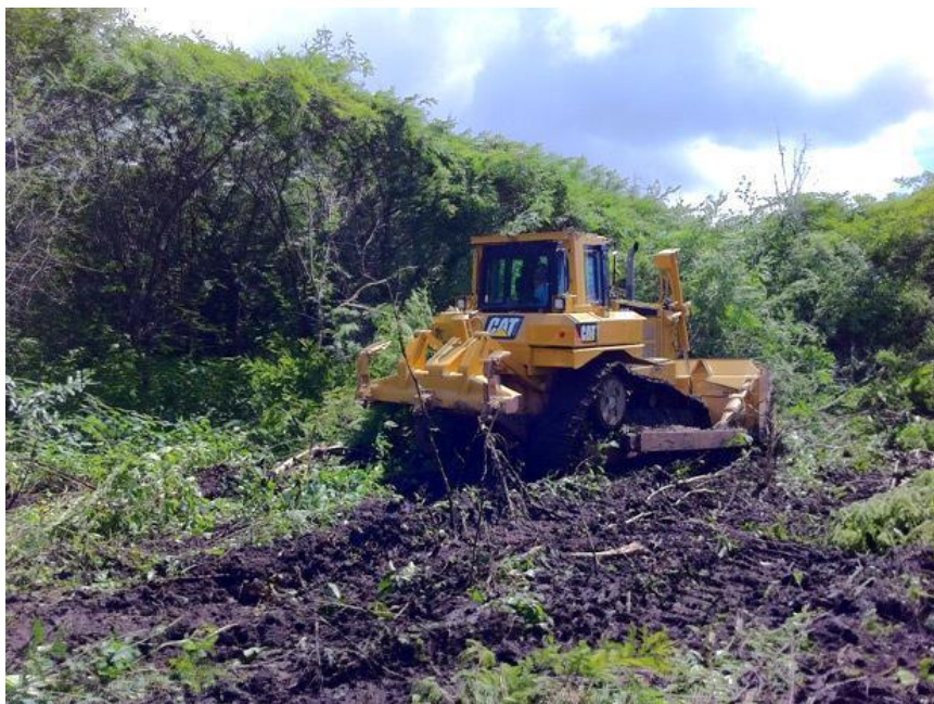
Imagen 13: Tractor realizando el proceso de roza.
