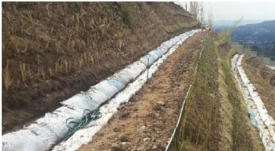
Imagen 76: Contracunetas sucesivas, construidas en talud de corte.
