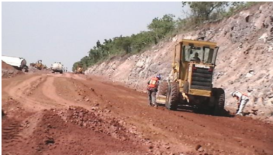
Imagen 59: Tendido de capa subrasante en corte.
