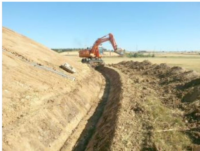
Imagen 75: Construcción de cuneta.
