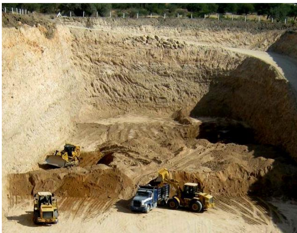
Imagen 40: Banco de préstamo, excavación y carga.
