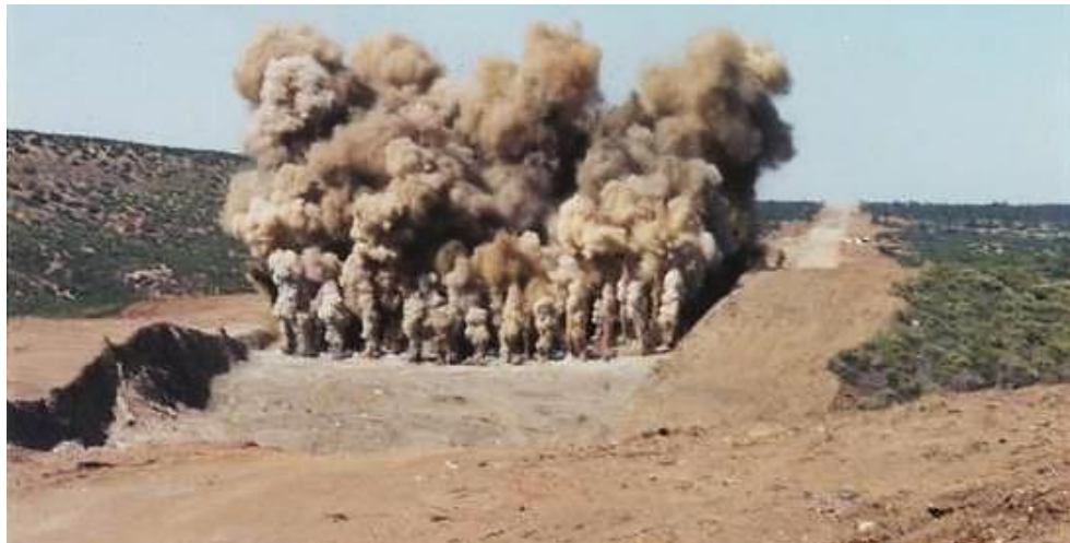
Imagen 53: Voladura con explosivos.
