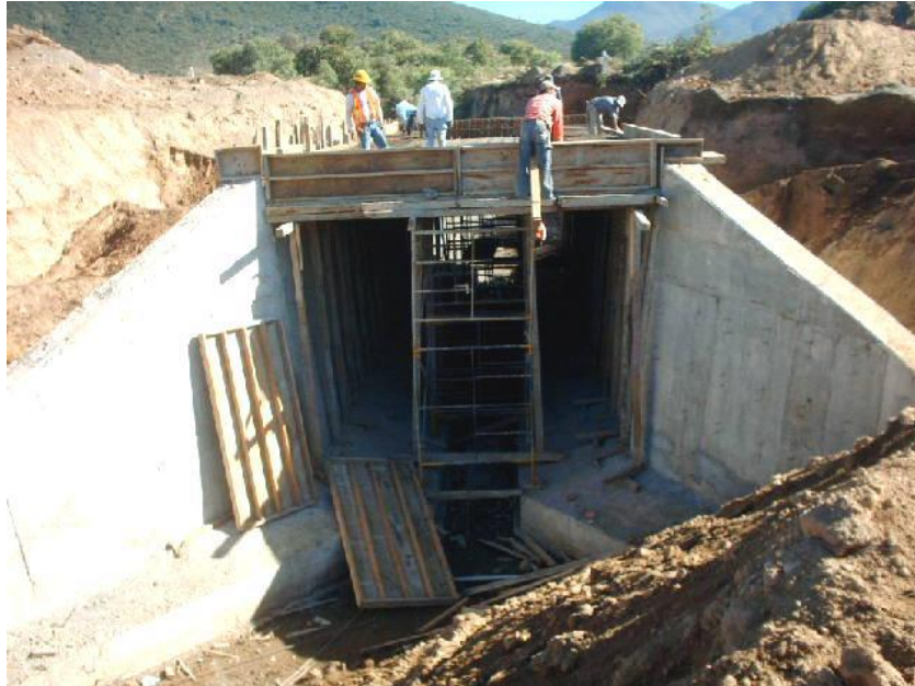
Imagen 83: Armado del acero de refuerzo en la losa.
