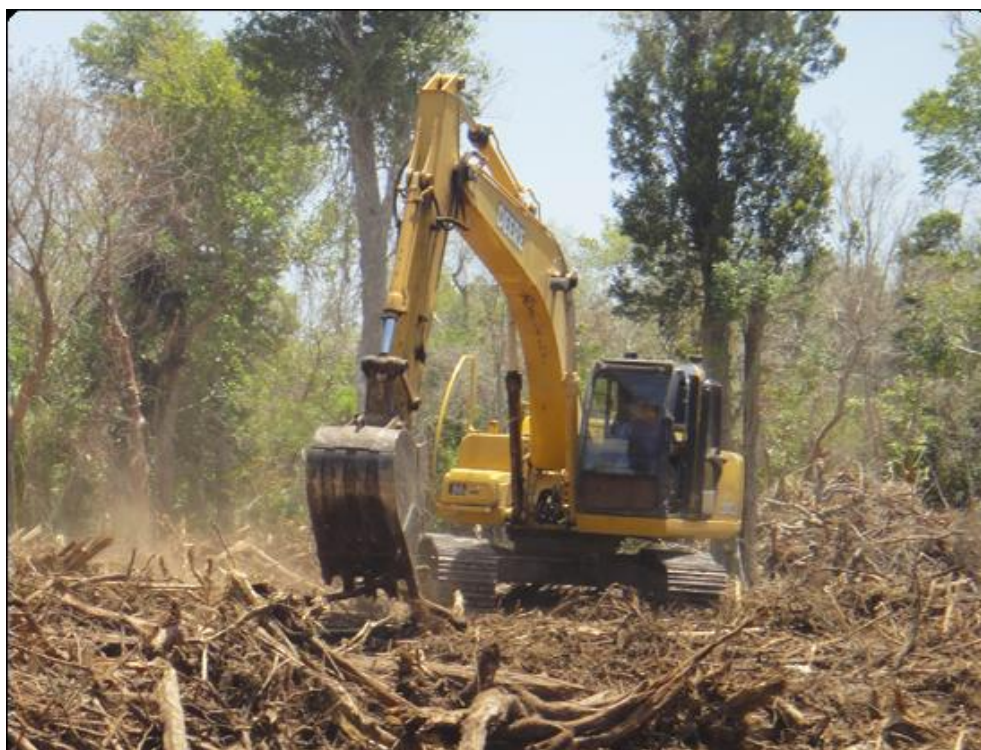
Imagen 11: Pala excavadora cortando árboles.
