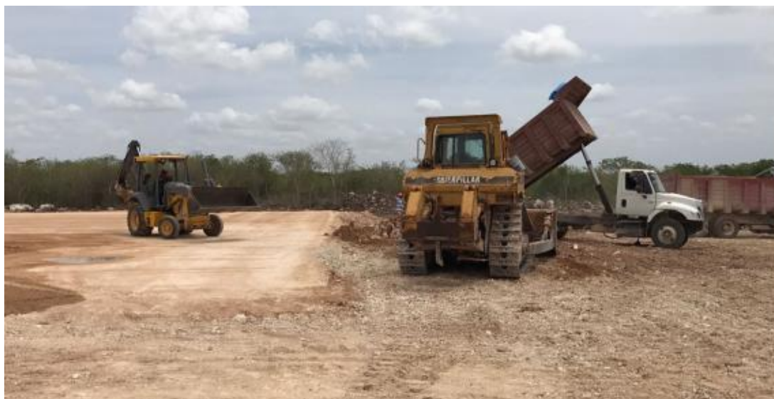
Imagen 3: Trabajo de conservación de terracería. Renivelación y tendido de suelo, en un proyecto de edificación.
