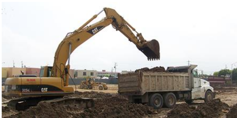
Imagen 2: Inicio de los trabajos de terracería.
