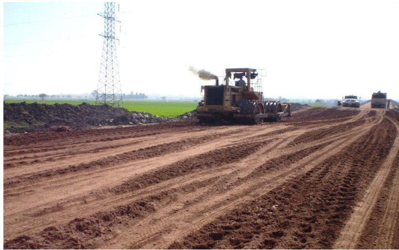
Imagen 36: Formación de terraplén con material compactable.
