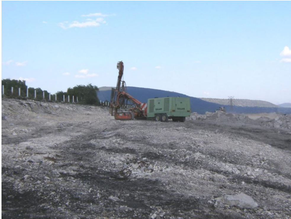
Imagen 51: Barrenación, para la colocación de explosivos.
