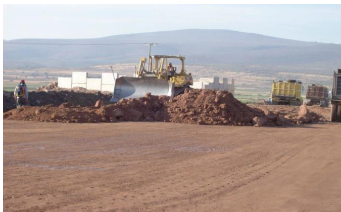
Imagen 43: Formación de terraplén.
