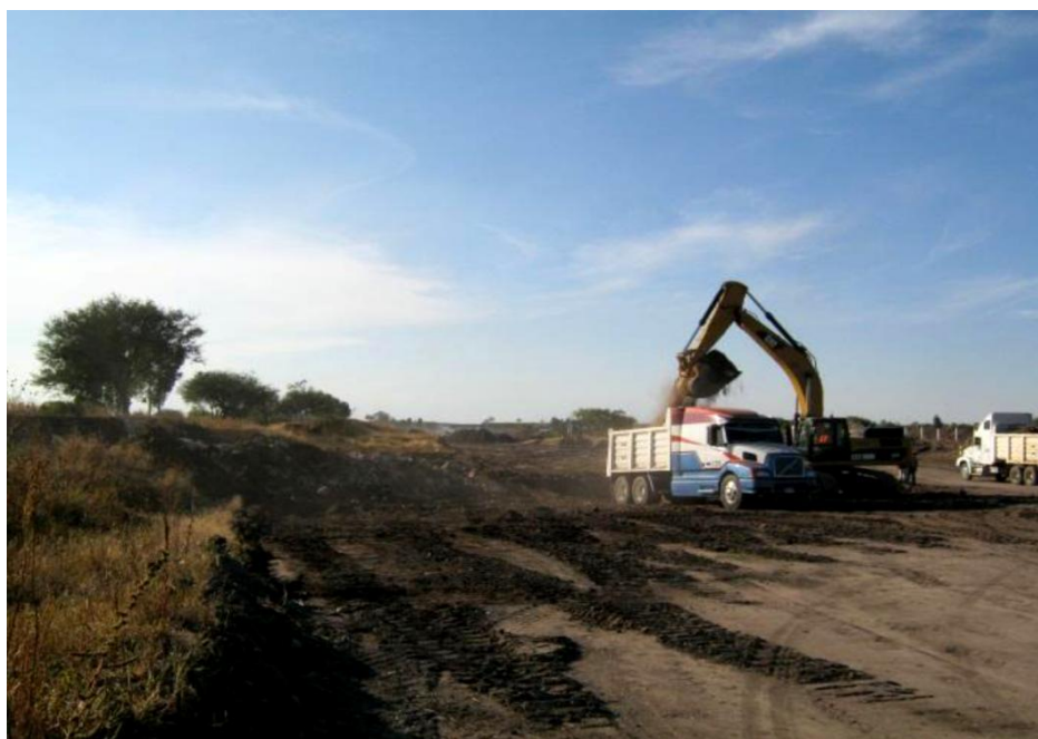
Imagen 14: Acarreo de material, producto del desmonte, para su disposición final.
