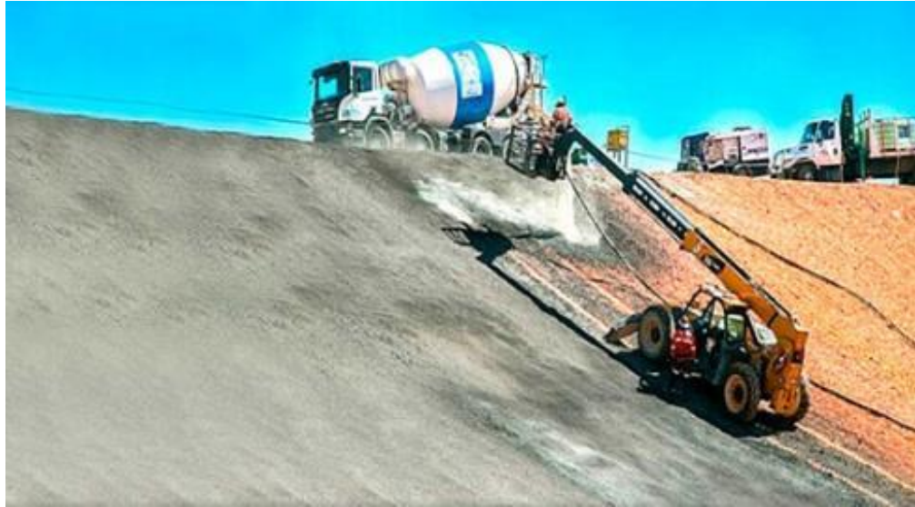
Imagen 68: Aplicación de concreto lanzado.
