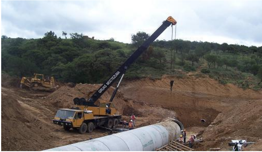
Imagen 81: Colocación de tubo en obra de drenaje.
