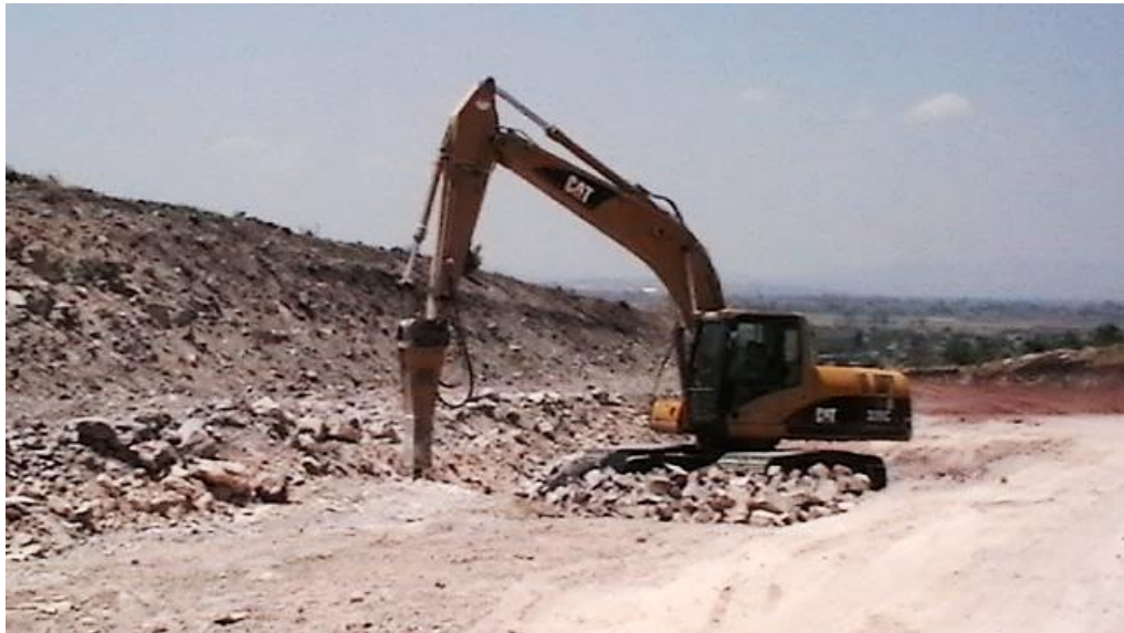
Imagen 55: Realización de excavación en roca suelta.
