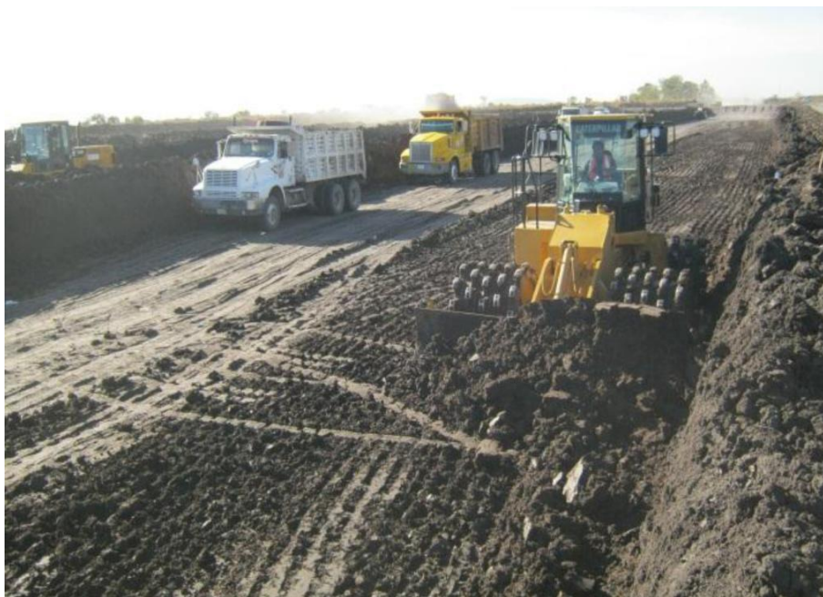
Imagen 38: Compactación del terreno natural que queda después del despalme.
