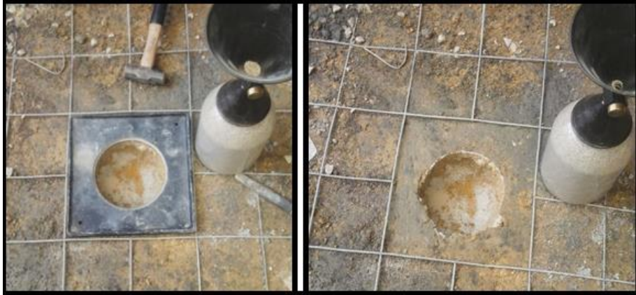
Imagen 86: Muestra del agujero resultante después de la excavación.
