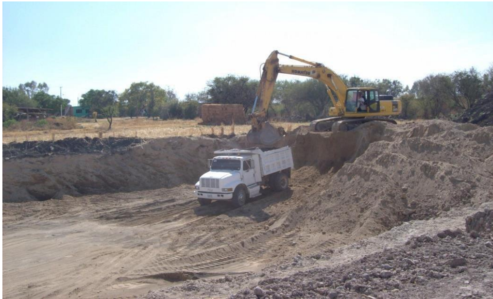
Imagen 39: Carga y acarreo de material de préstamo.
