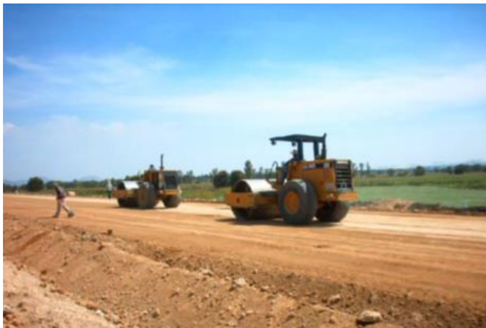
Imagen 49: Compactación de la capa subrasante.
