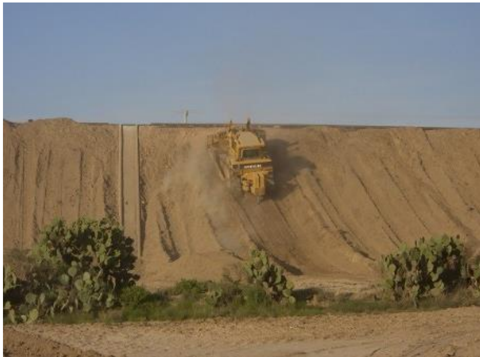
Imagen 66: Arroje de taludes con material producto del despalme.
