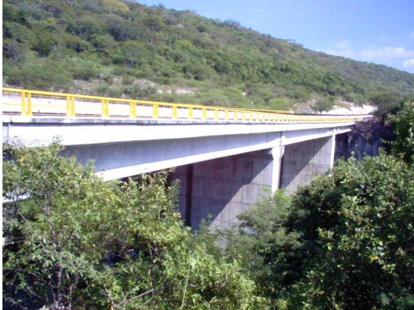
Imagen 84: Puente sobre vigas.
