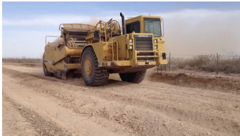
Imagen 45: Motoscrepa, nivelando la capa de suelo.
