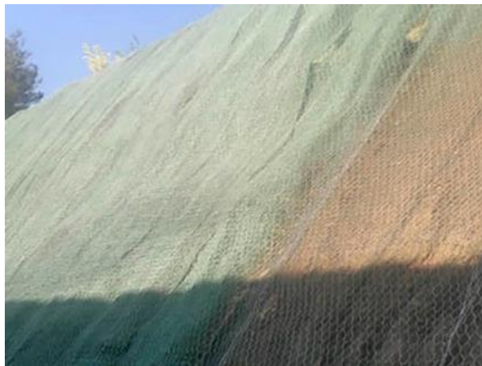
Imagen 63: Protección de talud con malla metálica.
