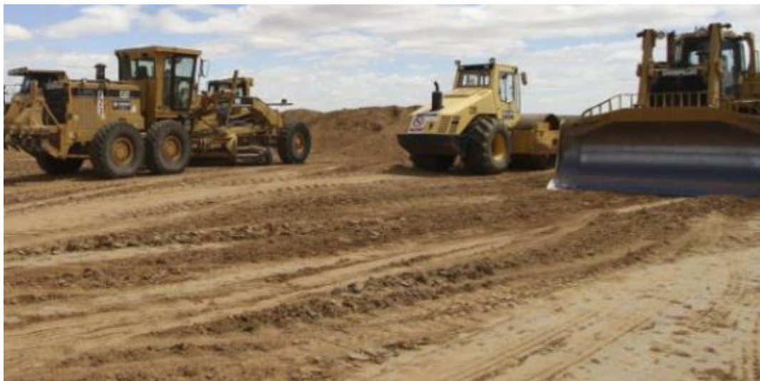
Imagen 15: Terreno en que se ha concluido el proceso de terracería.
