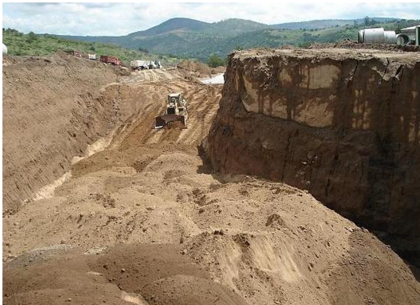
Imagen 58: Formación de corte, utilizando bulldozers.
