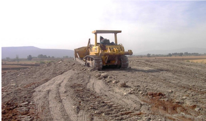
Imagen 44: Tractor sobre orugas, tendiendo material para la conformación del cuerpo del terraplén.
