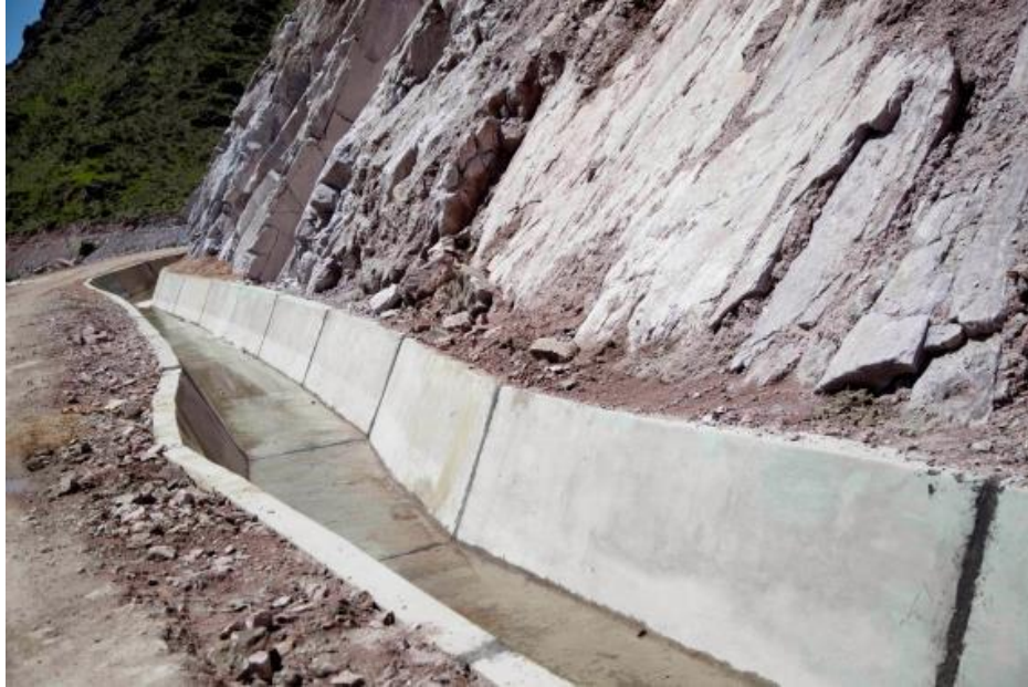
Imagen 77: Canal de encauzamiento, construido en la base de un talud.
