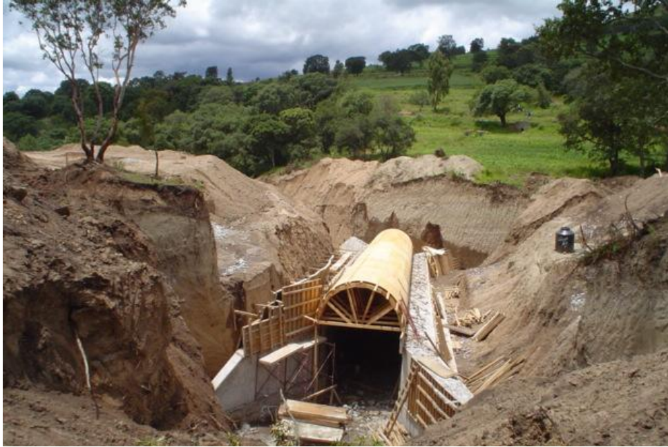
Imagen 82: Aspecto general de la colocación de cimbra en la estructura de la bóveda.
