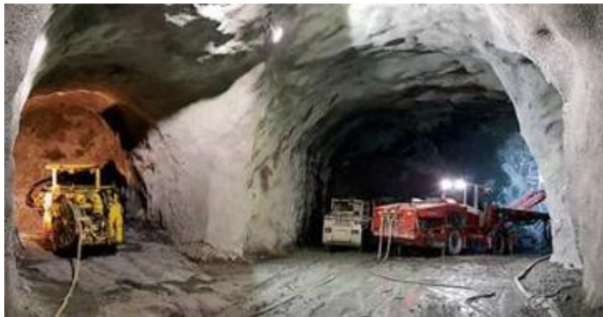
Imagen 72: Máquina barrenadora, colocación de explosivos en túneles.
