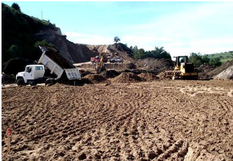
Imagen 42: Corte y formación de terraplén.
