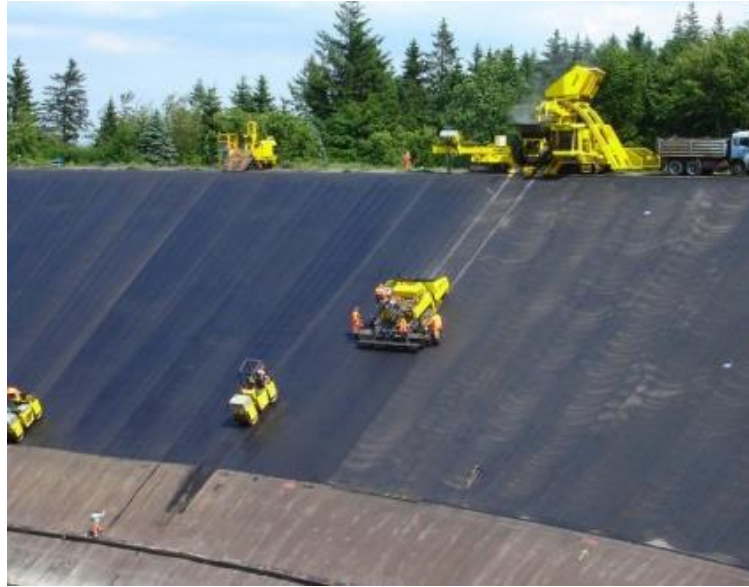
Imagen 64: riego asfáltico para protección de taludes.
