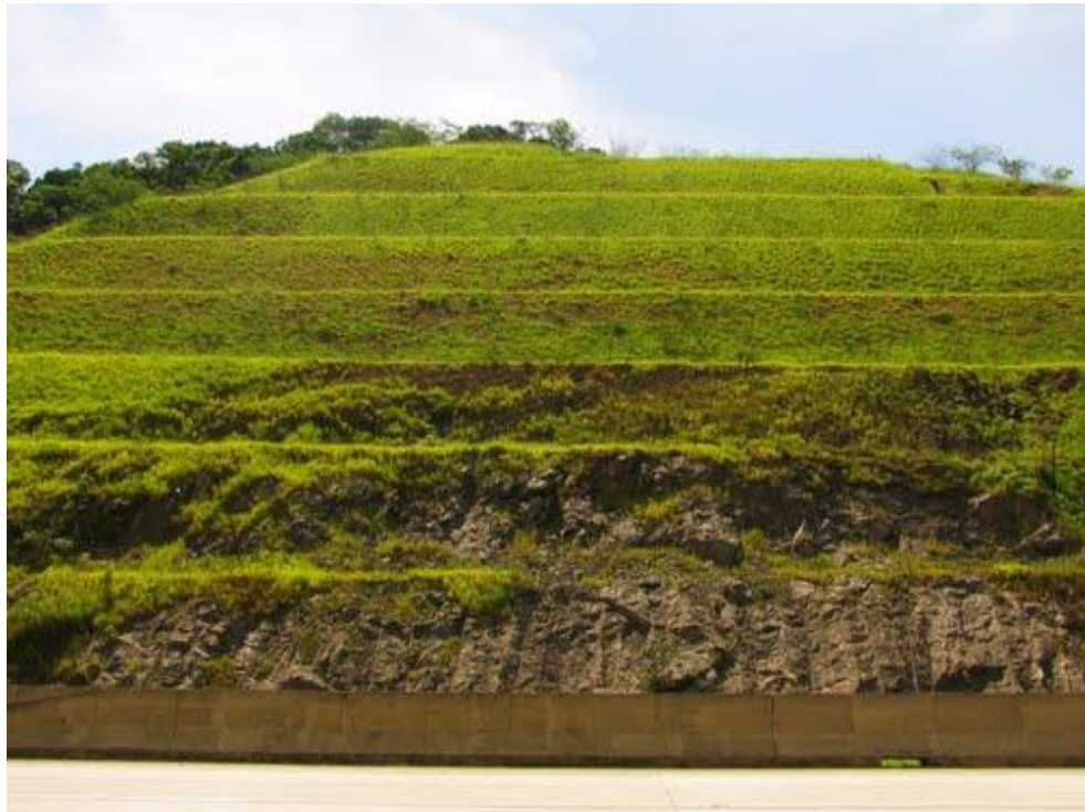
Imagen 67: Talud estabilizado con bermas.
