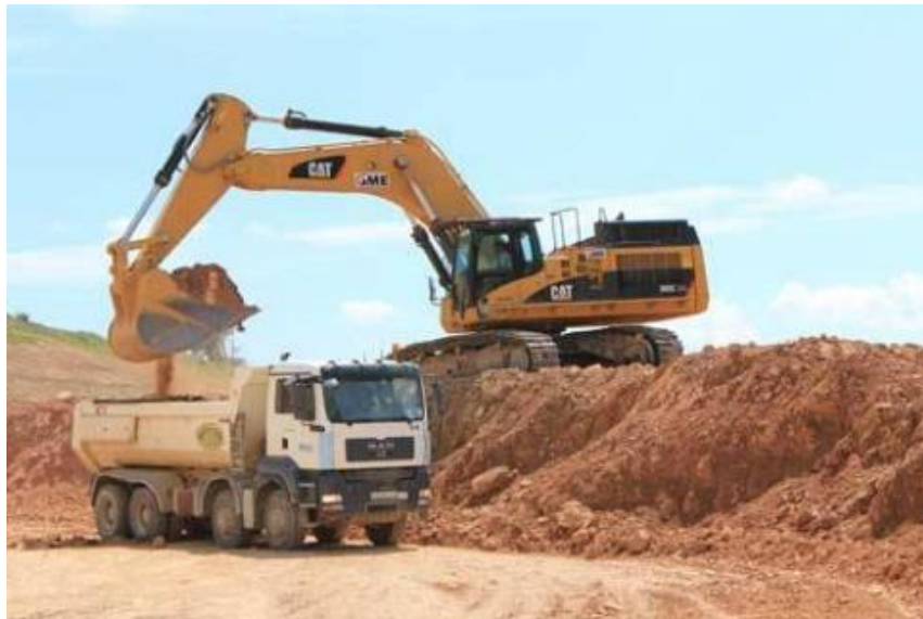
Imagen 57: Formación de corte, utilizando excavadora.
