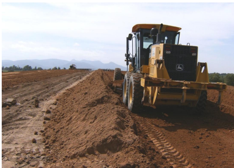
Imagen 46: Conformación de la capa subrasante, con motoniveladora.
