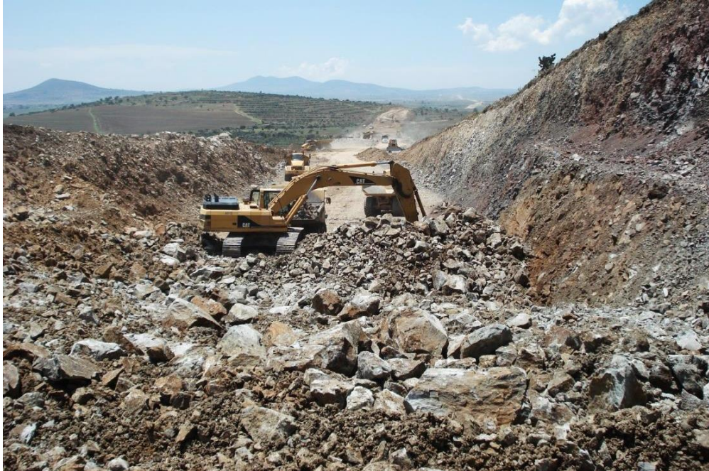
Imagen 54: Extracción del material de corte, después de la voladura.
