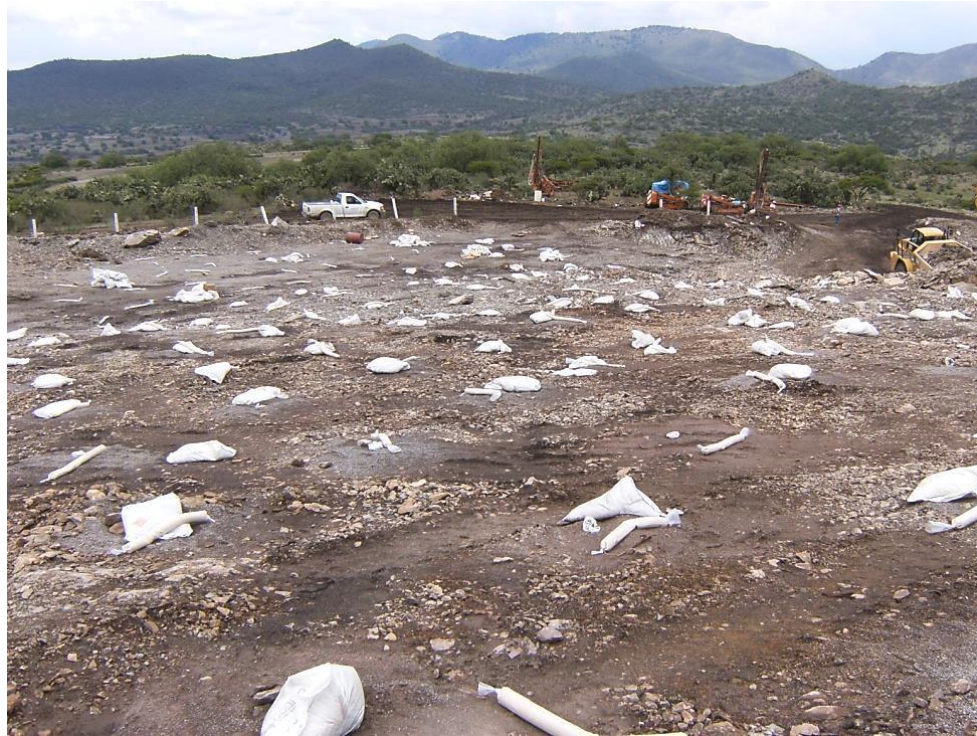
Imagen 52: Colocación de explosivos en las perforaciones.
