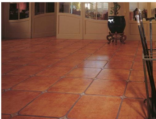
Figura No. 15 Ladrillo de piso cerámico rústico, utilizado en el interior de una vivienda
