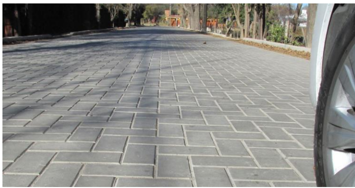
Figura No. 7 Adoquines utilizados como capa de rodadura de un pavimento articulado.
