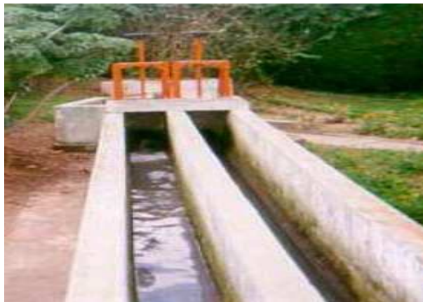
Figura 5.3. Canal sedimentador
