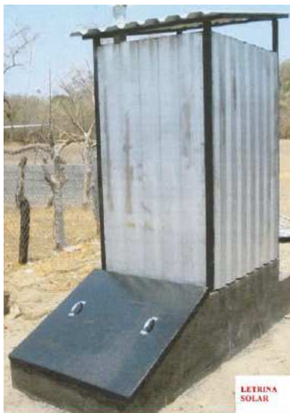
Figura 5.6. Sanitario con Calentador solar
