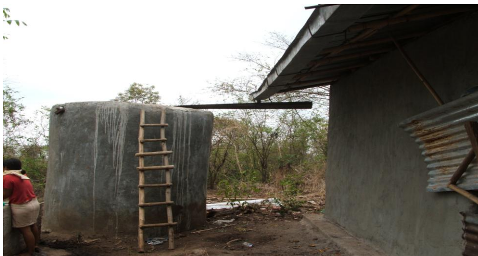
FIGURA 4.2 SISTEMA DE CAPTACIÓN DE AGUA LLUVIA DE COMUNIDAD EL MANGO (Fuente: Propia)
