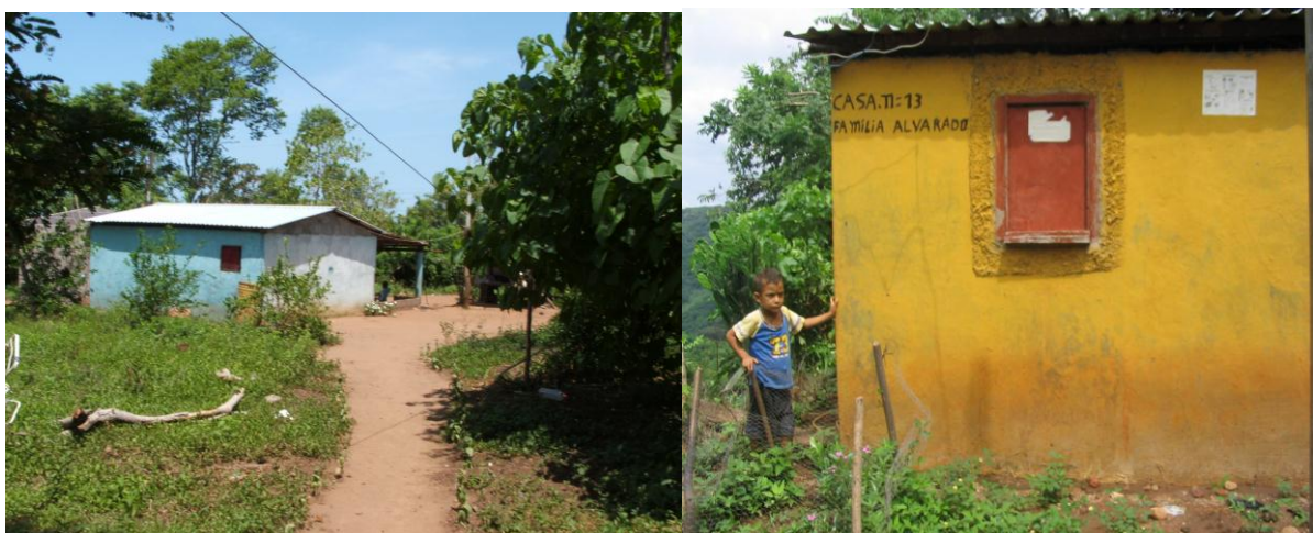
FIGURA 2.8 VIVIENDAS TÍPICAS DE COMUNIDAD EL COYOLAR (Fuente: Propia)
