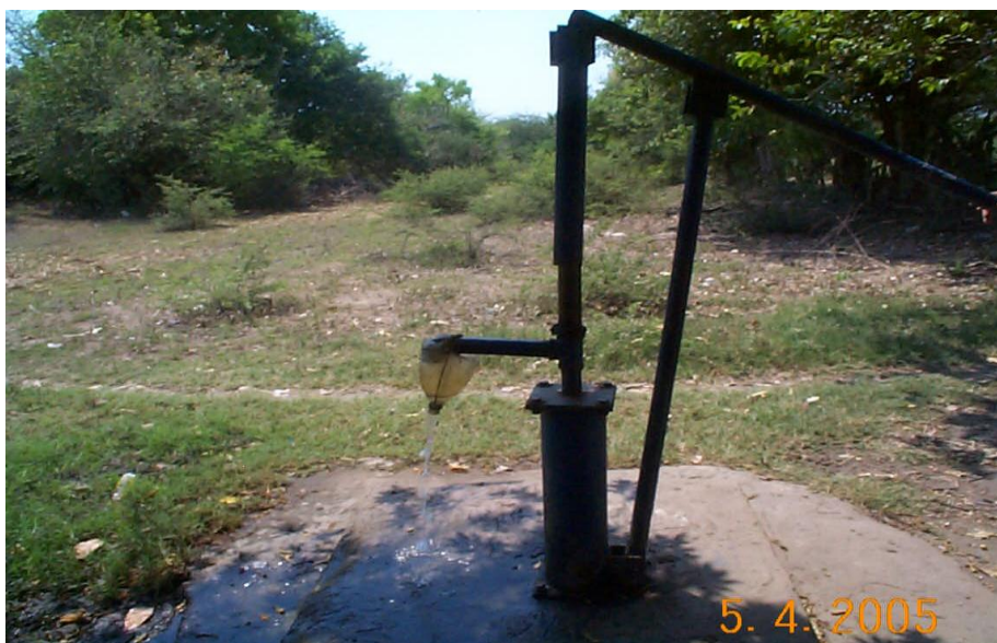
FIGURA 5.1 SISTEMA DE EXTRACCIÓN DE AGUA COMUNIDAD BOCAPOZA (Fuente: Propia)
