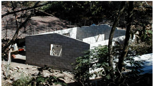
Ilustración 7: Construcción de casas de sistema mixto
