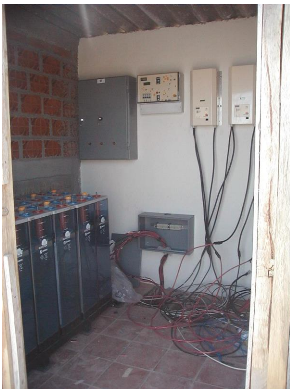
Ilustración 3: Equipo Central Fotovoltaico instalado en El Alto
