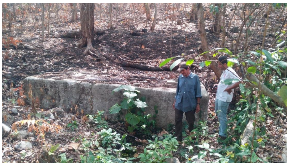
Fotografía 2. Levantamiento de inventario de puntos de agua. Toma de datos de manantiales en la zona. Estructura de captación en manantial Qda La Pita , ubicado en el cantón el Zapote.
