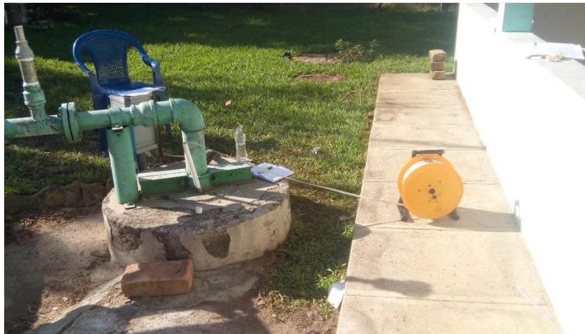
Fotografía 4. Toma de profundidad del nivel piezométrico del pozo perforado ARAS.
