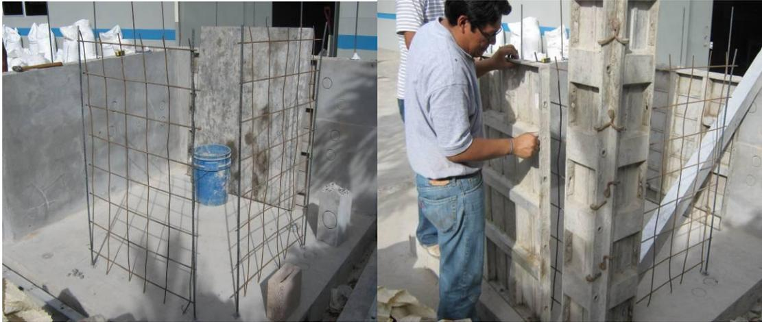
Figura 3.44. Colocación de mallas para evitar contracciones por temperatura
