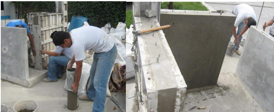
Figura 3.51: desmoldado de cilindros y pared
