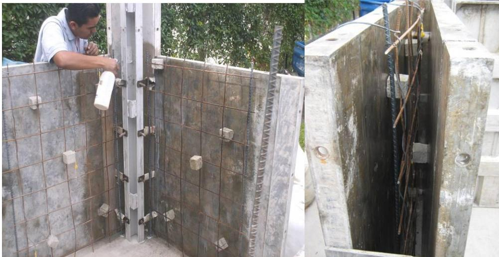
Figura 3.45 Colocación de desencofrante y helados para mantener espesor constante
