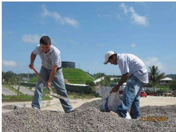
Figura 3.8 Muestreo de agregados.
