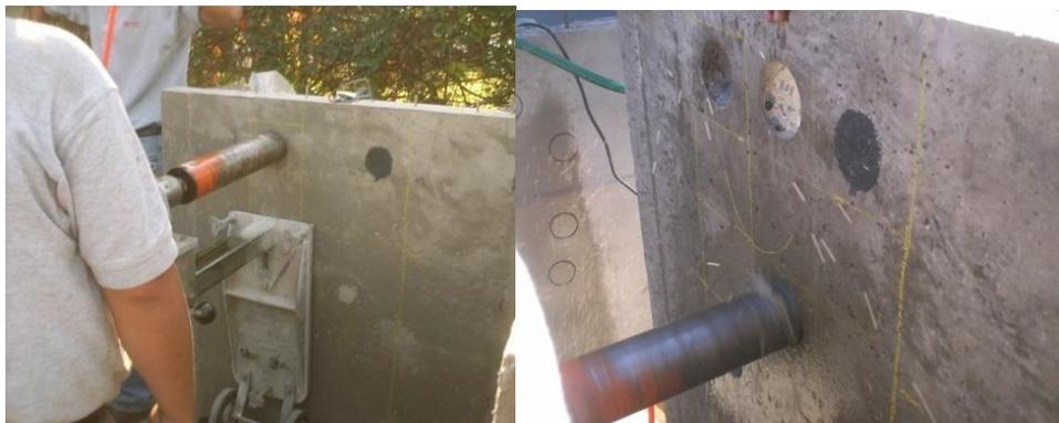
Figura 3.71 extracciones de núcleos de las paredes
