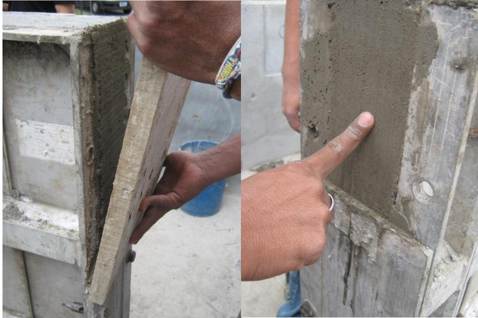
Figura 3.50: Exploración de las condiciones del concreto antes del desmoldado
