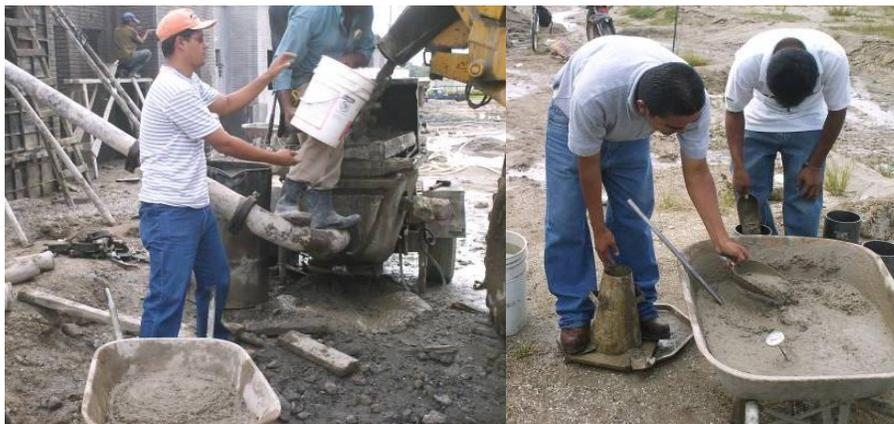
Figura 3.2 Muestreo de la mezcla de concreto y ensayos de revenimiento y temperatura en la muestra de concreto
