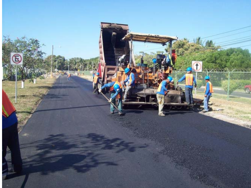
Figura 2-4. Proceso de colocación de asfalto modificado, mezcla asfáltica en caliente. Calles de El Puerto de Acajutla.
