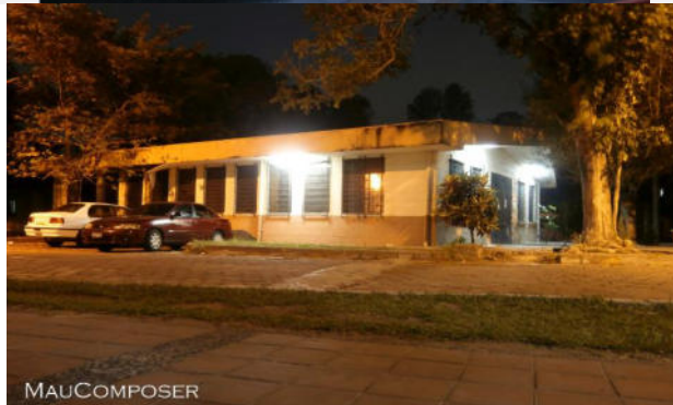
Edificios de Unidad de Ciencias Básicas.
