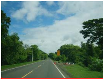
Figura 3.1.4.1 Camino rural de dos carriles con hombro pavimentada y vegetación rala.
